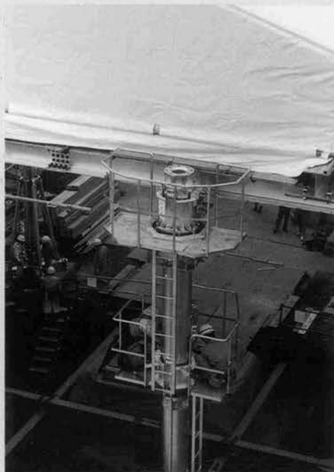
⇨ 仮設屋根の上昇装置
