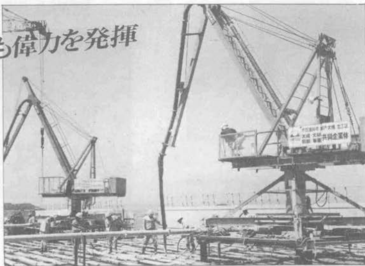
(本四架橋現場設置例)
