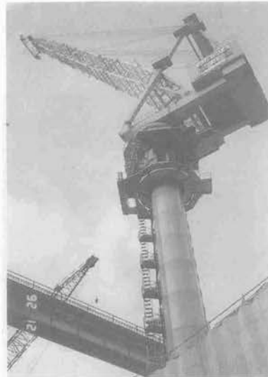
写真-4 建築用タワークレーン
