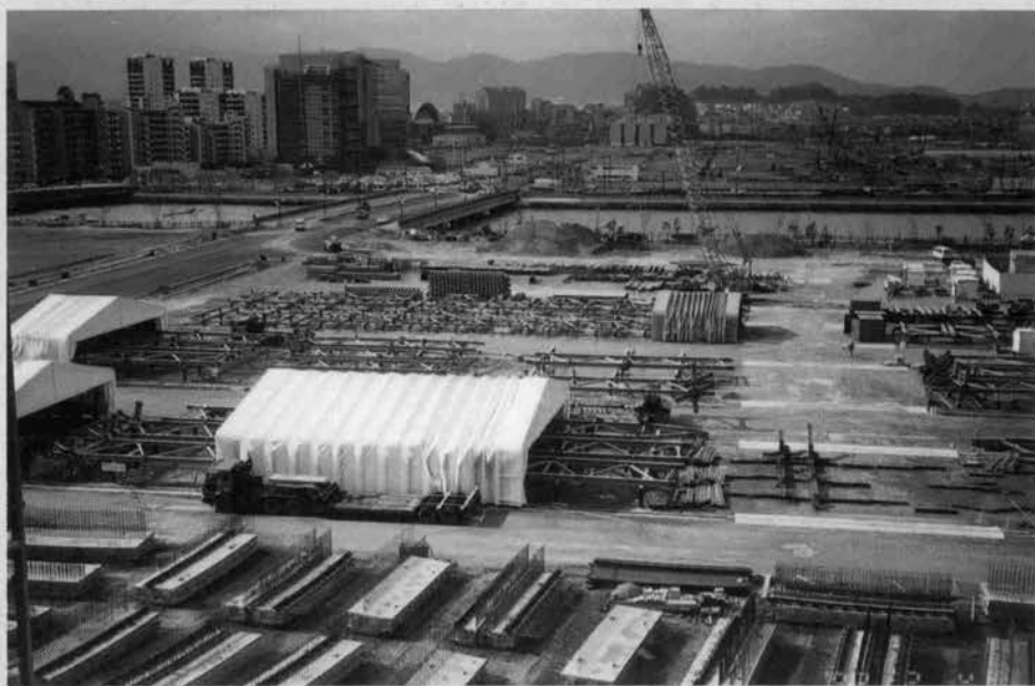
⇨ サイト塗装工場における仮設テント
