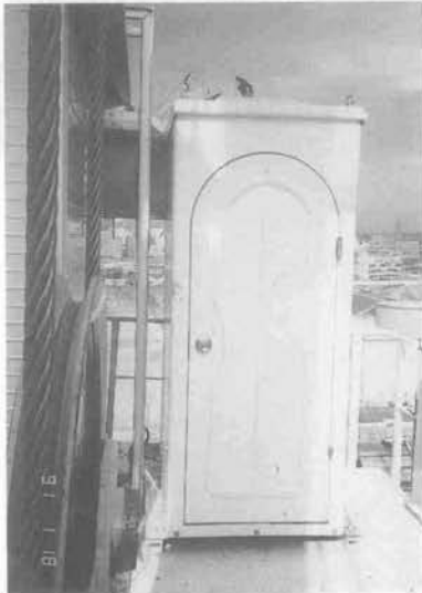
写真-3 建築用タワークレーン上に設置された焼却式トイレハウス
