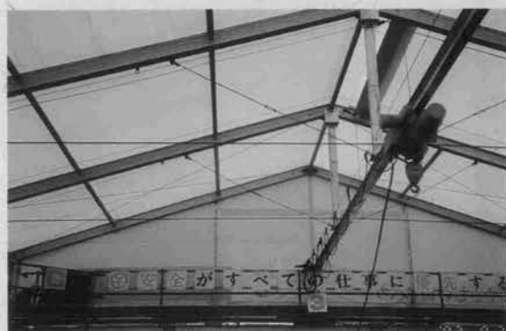
⇨ 仮設屋根の内部
