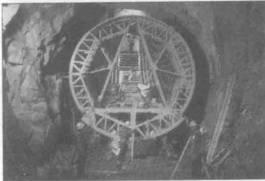
写真—1 直径7~8m 全断面コンカル型
