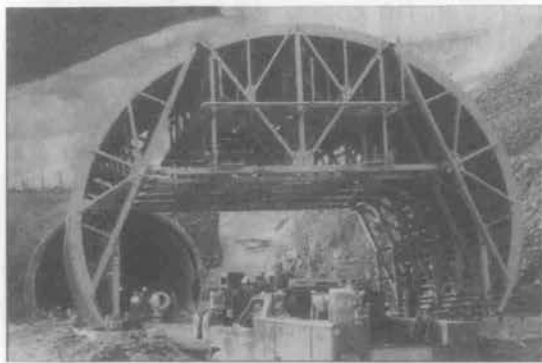
写真—2 幅11m、高さ8m、長さ9mの自動走行式
