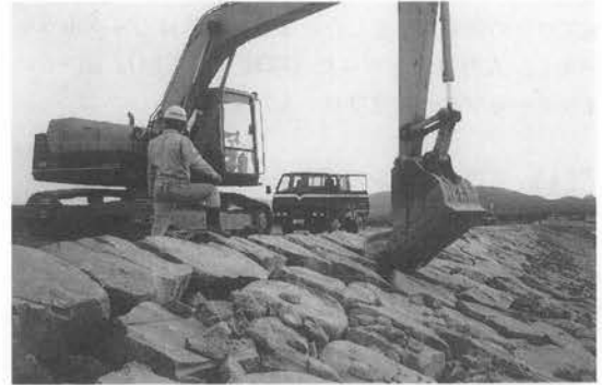
写真-13 リップラップの施工状況
