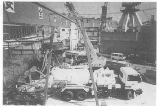
写真—3 吸引先端部形状試験状況
