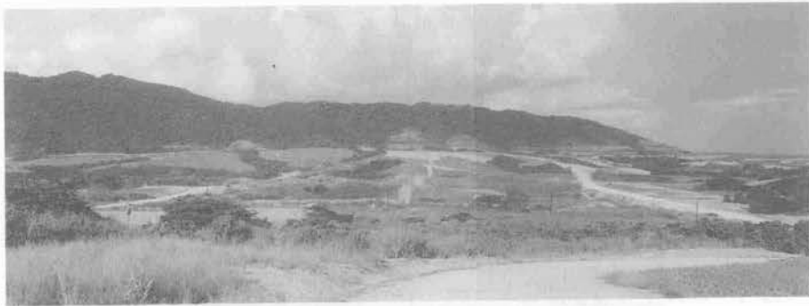
写真—3 着工前のダムサイト（左方が上流）昭和59年9月
