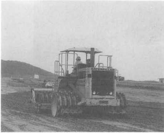
写真-7 タンピングローラによる転圧状況
