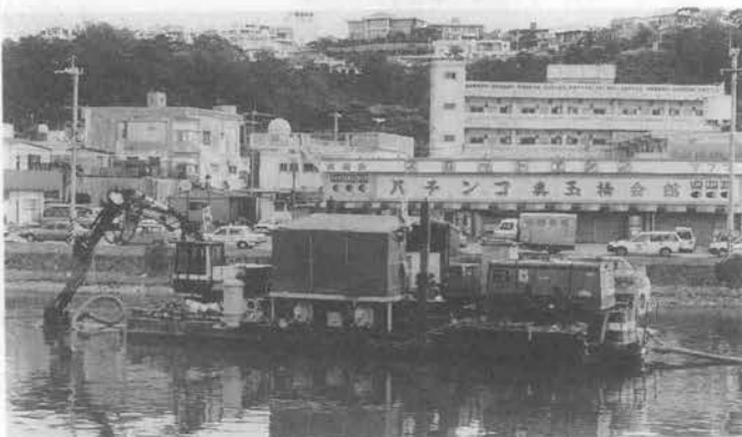
写真-7 本工事施工状況
