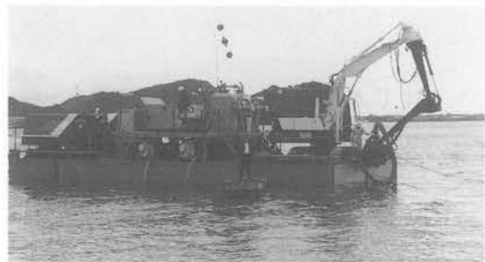
写真—4 試作浚渫システム機実用化試験
