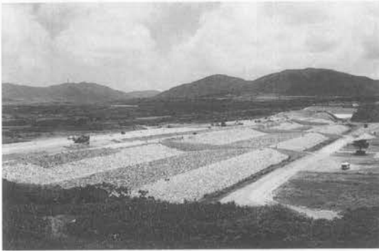
写真-12 透水ゾーンの盛立状況
