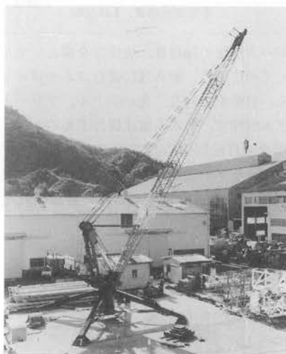
写真—11 石川島輸送機 M-50 ジブクレーン
