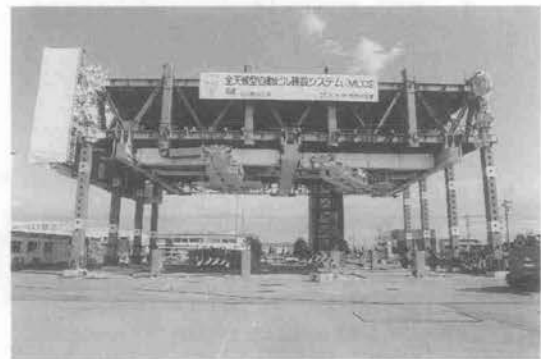
写真-1 クライミングフロア全景
