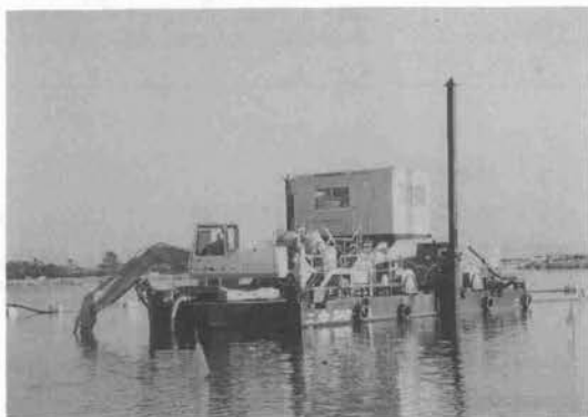
写真—1 浚渫システム機（カバダス4号機）
