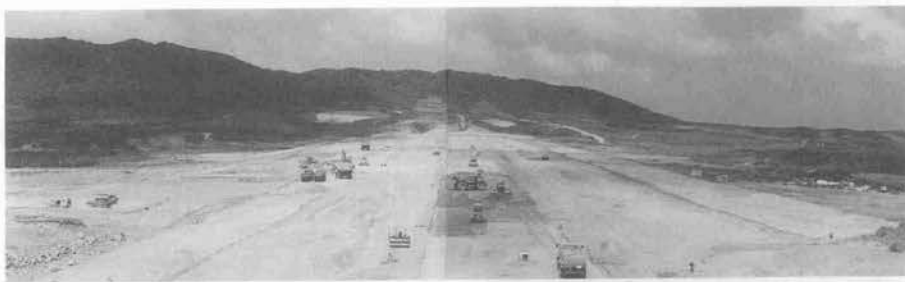
写真一五 盛立状況（右岸より左岸を望む）昭和62年7月
