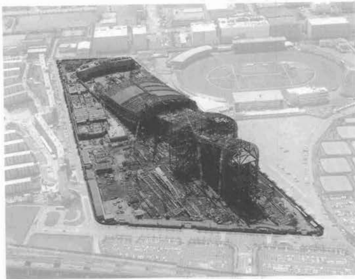
写真—1 鉄骨建方全景
