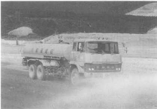
写真-8 散水状況
