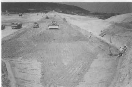
写真一六 遮水ゾーンの盛立状況
