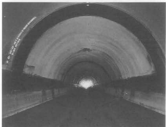
写真-2 鋼板内巻改修工事完了後のトンネル状況
