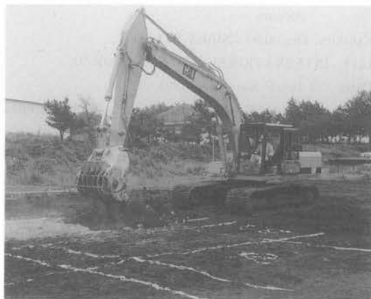
写真-1 本技術による地盤安定処理状況
