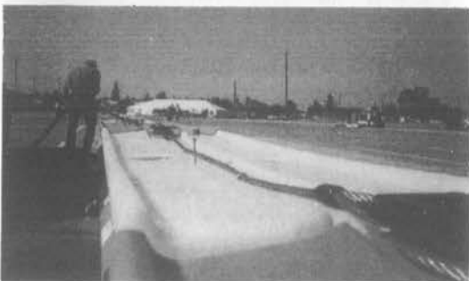
4人の作業員で防護柵を組立てる。
