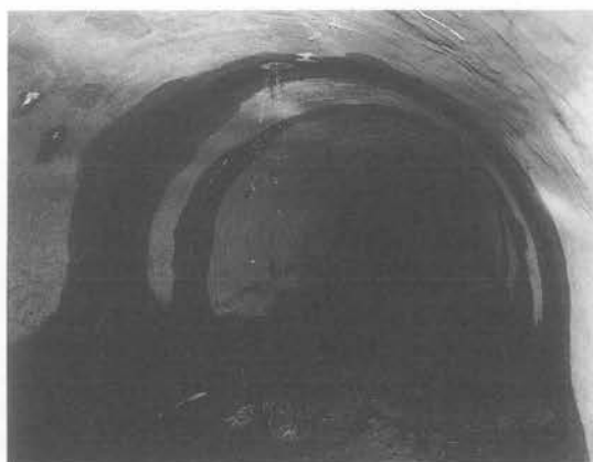
写真-1 施工前の既設トンネル状況
