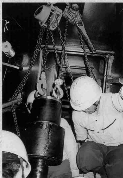
⇨ ケーブルの取付
