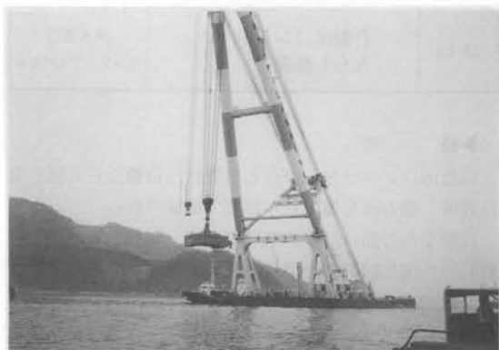
写真-2 鋼製シンカー設置状況
