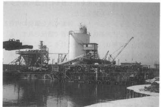
写真-1 盛土状況
