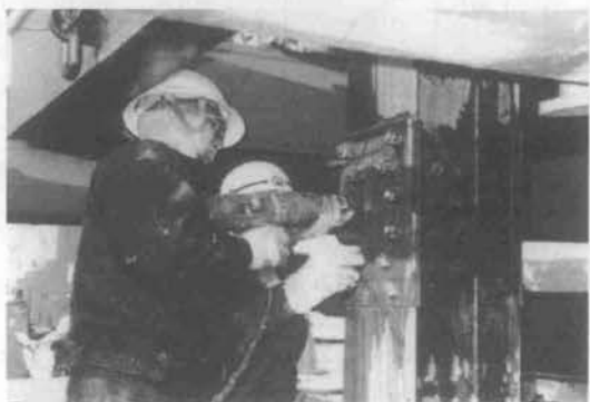
写真-3 継杭状況
