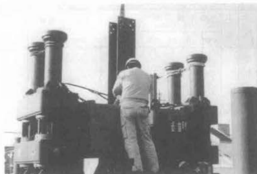
写真-2 杭建込み状況
