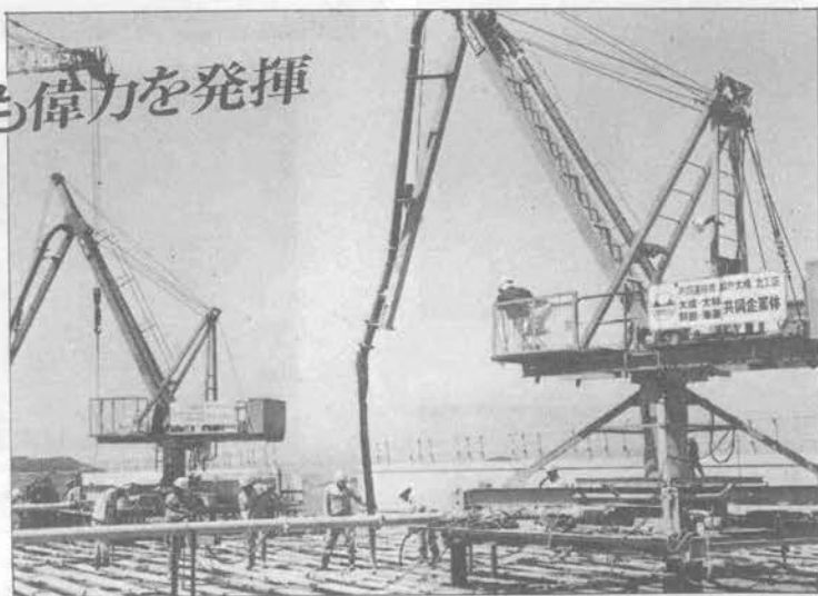
(本四架橋現場設置例)
