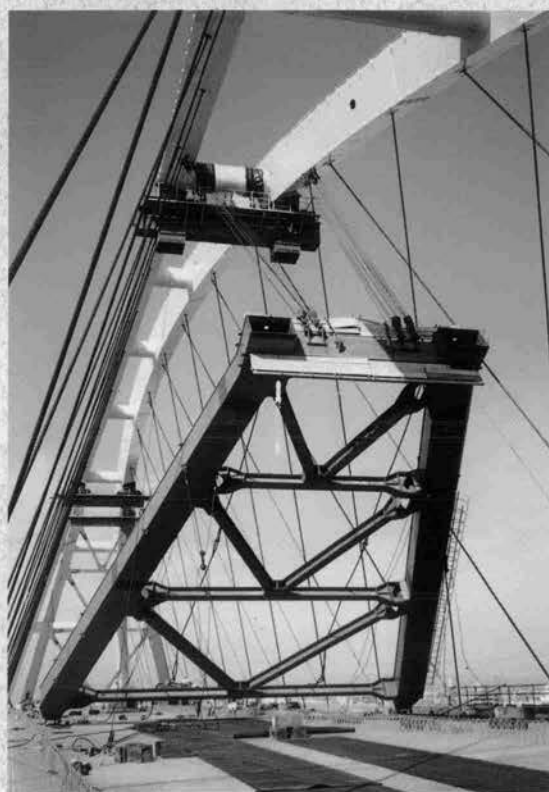
⇨ 仮支柱の撤去
