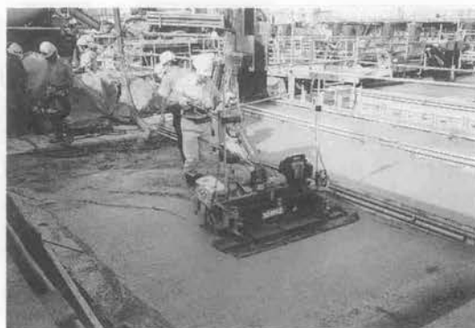
写真-1 コンクリートならし作業
