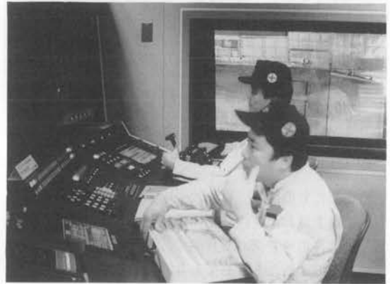
写真一5 エンジン試運転装置
