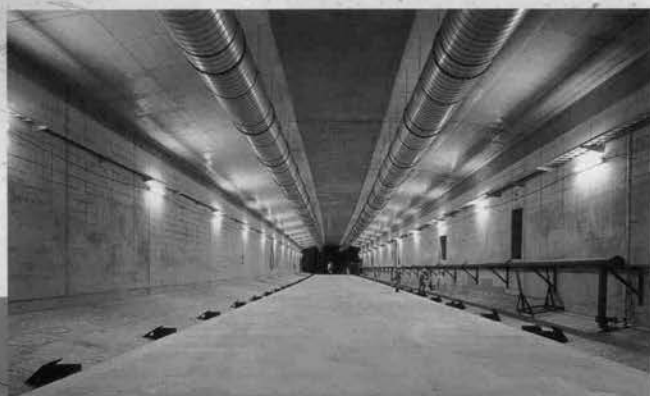
沈設前の沈埋函内部
