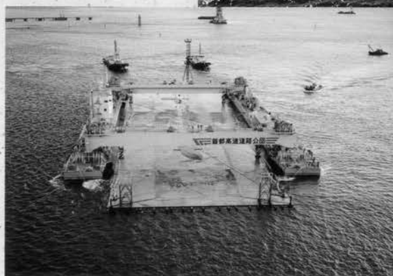
◆ プレーシングバージによる沈埋函曳航状況
