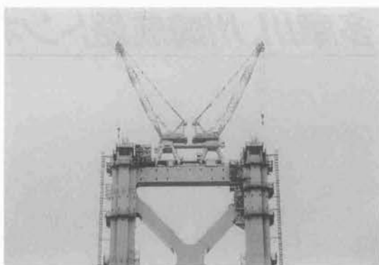
写真-1 2P上設置状態
