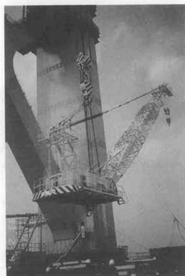
写真-2 塔頂クレーンつり上げ
