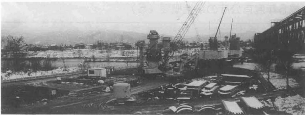
写真一 北陸新幹線高崎・長野間橋脚工事中の犀川橋りょう(L=522 m)
