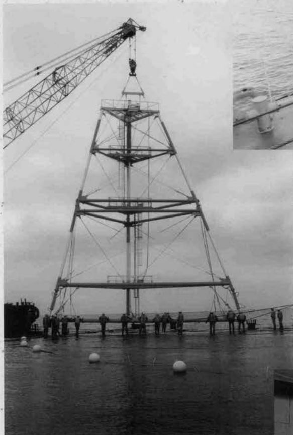
⇨ 測量塔設置状況
