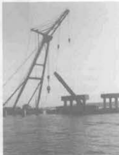
杭切断後の撤去
