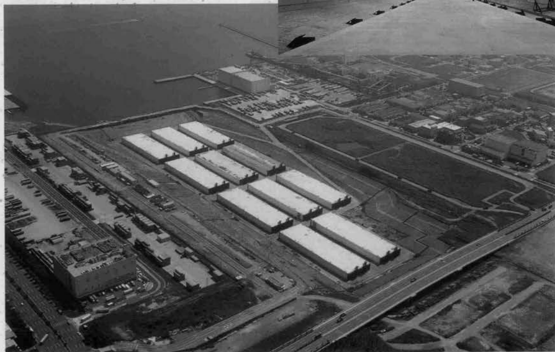
ドライドック内の沈埋函仮置状況
