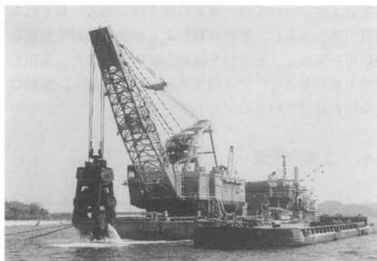
写真-3 大型グラブ船による海底掘削 (2P)
