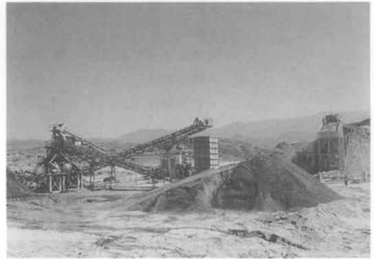
写真-4 クラッシングプラントの稼働状況
