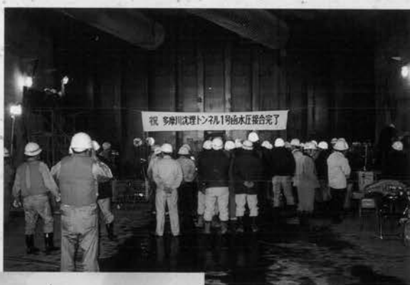
◆ 水圧接合完了
