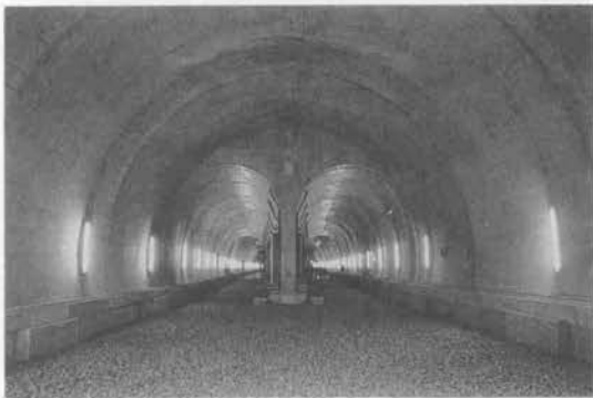
写真二 東葉高速線 NATM 工法により施工した習志野台トンネル
