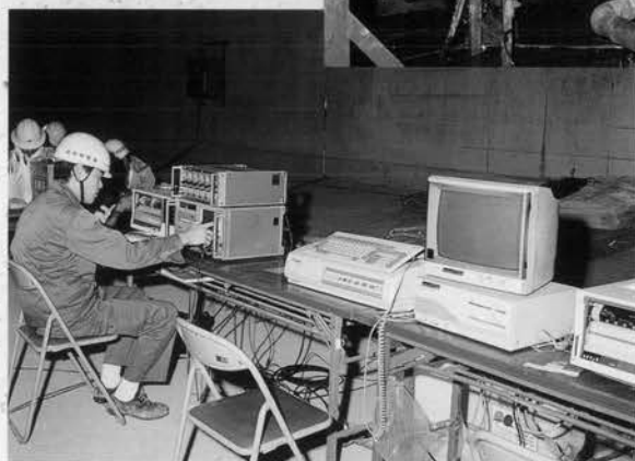
◆ 水圧接合管理状況
