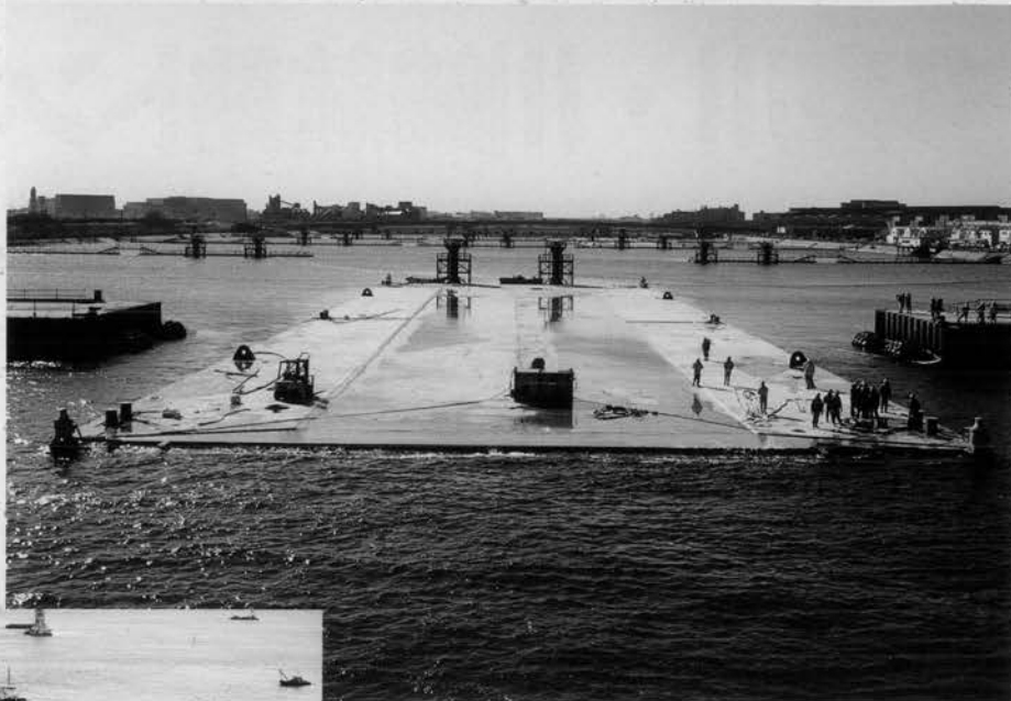
◆ ドライドックからの沈埋函引出し状況
