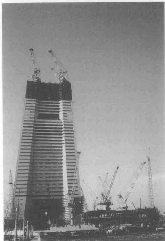
写真-3 横浜ランドマークタワー工事風景
