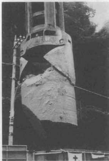
写真-4 掘り出されたコンクリート
