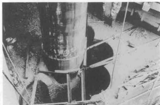
写真-3 ラップ掘り状況
