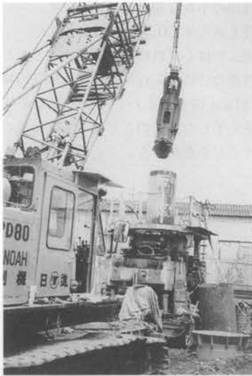
写真—8 施工状況
