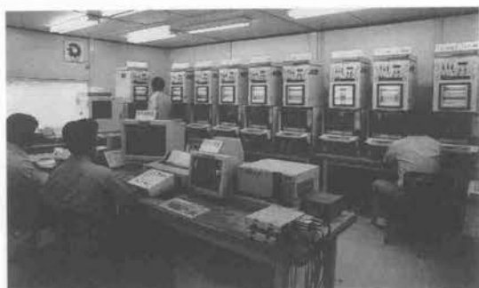
写真—9 グラウトデータ管理室内。この部屋ですべてのグラウチング作業が制御、監視できる
