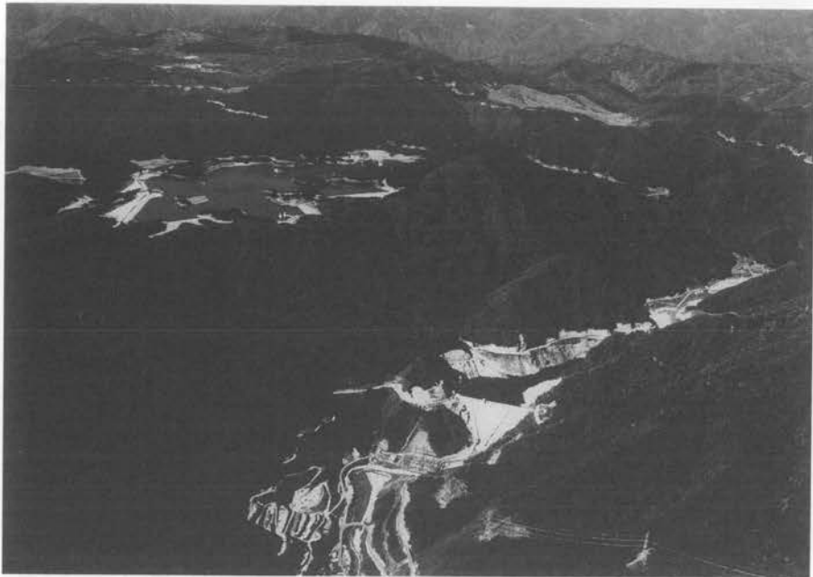
写真—1 大河内水力発電所全景
