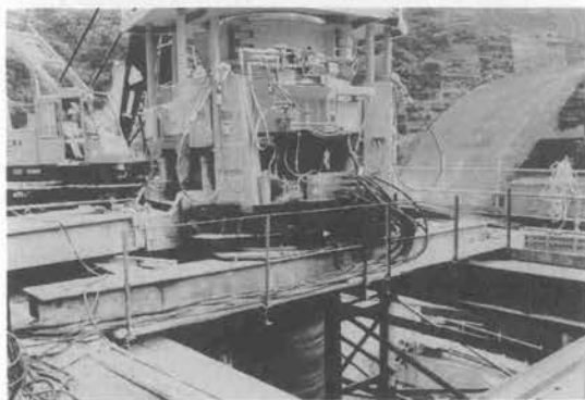
写真-2 構台上での施工
