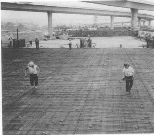
写真—8 高架橋床版の配筋工事
