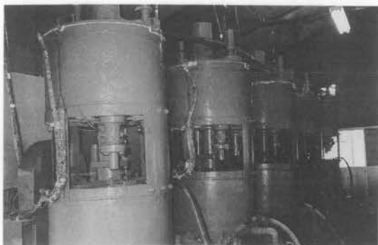
写真-6 サブプラント内にあるアジテータミキサ
