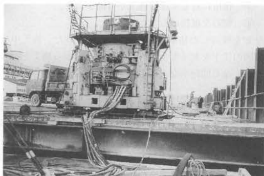
写真-7 施工状況
