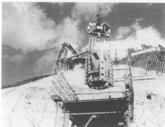
写真-1 運転状況
