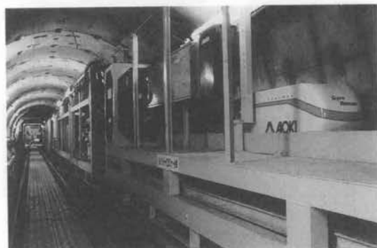
写真-1 「ジャイロランナー」を用いたシールド工事施工状況
