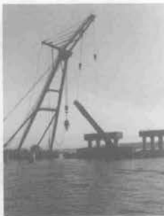
杭切断後の撤去
