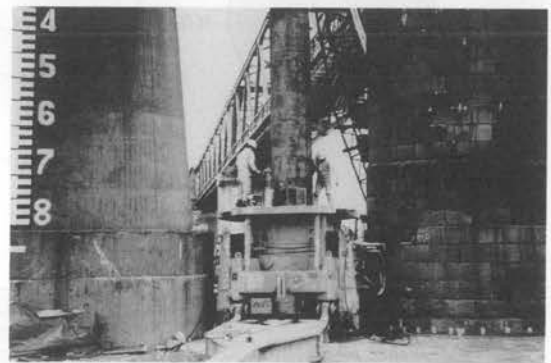
写真—1 施工状況
