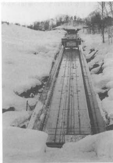
写真-2 インクライン散水融雪状況
