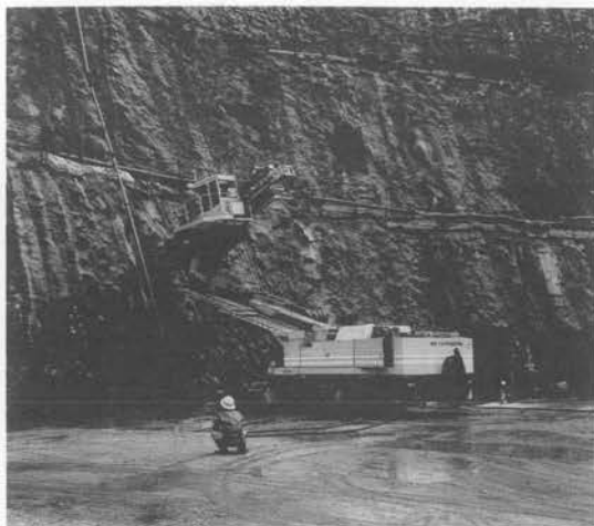
写真一 高所作業用ボーリングマシン
