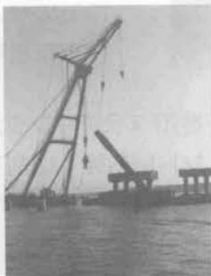
杭切断後の撤去
