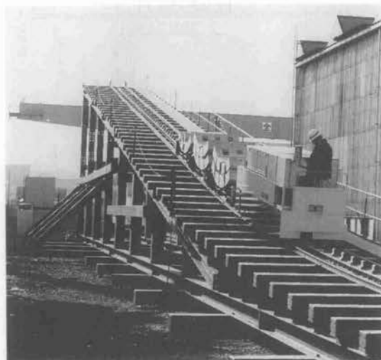
写真-2 最大勾配 200/1,000 の架台を製作しての実証実験
