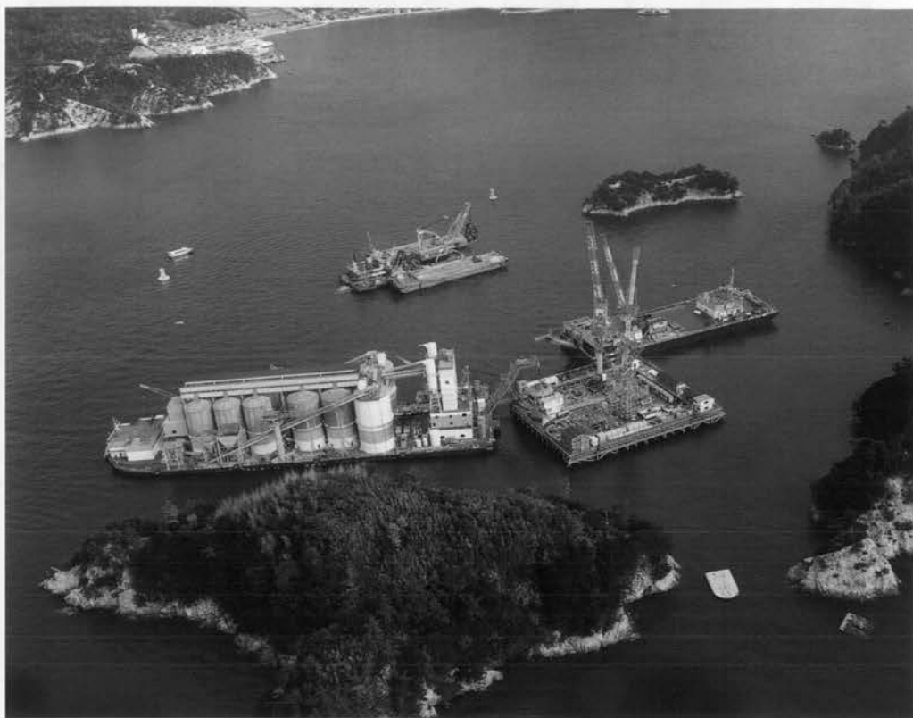
⇨ 4A水中コンクリート打設
