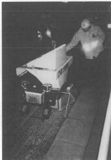
写真-19 自走式段差摺付機
