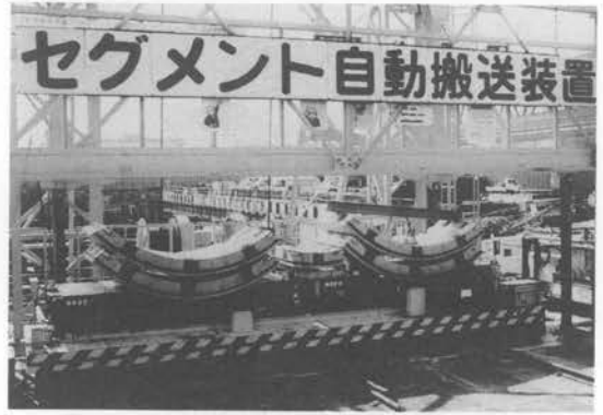
写真-9 セグメント自動搬送装置
