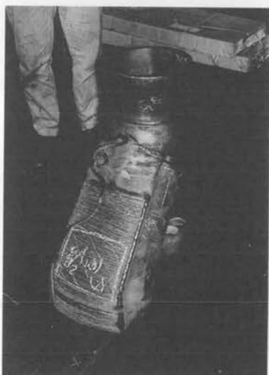
写真-3 "S"パイプの補修例
