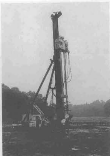
写真-4 地盤改良機全景
