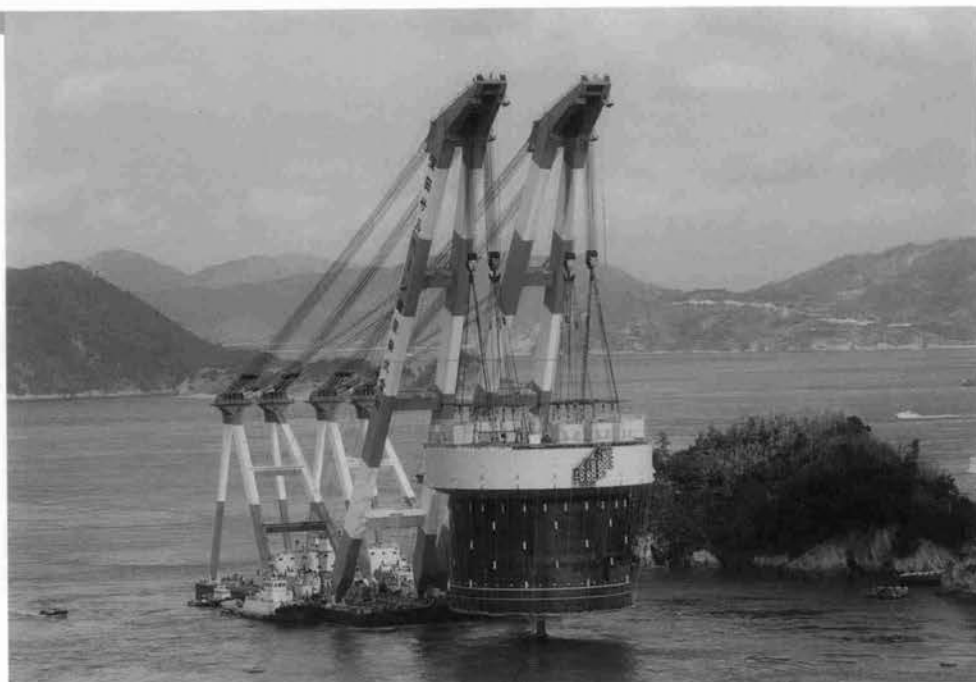
⇨ 5Pケーソン設置
