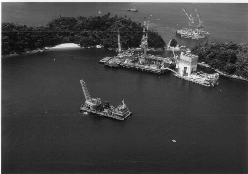
⇨ 4A気中コンクリート打設, 手前は3P砕岩掘削
