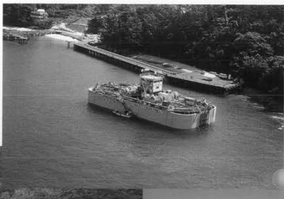
9 Pケーソン設置完了⇨
