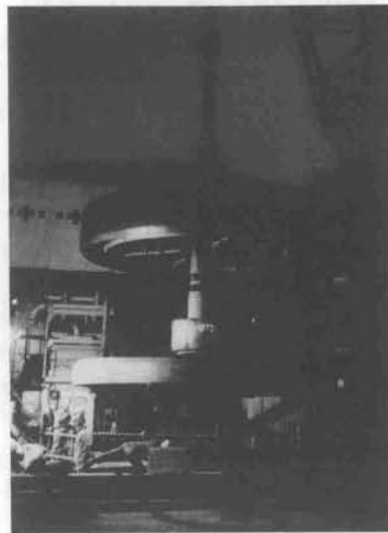
写真-8 ビットやスタビライザの組立を完了してこれから坑内につり下ろす。重りの役割を果たすスタビライザは、鉛直方向に重量をかけることにより、掘削の鉛直精度を向上するのに役立つ。150tつりのクローラークレーンが使用された。
