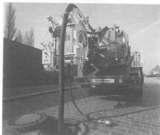
写真-1 作業状況
