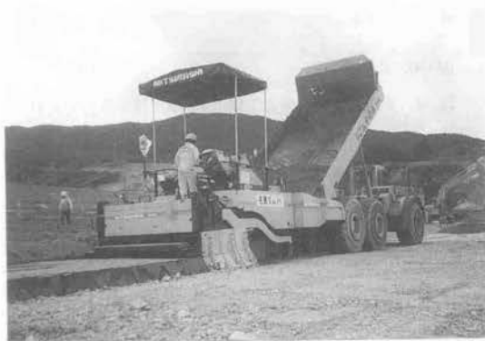
写真—44 敷きならし自動操向システム (1)
