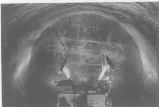
写真—3 2ロボットでの吹付状況
