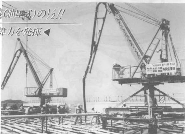
(本四架橋現場設置例)
