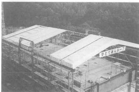
写真-24 ゆとりあんルーフ通常施工時（屋根一部開）
