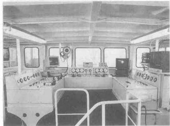
写真-37 浚渫管理システム搭載の操作室
