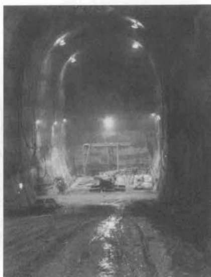
写真-1 岩盤タンク掘削状況 (菊間基地)
