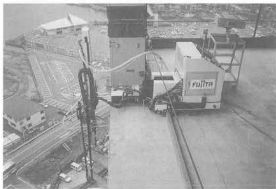
写真—32 湿式耐火被覆吹付ロボット
