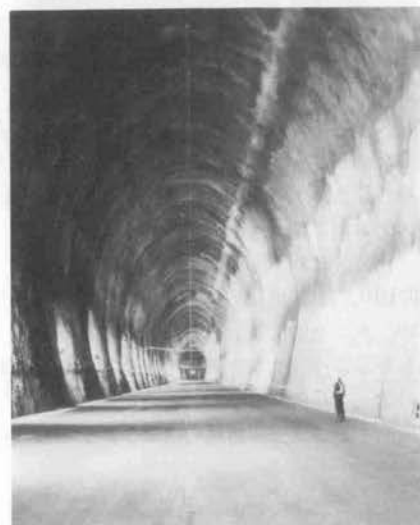
写真-2 完成した岩盤タンク (串木野基地)
