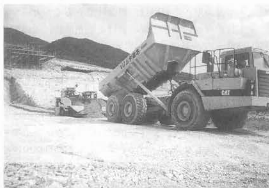
写真—45 敷きならし自動操向システム (2)
