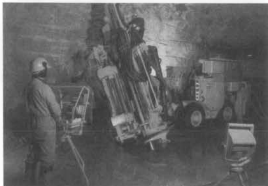
写真一 Tamrock Data Solo H 1006 RA コンピュータ搭載型削孔機
