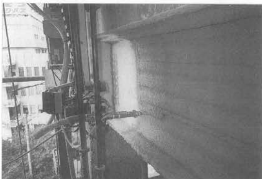
写真—33 吹付作業
