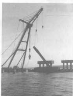
杭切断後の撤去
