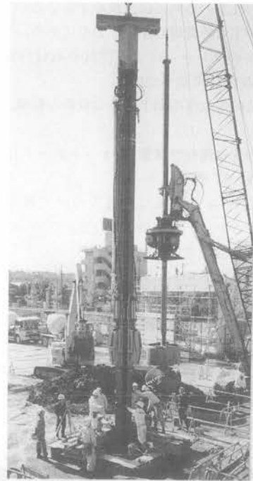
写真-29 構真柱建込み時全景
