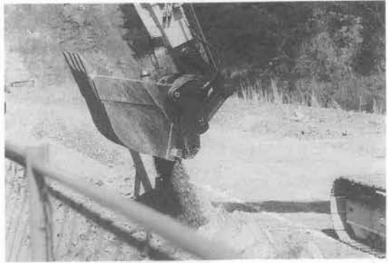
写真-8 裏込作業状況
