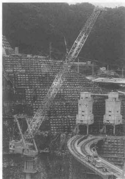
写真-1 打設システムの全景
