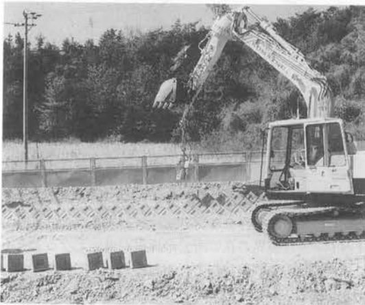
写真-1 間知ブロック捕捉状況
