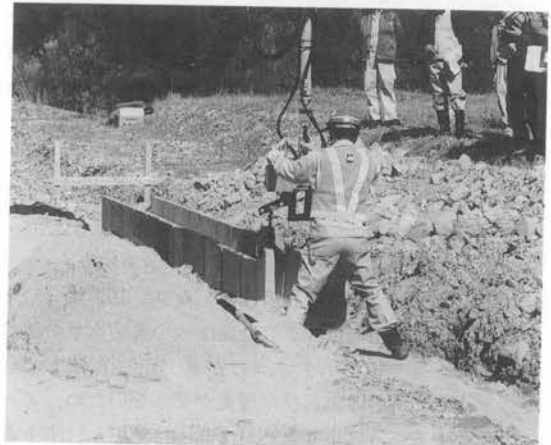
写真-4 U字溝据付状況
