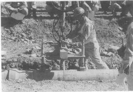
写真-6 ヒューム管据付状況
