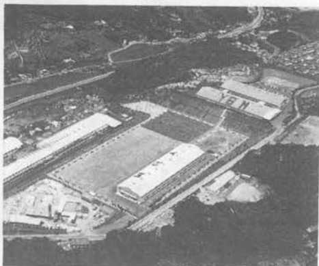
岸山工場全景
