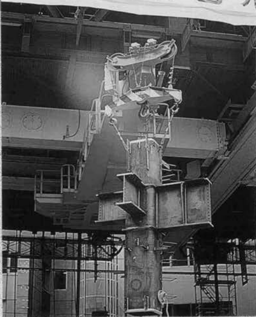
◆1F鉄骨建方状況 (アクティブクレーン半自動運転中)
