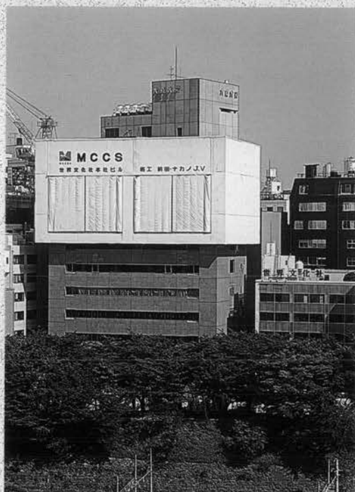
7F施工中全景(シェルタゲート閉状態)
