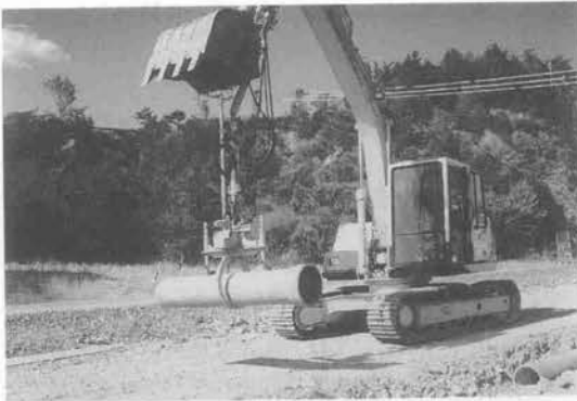
写真-5 ヒューム管捕捉状況
