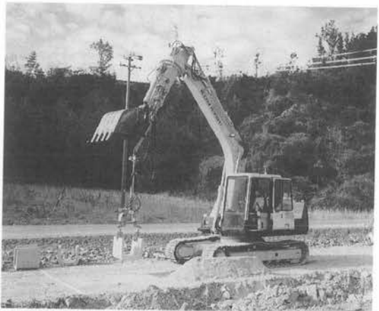
写真-3 U字溝捕捉状況
