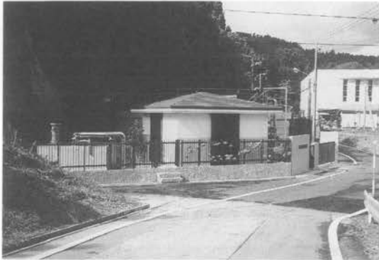
写真—3 完成した浄化センター
