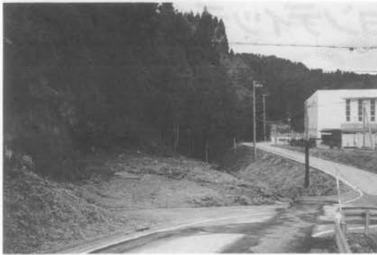
写真—2 浄化センター建設予定地
