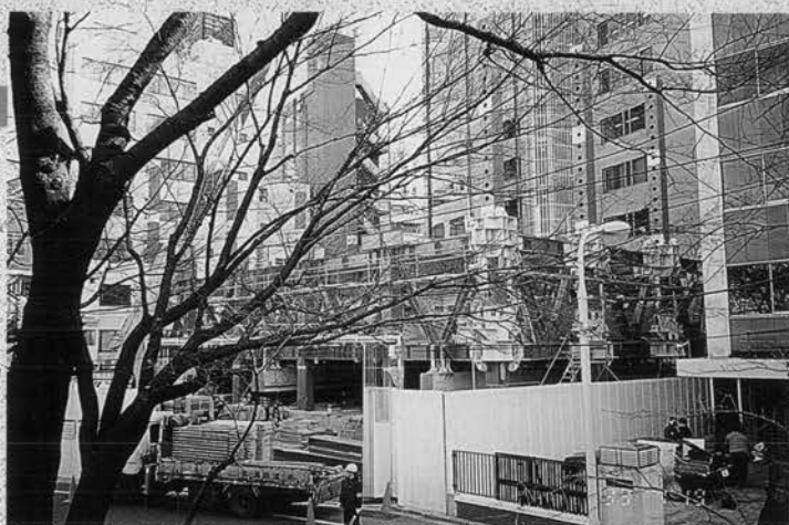
◆クライミングフロア組立状況全景
