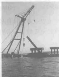
杭切断後の撤去
