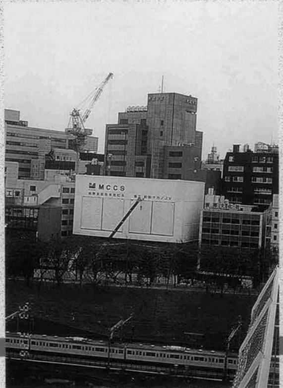
◆3F鉄骨建方全景(マスト下柱建込中)
