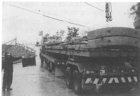
写真-4 壁部材の搬入
