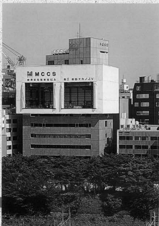
7F施工中(シェルタゲート開状態)
