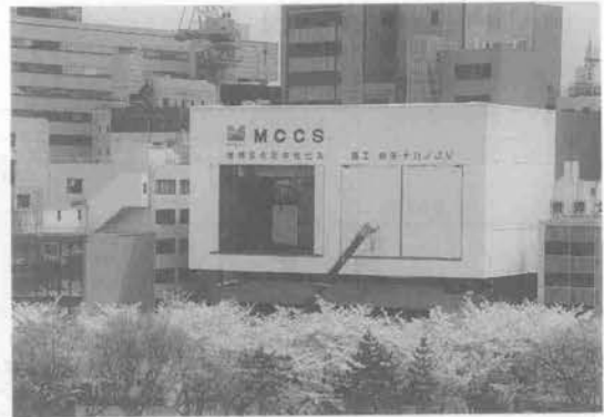
写真—4 MCC システム施工状況
