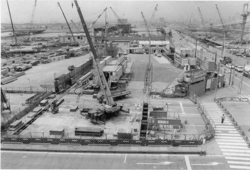
⇨ シールド発進基地全景
