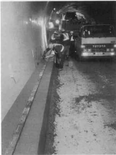
⇨ トンネル内での円形水路の施工
