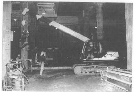
写真-3 クレーンによる従来作業
