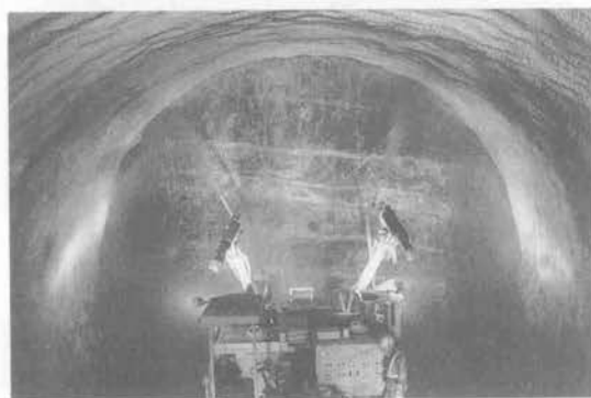
写真-5 吹付状況
