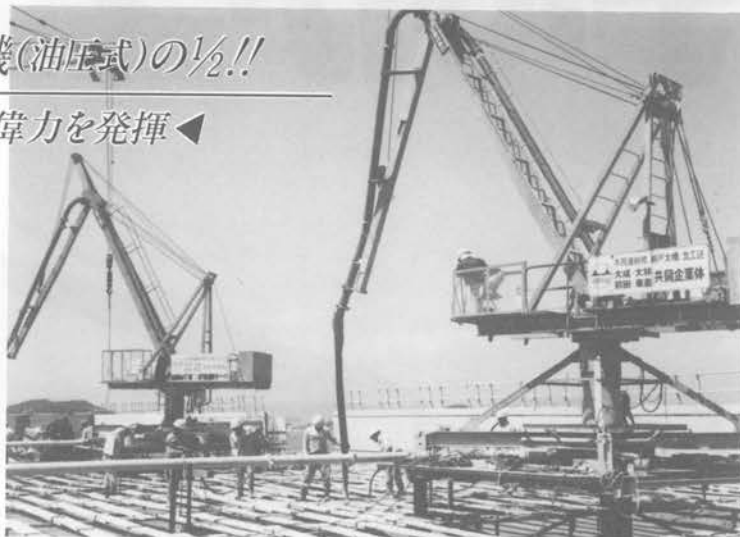
(本四架橋現場設置例)
