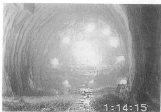
写真-2 起爆瞬間 (五里ヶ峯トンネル (上田) 工区)
