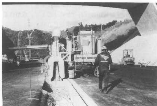
写真-3 コンクリート防護柵の施工
