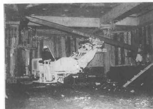
写真-6 斜梁の取付作業
