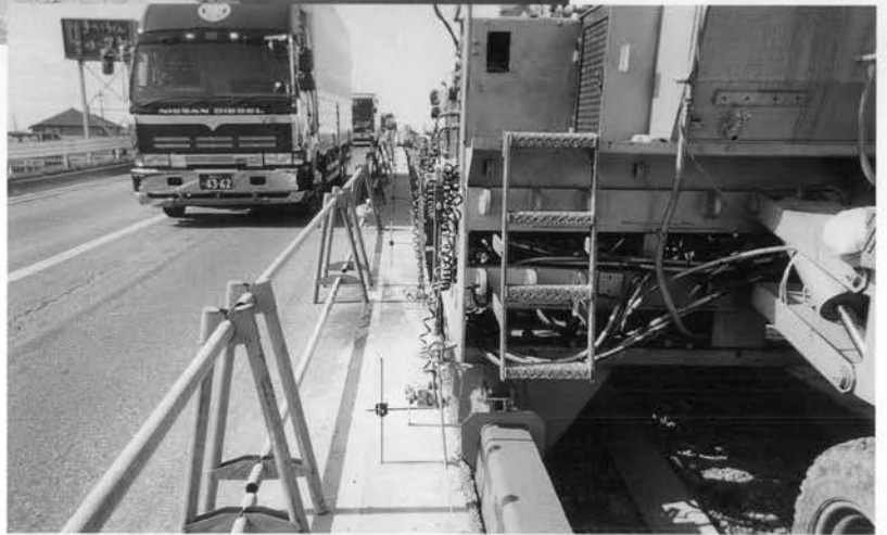
◀ 中央分離帯PCC-Cの施工
