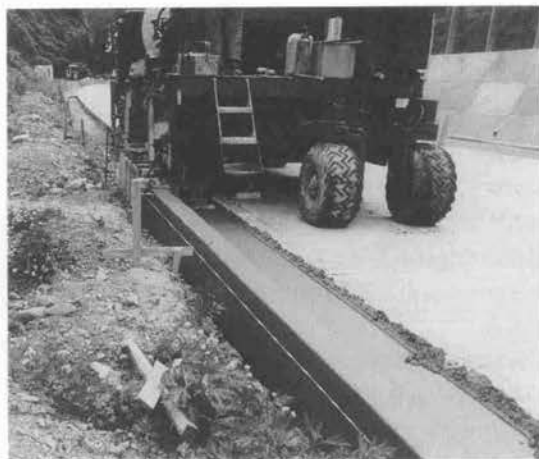
写真—2 SLとなる丁張り(Lガッター)
