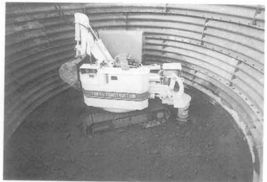
写真-1 坑内掘削機
