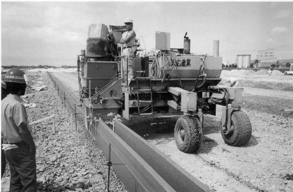
◀ U形側溝の施工
