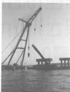
杭切断後の撤去
