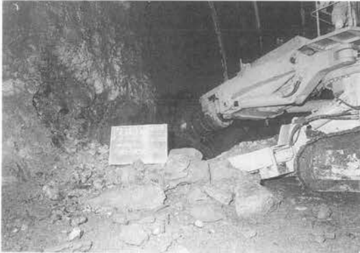
写真-1 上半掘削 (ロードヘッダ S-200) (八重原トンネル (西) 工区)
