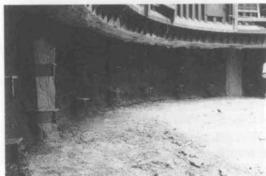
写真2 吹付コンクリート剪断キーの施工状況
