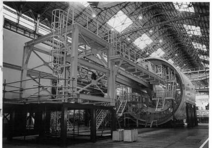
⇨ 有明共同溝DOTシールド機 (後方・セグメント搬送設備とも)
