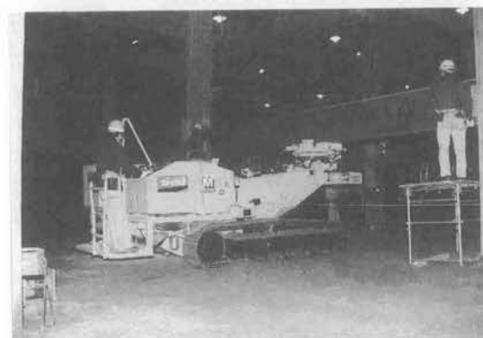
写真-5 水平鉄骨梁の取付作業
