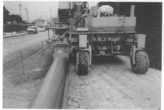
写真-6 中央分離帯ラウンド縁石施工
