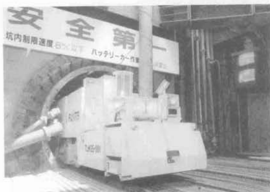
写真1 無人バッテリー機関車使用状況(天理送水管工事)
