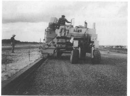
写真-7 舗装止めの施工
