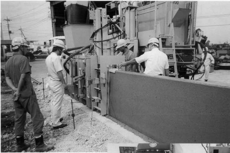
◀ 監視員通路立ち壁の施工
