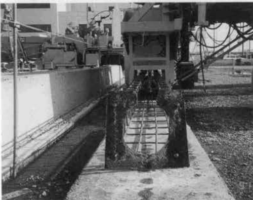
⇨ トンネル内での円形水路の施工
