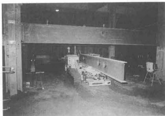
写真-4 鉄骨梁の運搬姿勢
