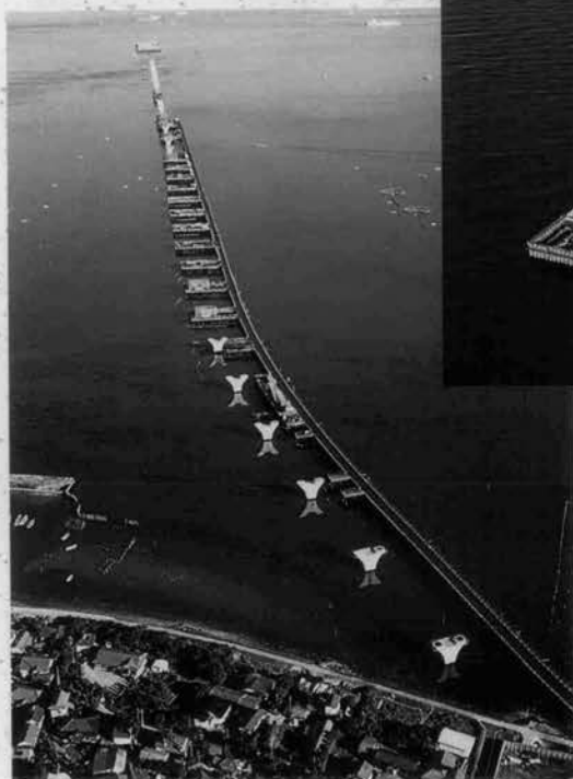
◆木更津側橋梁部現況(平成5年8月)
