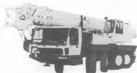
写真5 KOMATSU(独 クルップ製)KMK 4080 オールテレーンクレーン
