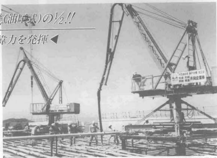
(本四架橋現場設置例)
