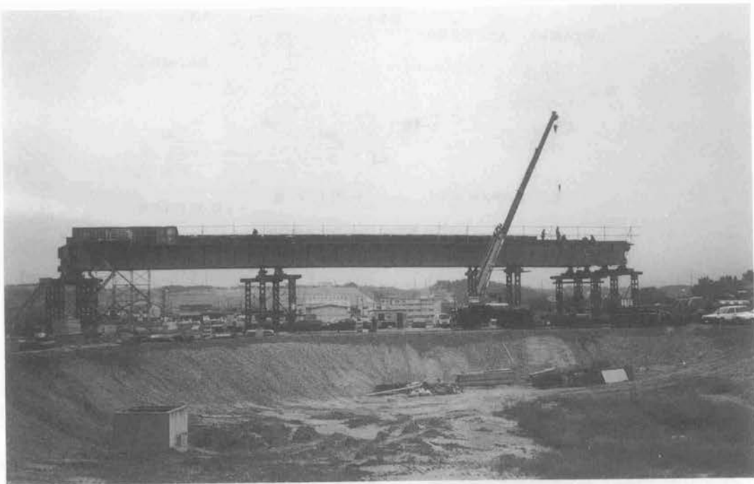
写真—1 作業ヤードで組立中の地念古橋
