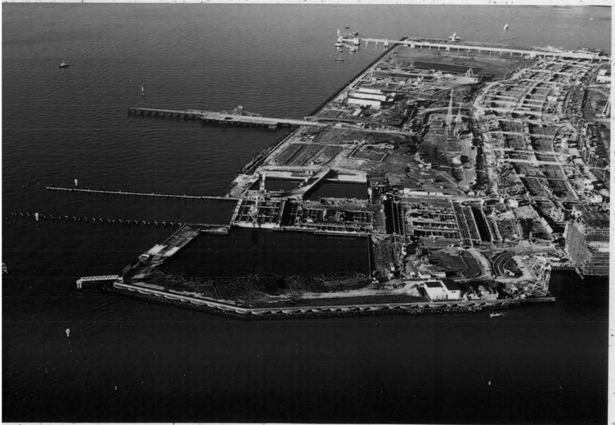
⇨ 浮島取付部現況(平成5年8月)
