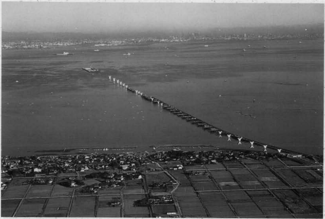
⇨ 木更津側から見た全景
