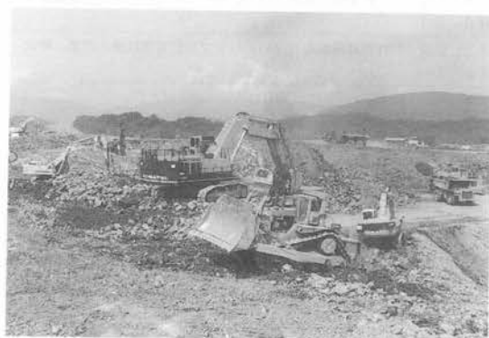
写真—2 中硬岩の小割集土, 積込み
