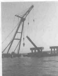
杭切断後の撤去
