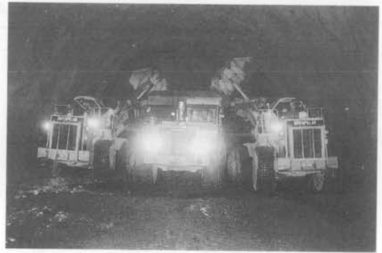
写真二 ずり積込状況
