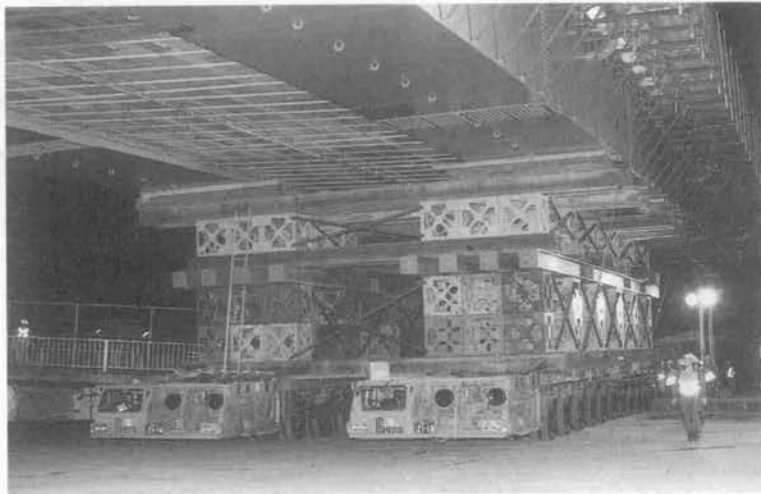
写真-3 三好インター橋の運搬状況
