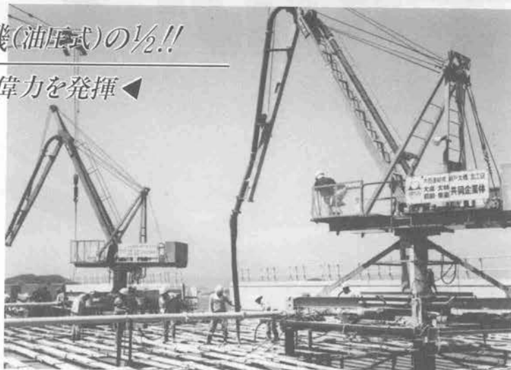
(本四架橋現場設置例)
