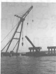
杭切断後の撤去
