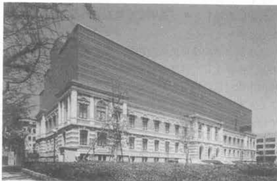
写真—3 明治時代の外壁を保存して新しいガラスの外壁の庁舎と融合再生した例（神戸地方簡易裁判所）
