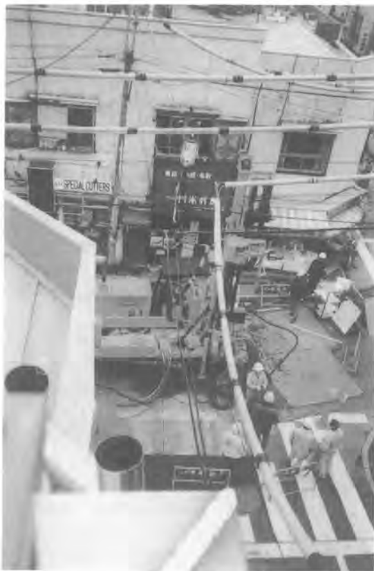
写真-2 ジェットグラウト施工現場
