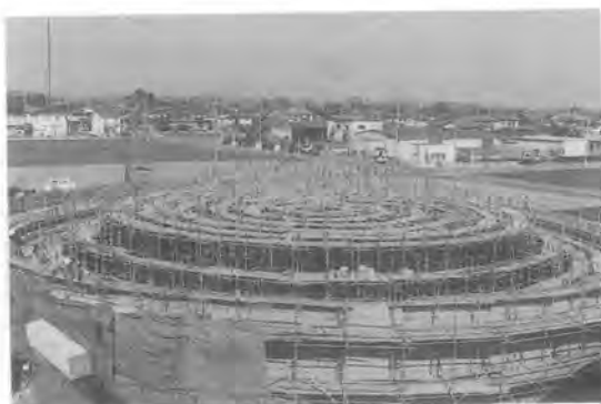
写真一 従来工法における支保工組立状況
