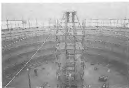
写真二 エアドーム工法における貯水槽内部状況
