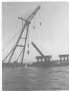
杭切断後の撤去
