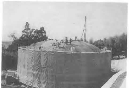
写真-9 モルタル施工状況
