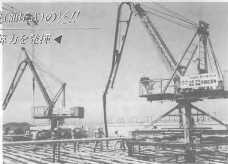
(本四架橋現場設置例)
