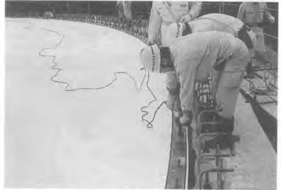
写真-7 空気膜の取付固定
