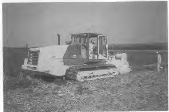
写真—1 全体写真
