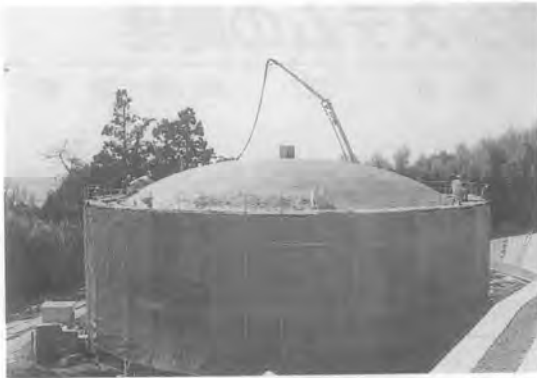
写真-10 モルタル施工完了
