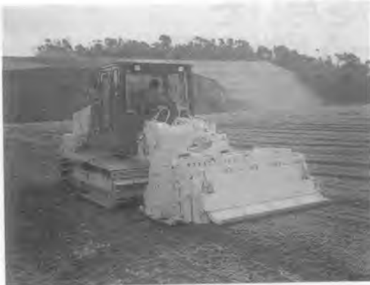
写真-6 稼働風景
