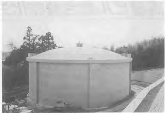
写真-12 PC ファームボンドの完成
