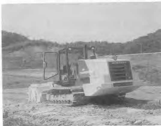
写真-7 稼働風景
