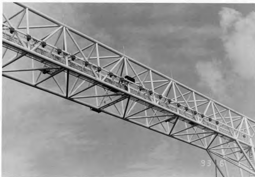
光波式砂面検出器配置状態
