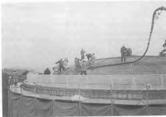
写真-11 ドーム配筋～コンクリート打設
