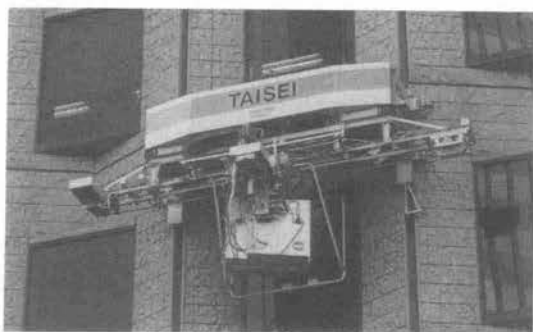
写真—3 作業状況
