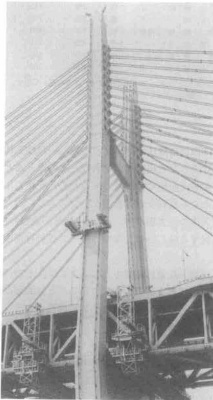
写真一 桁外面・塔外面点検作業車
