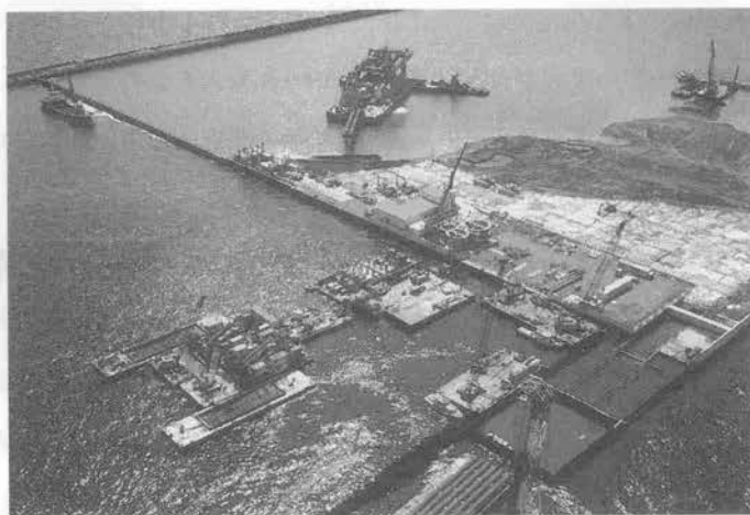
写真—1 工事状況
