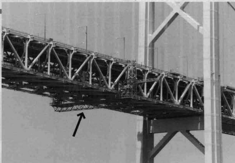
長大橋の維持管理機械 (橋梁点検中)
