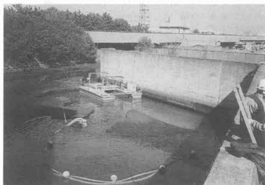
写真-3 サブマード工法施工
