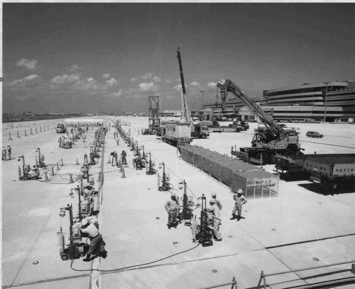
空港エプロン舗装のリフトアップ工法
