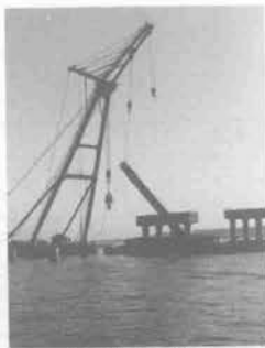
杭切断後の撤去
