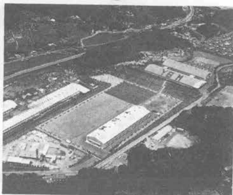
岸山工場全景
