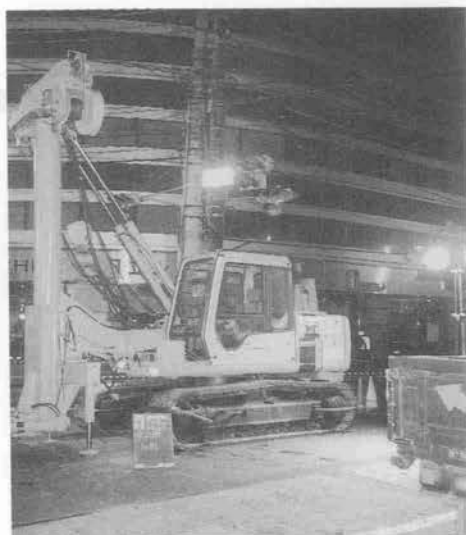
写真—4 杭建込機
