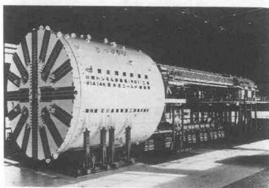
写真-9 石川島播磨 14.14 mφ 泥水式シールド機（東京湾横断道路向け）
