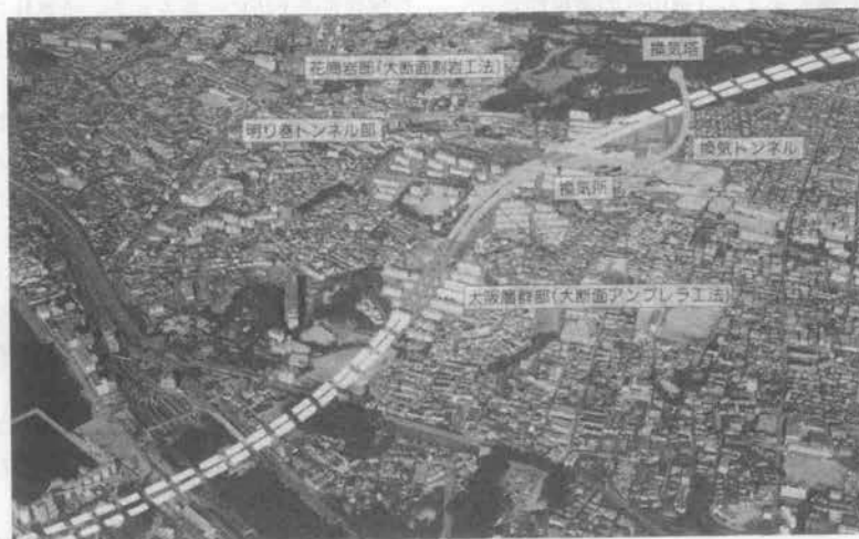
写真2 舞子トンネル南工事俯瞰
