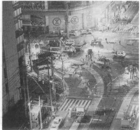
写真-1 夜間施工状況
