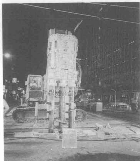
写真-2 SMW-5000 型キャタピラ方式
