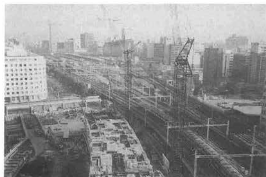
写真-2 クローラークレーン（タワーモード）による鉄骨建方
