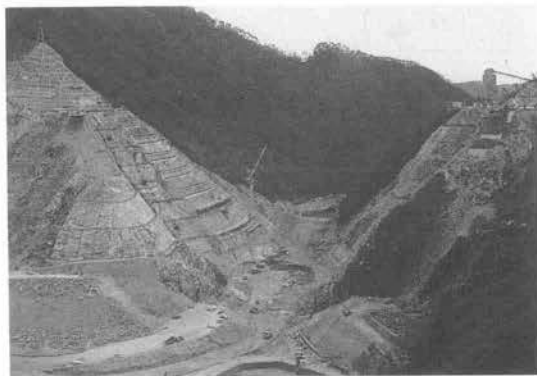
写真—3 ダムサイト現況
