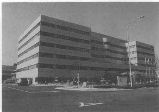
写真-5 産業機械工場総合事務所
