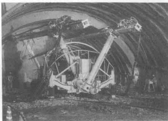
写真1 トレビチューブの施工 (SM505DT)
