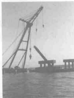
杭切断後の撤去
