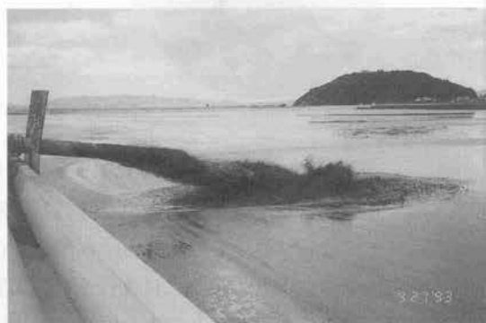
写真-2 排泥状況
