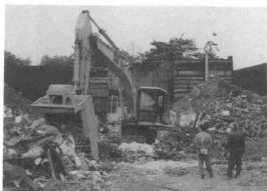
写真-4 廃材処理
