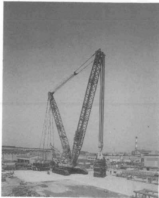
写真-3 超大型クレーン SL 13000
