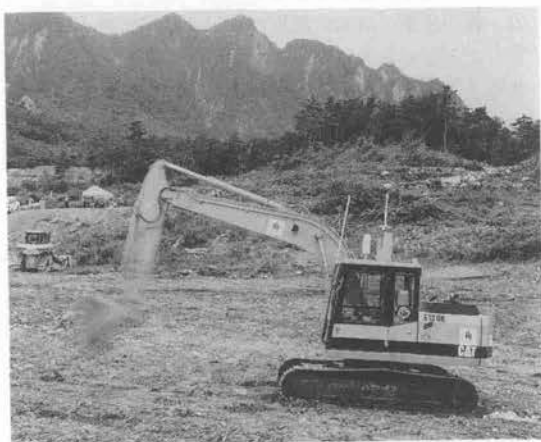
写真一 無人化重機管理（長崎県島原市）
