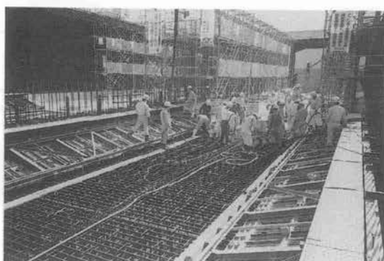
写真-5 ハンチ型枠
