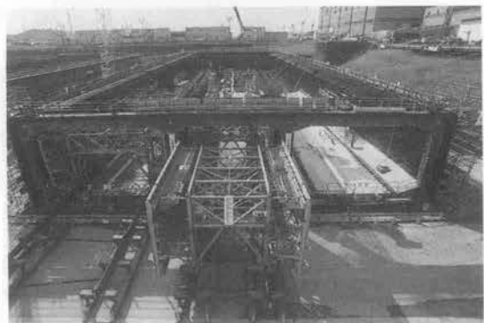
写真-3 側壁トラベラ
