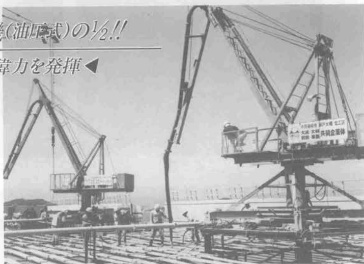
(本四架橋現場設置例)
