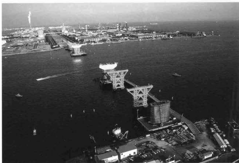
橋脚の配置状況
