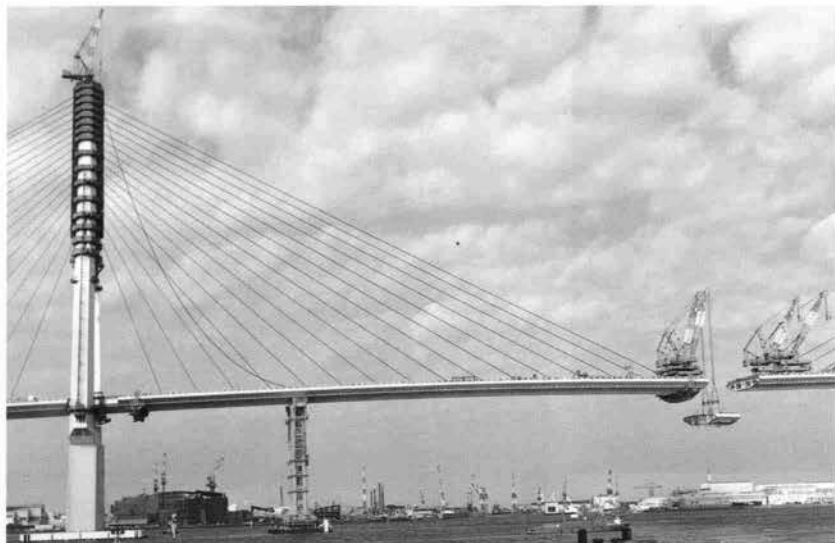
中央径間桁ブロック架設
