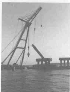
杭切断後の撤去
