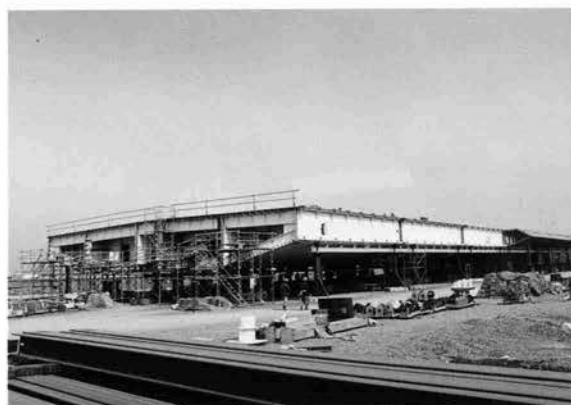
側径間桁大ブロック地組立
