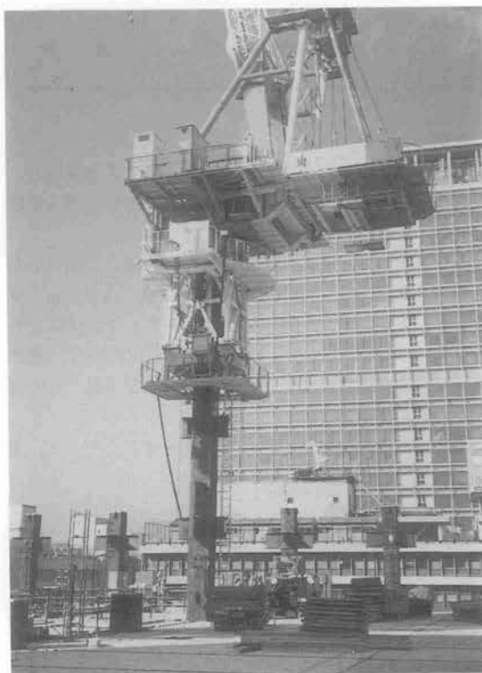
写真-1 マスト・コラム工法にて施工中
