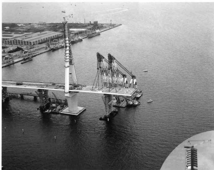
中央径間桁大ブロック架設
