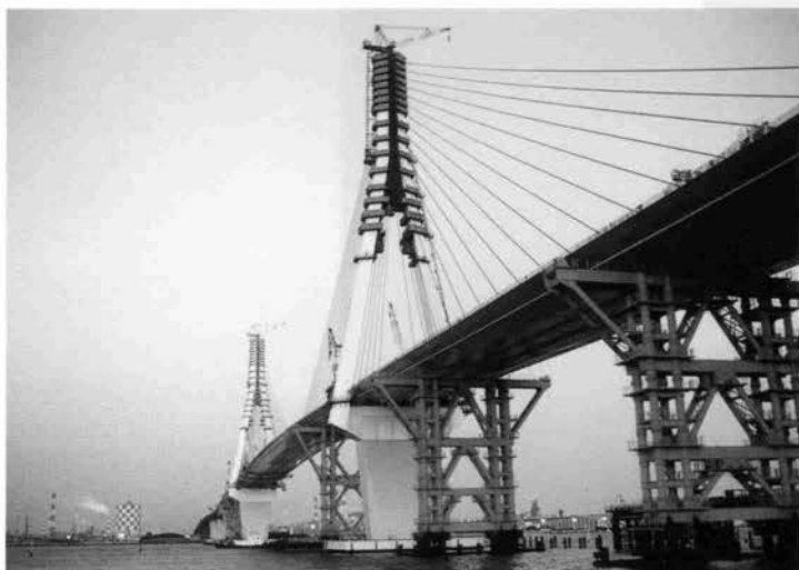
桁架設完了
