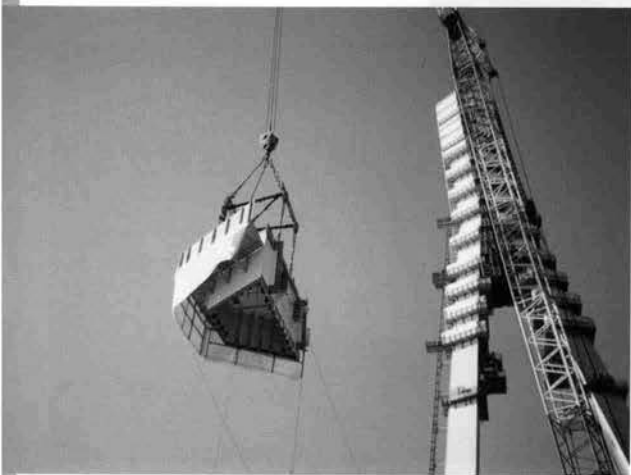
主塔単材吊上げ
