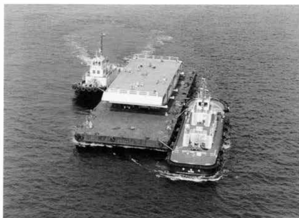
直下吊桁ブロック運搬
