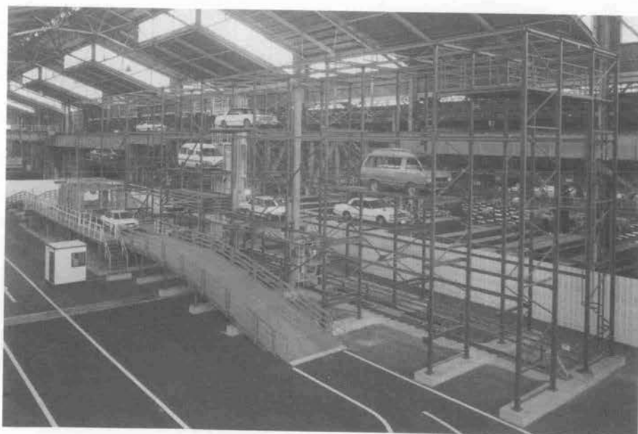
写真-1 カーネスト実証機外観
