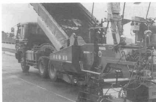
写真-1 本技術における施工状況
