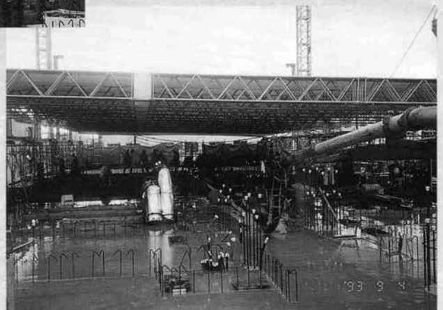
荒天中のコンクリート打ち
