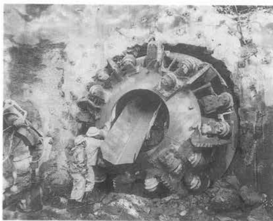
写真-2 TBM 1号トンネル到達状況
