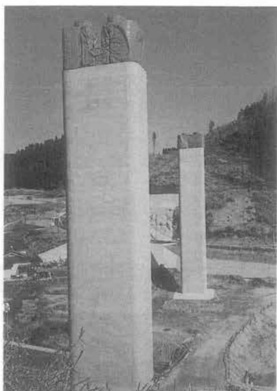
写真—6 完成写真
