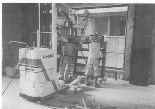
写真-12 ガラスの施工 (神戸市のオフィスビル)
