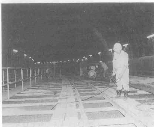
写真-5 ならし機操作状況
