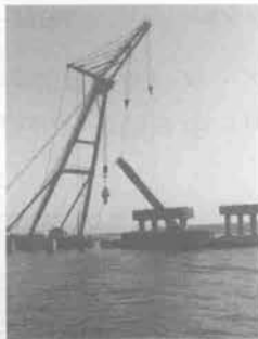
杭切断後の撤去
