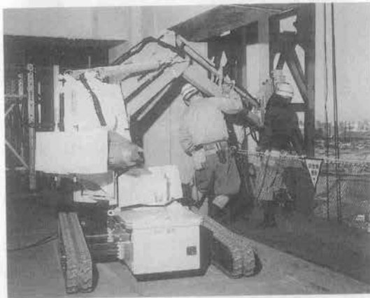
写真-4 柱裏マリオンの取付（右側） （東京都臨海副都心建設現場）
