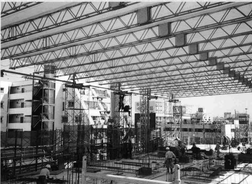
屋根下の工事
