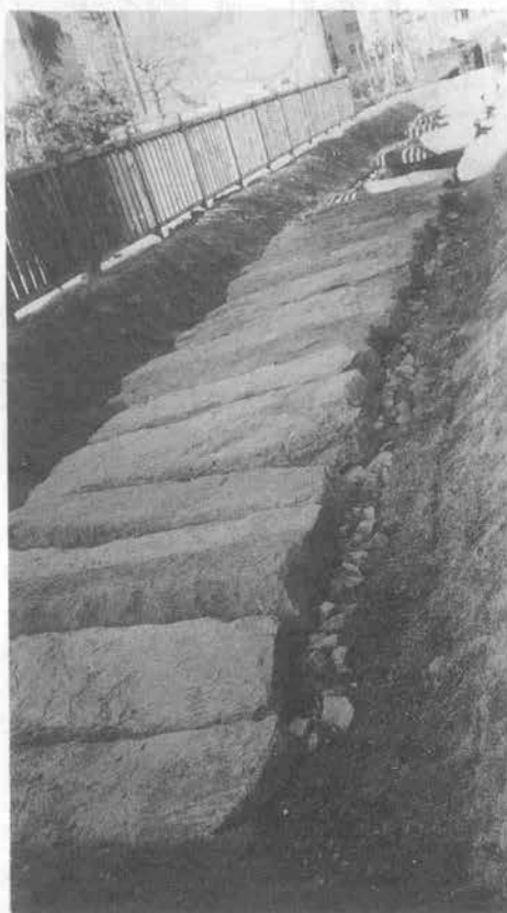
写真-5 移設復元された神田上水の石樋(本郷給水場公苑)(筆者写)
