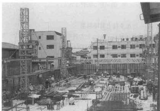
写真-3 組立中の現場
