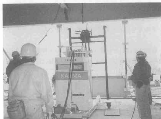
写真-10 カーテンウォール取付 (東京都臨海副都心のオフィスビル)
