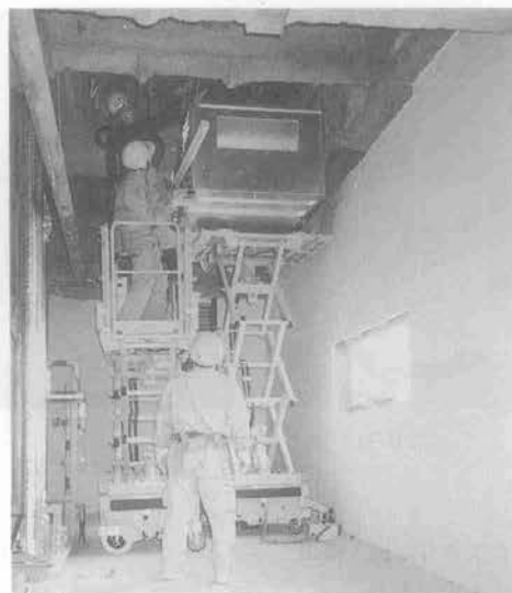
写真-11 ダクトフィルターの取付 (東京都のオフィスビル)
