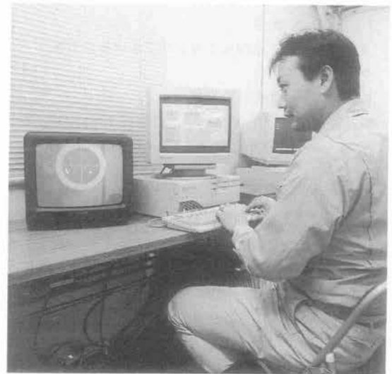
写真-5 中央制御室
