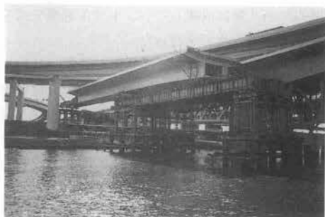
写真—5 送り出し状況
