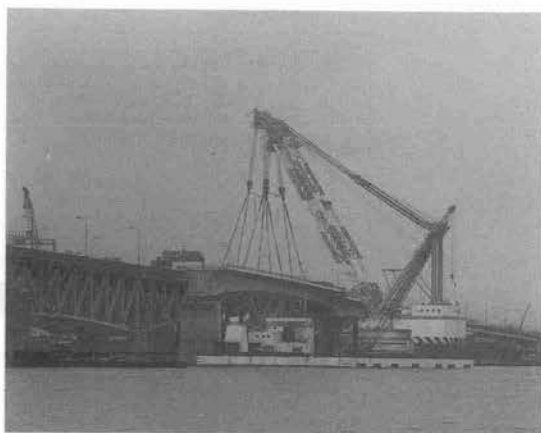
写真—3 山側橋梁（岸・右側）架設状況
