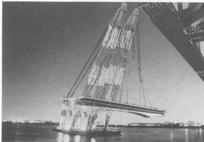
写真-1 海側橋梁大ブロック架設
