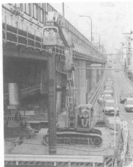
写真-2 超高周波杭打抜機による市街地での低振動施工
