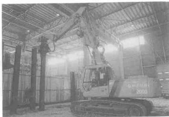
写真-3 高さ制限のある工場内でのプレボーリング・H鋼施工
