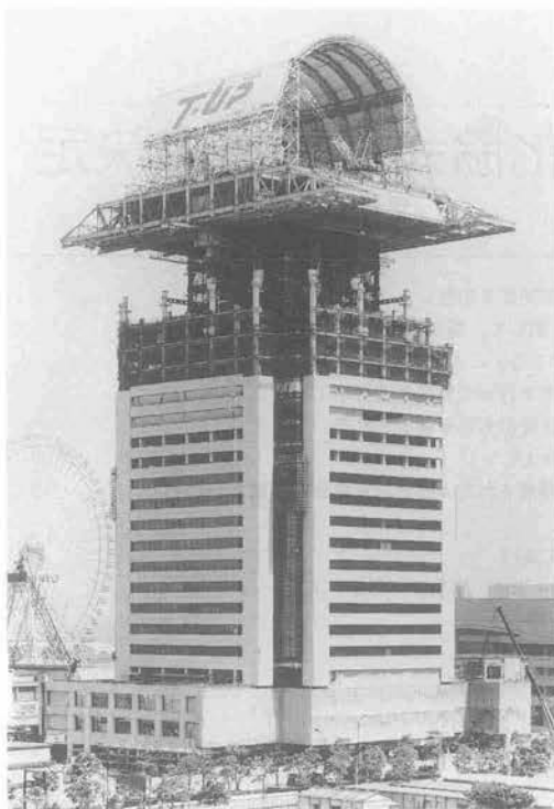
写真—1 本工事の施工状況
