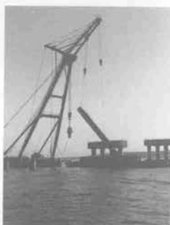
杭切断後の撤去
