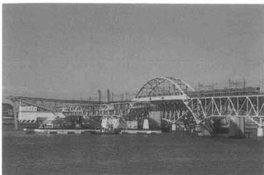
写真—2 1,600tつりFC桁下通過状況
