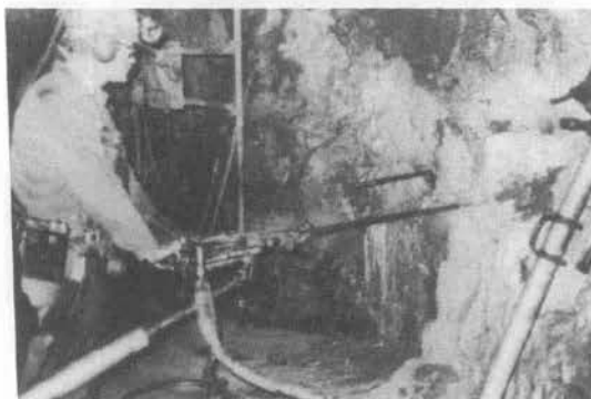
図-2 フィールドテスト状況
