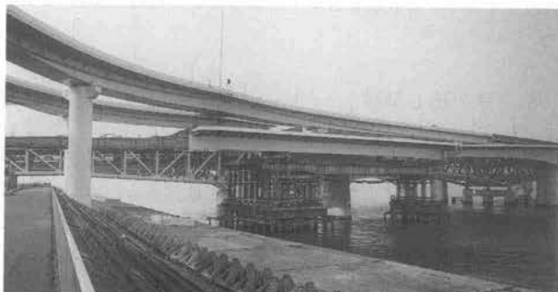
写真—6 送り出し状況
