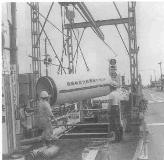
写真-1 測量管投入状況
