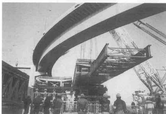
写真—4 山側橋梁（岸・左側）架設状況
