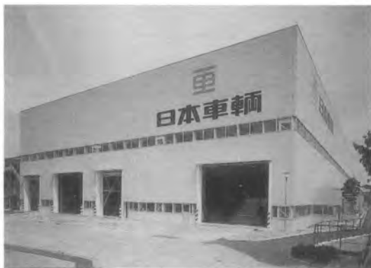
写真-4 新設重機工場
