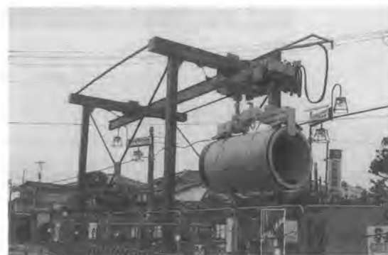
写真-18 搬入装置(ヒューム管の搬入状況)
