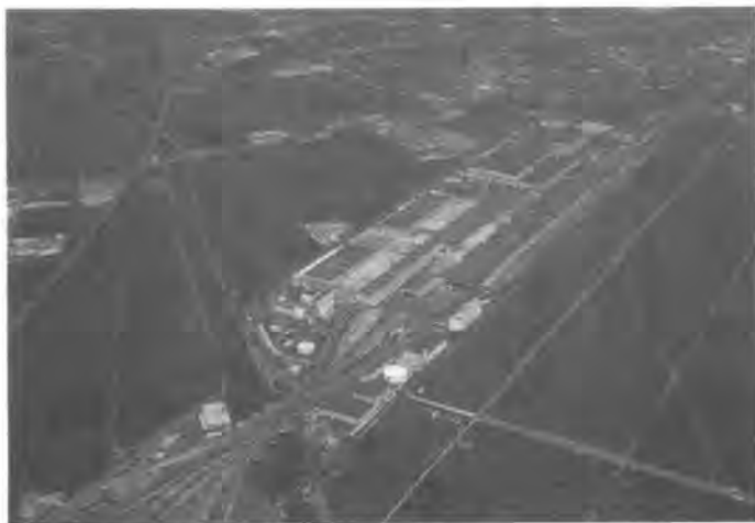
写真-2 仙台総合車両所全景
