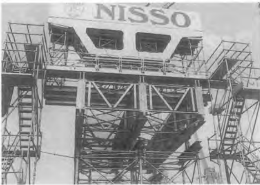
写真-3 橋梁型枠支保工
