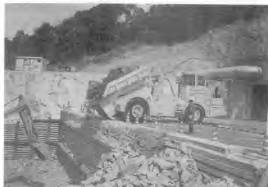
写真—2 ずり運搬機械 TW 20
