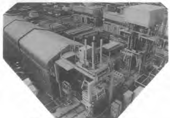
写真-16 セグメント保管・搬送トンネル
