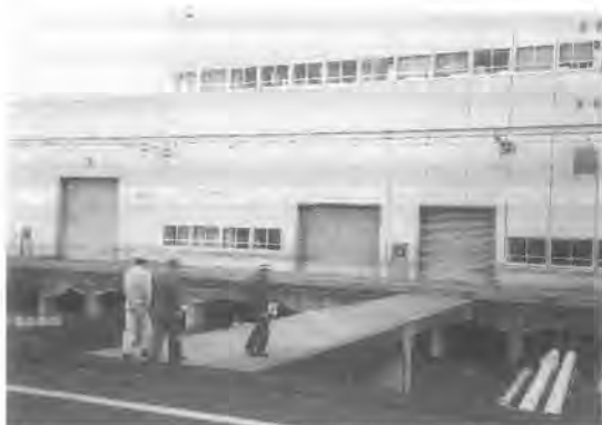
写真—10 全床面を上げたピロティー風の工場建物
