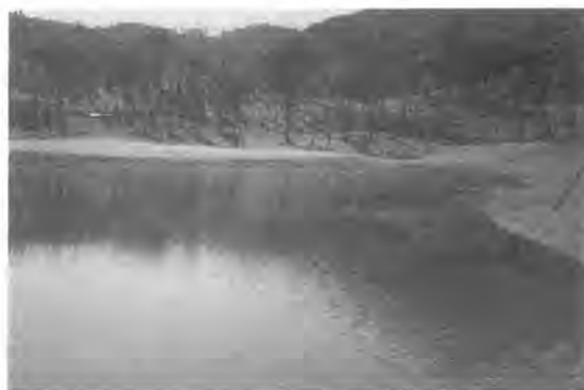
写真-2 ソイルセメント遮水工法による修景池
