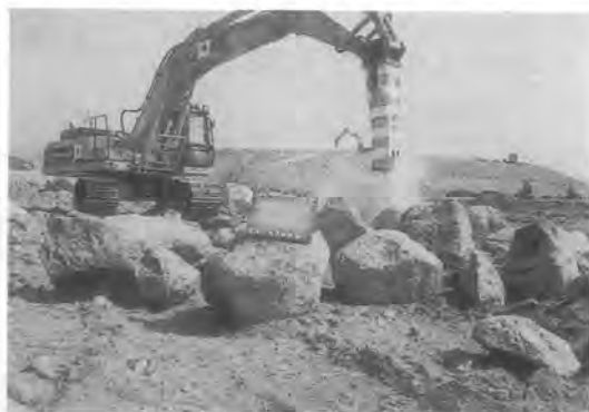
写真-3 小割作業の無人施工状況
