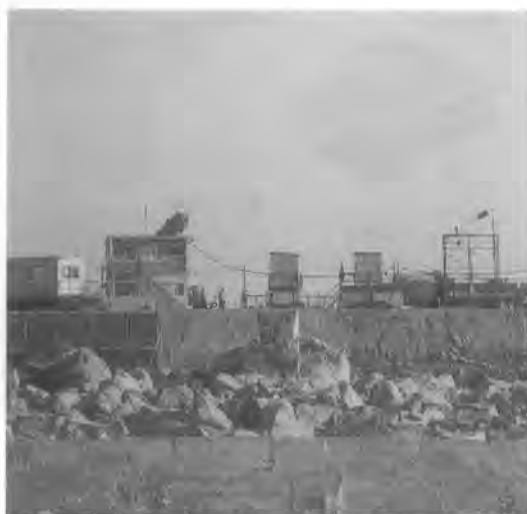
写真-2 巨石分布状況 (遠方は中央監視室および各重機ごとの移動遠隔操作室)
