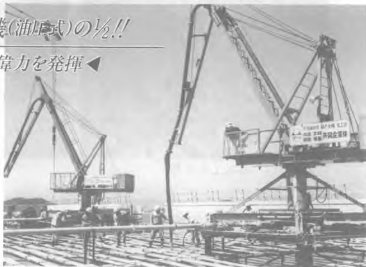
(本四架橋現場設置例)
