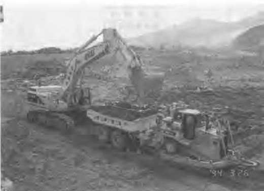
写真-2 キャリオールダンプ積込状況
