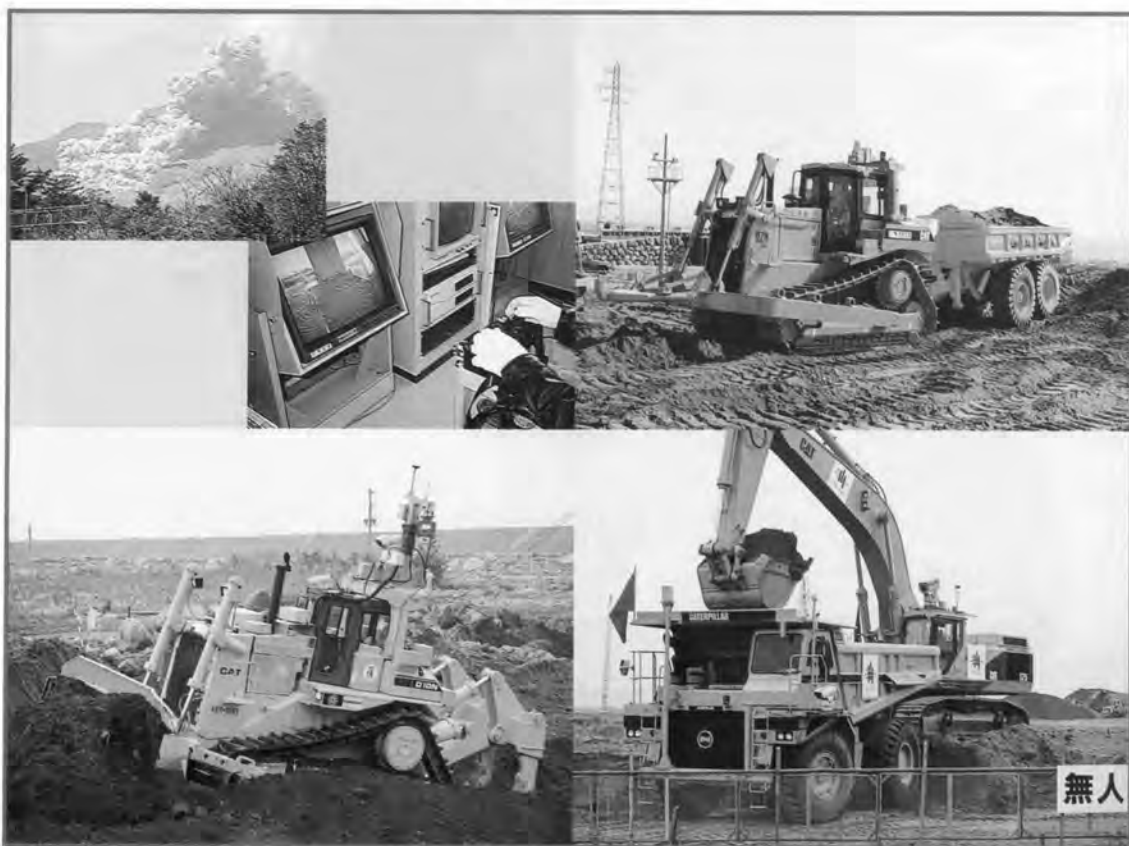
雲仙普賢岳無人化施工で活躍した無人建設機械 新キャタピラー三菱株式会社
