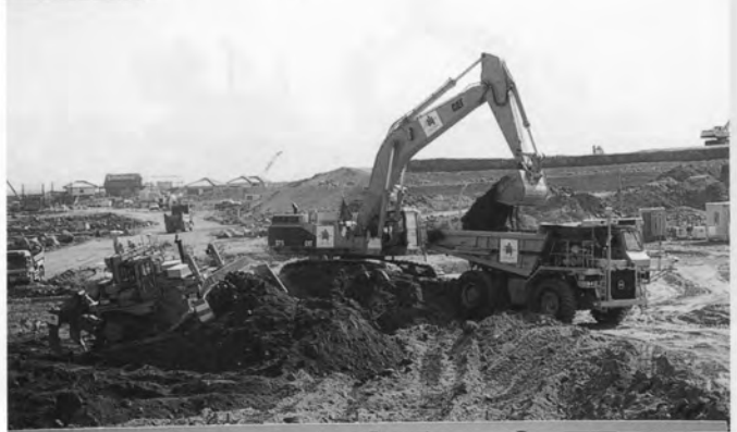
集土及び積込作業・無人施工状況⇨
