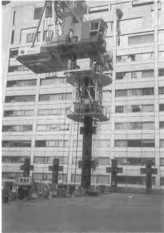
写真一六 マストコラム工法にて施工中
