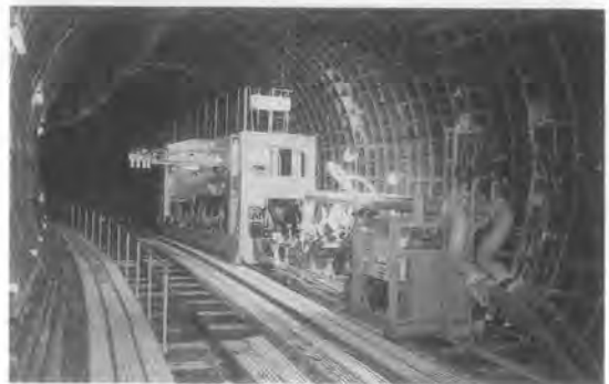
写真-14 送排泥管自動接合装置
