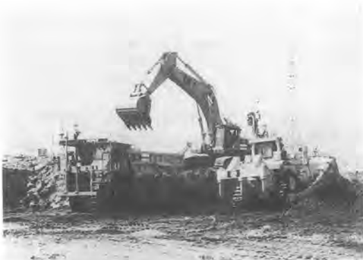
写真-1 バックホウ積み込み・ブルドーザ集土作業状況
