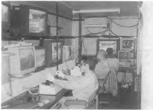
写真-1 コントロールルーム
