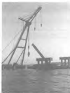
杭切断後の撤去
