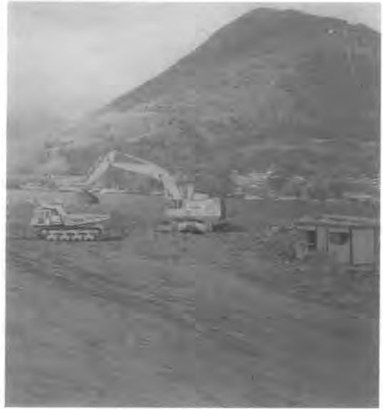
写真-2 施工状況
