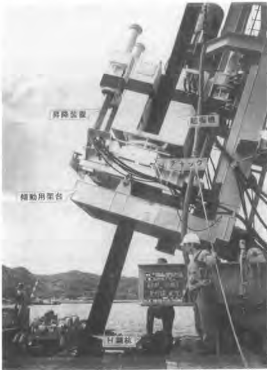
写真-8 リーダーレス杭打ち工法 (九州電力茶臼北発電所工事)
