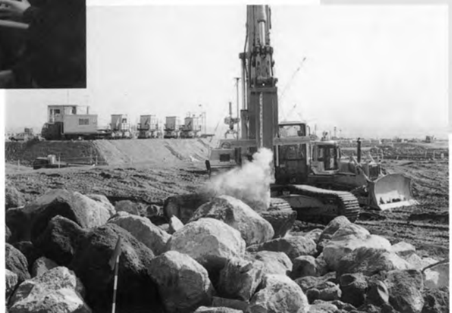
リモコン操作による岩破碎⇨
