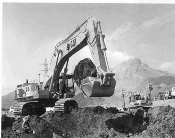
⇨ 無人化施工作業状況
