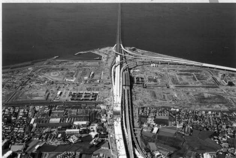
⇨ 連絡道路等施工状況
