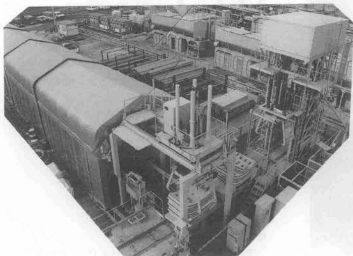
写真-1 地上搬送設備全景
