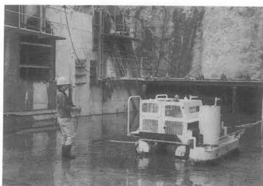
写真-36 高圧水式グリーンカットロボット
