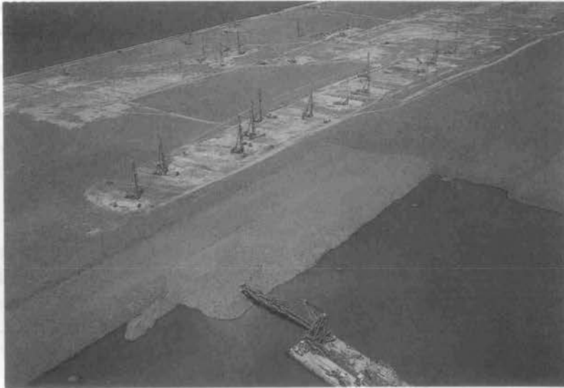
写真—5 揚土および埋立土の地盤改良状況
