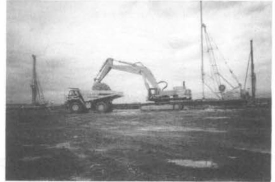
写真—4 掘削工事風景
