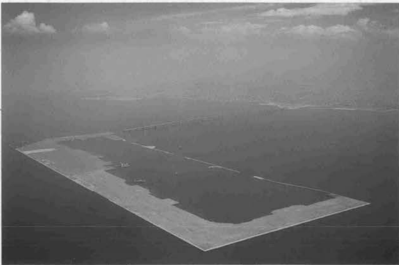
⇨平成2年8月現在の埋立状況
