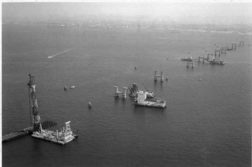
⇨ 連絡橋下部工
