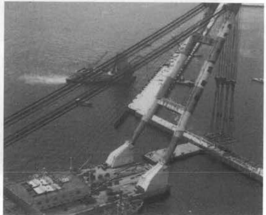
写真-3 スリットケーソン据付
