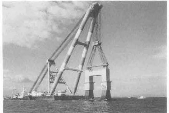
写真-5 鋼製橋脚の設置
