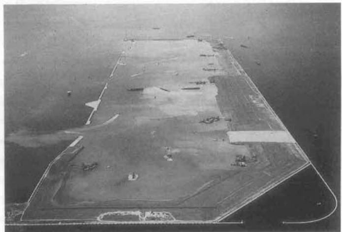
写真一四 埋立状況
