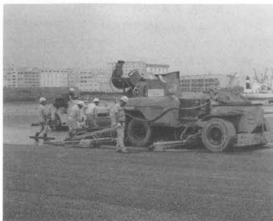
写真—25 スラリースクイーザ施工状況
