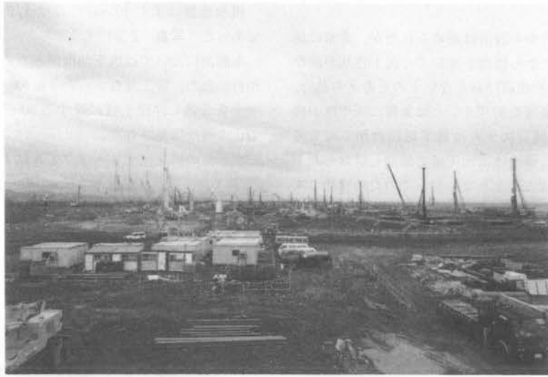
写真—2 現地着工直後の工事現場風景
