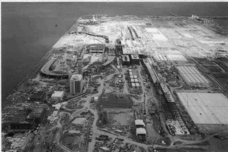
⇨PTB・鉄道駅等施工状況
