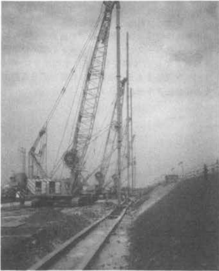
写真—3 止水壁工事
