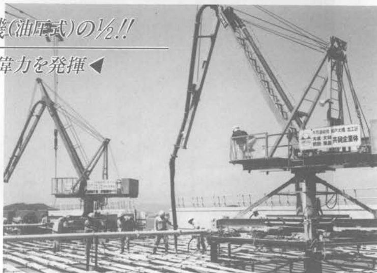
(本四架橋現場設置例)
