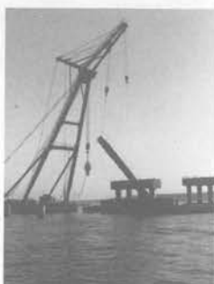
杭切断後の撤去
