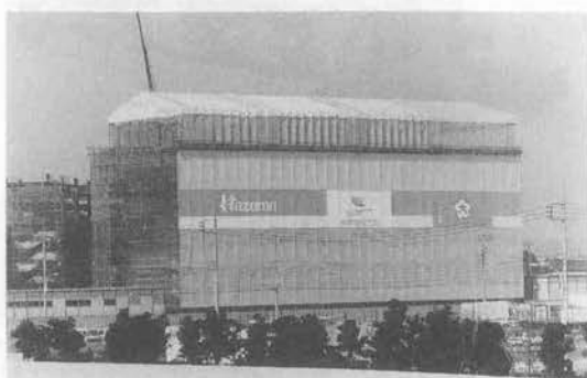
写真一30 ハザマ式全天候型仮設屋根「バラガス」
