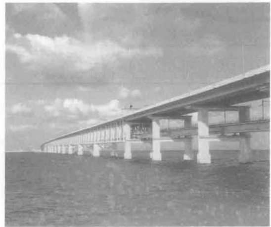
写真-9 りんくうタウンから連絡橋を望む
