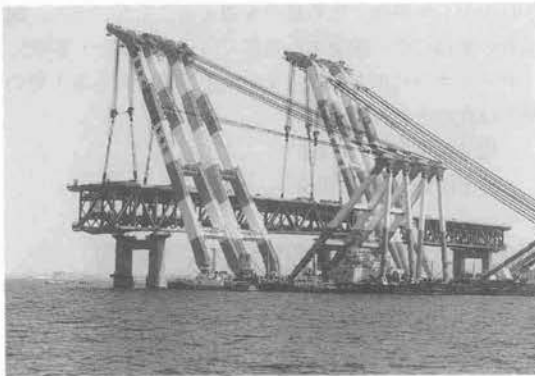
写真-8 上部工の架設
