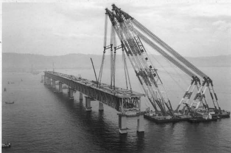
⇨ 連絡橋上部工一括架設
