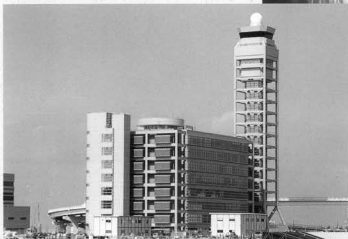
◀ 管制塔および航空局庁舎
