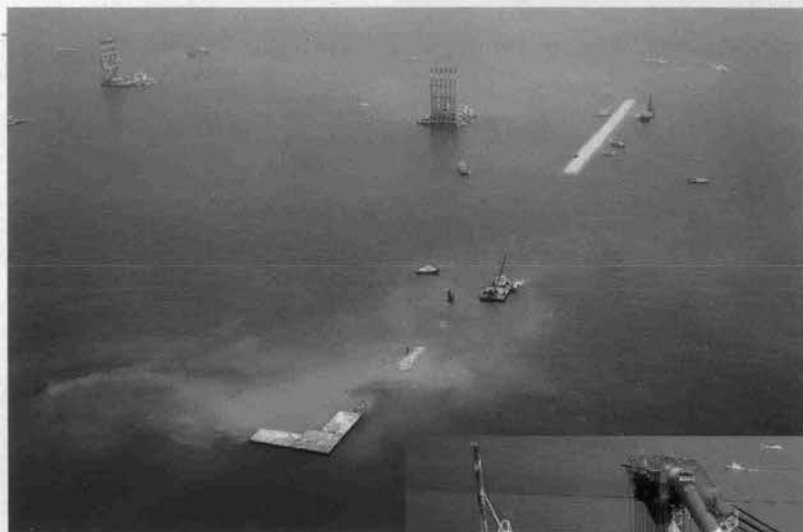
⇨ 地盤改良・護岸建設
