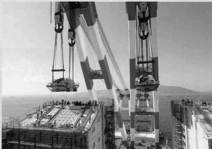
⇨ 350t吊クレーン船による スプレーサドルの架設
