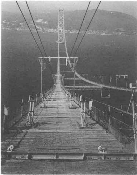
写真—4 キャットウォークの完成状況
