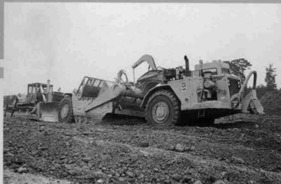
⇨ 機械土工施工実態の検討に関し モータスクレーパ作業の現地調査
