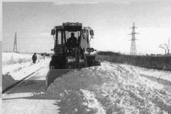
⇨ 除雪ドーザの現地性能試験
