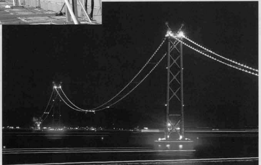
、 夜間作業用の⇨ キャットウォーク照明
