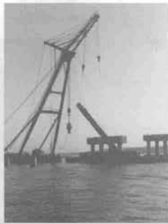
杭切断後の撤去
