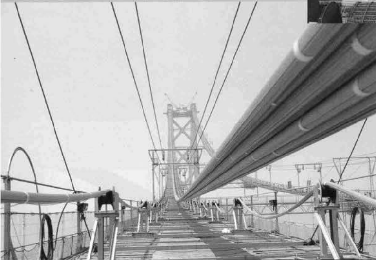
⇨ケーブルストランドの架設
