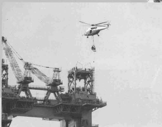
⇨ パイロットロープの架設
