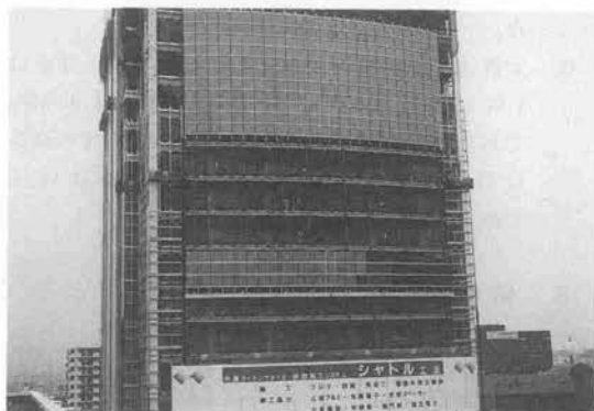
写真-1 外観カーテンウォール自動施工システム
