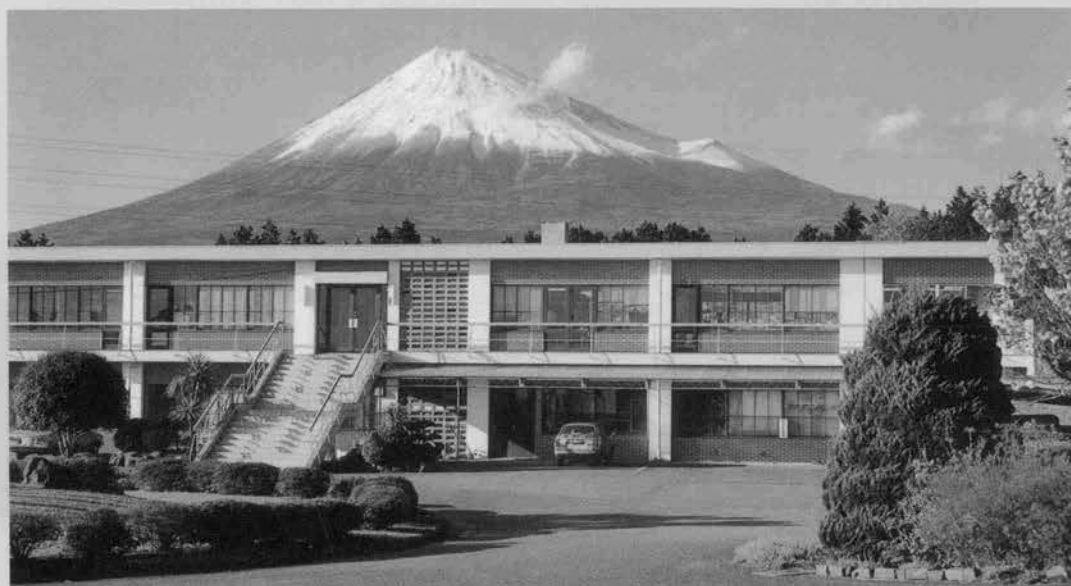
富士山を背にした建設機械化研究所本館
