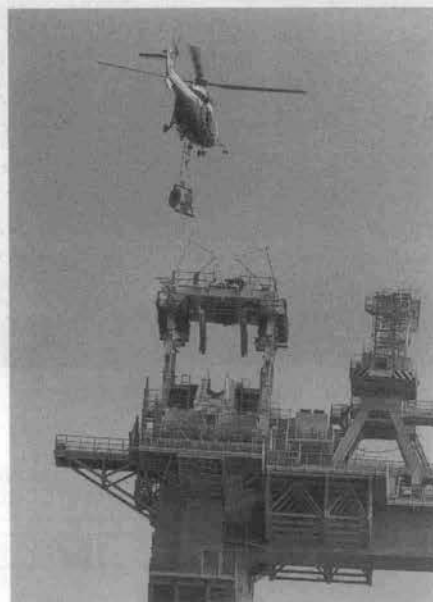
写真-3 パイロットロープ渡海の状況
