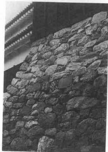
写真-6 野面石積（穴太衆積み）：犬山城
