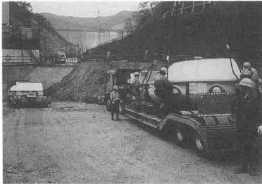
写真-2 現地に搬入された TBM
