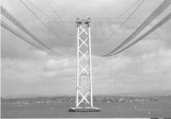
⇨キャットウォークロープの 架設中の状況
