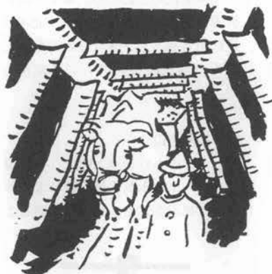
図-41 丹那トンネルの初期のずり出し
