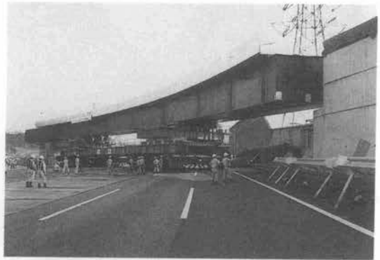
写真-3 自走台車による架設状況
