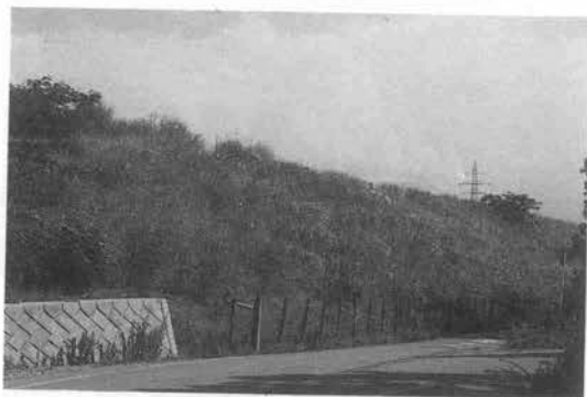
写真-1 草刈施工前の法面
