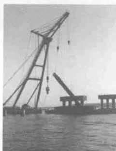
杭切断後の撤去
