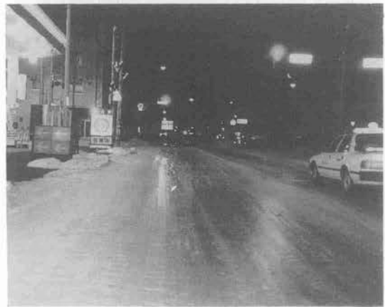
写真—6 処理前の路面状況
