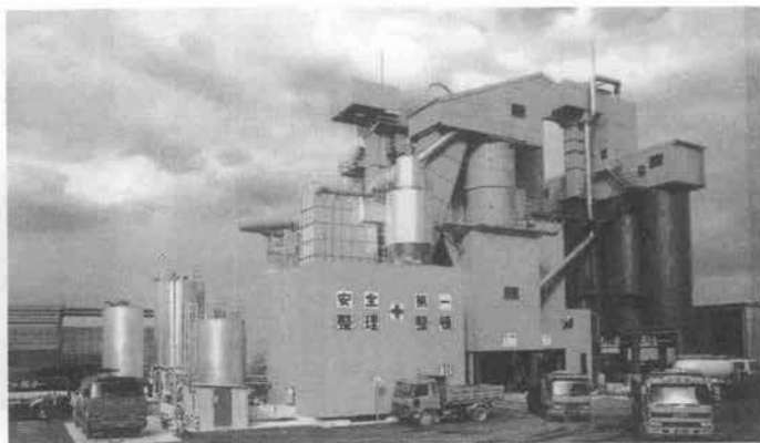
写真—2 都市型プラント能力400 t/h, ホットミックスサイロ120 t×5基
