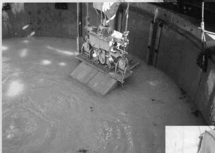
⇨ 水中掘削状況
