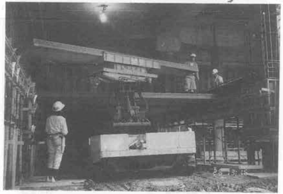
写真-3 ハーフPCa床版の据付け作業
