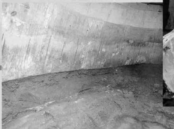
♡ 刃口下掘削後の状況(気中)
