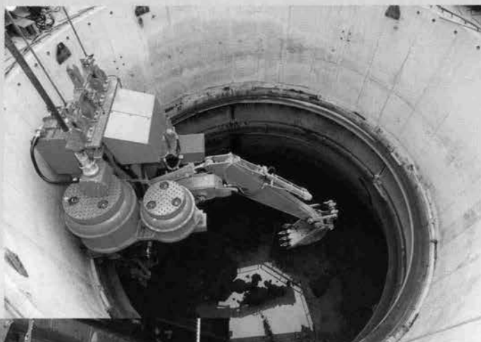
硬質地盤掘削状況(気中) ⇨
