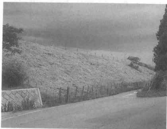
写真-3 草刈施工後の法面
