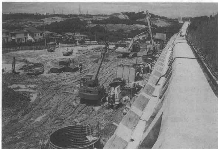
写真-2 神戸市の深礎工事現場
