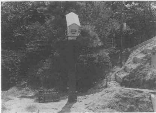
写真-21 監視用テレビカメラ
