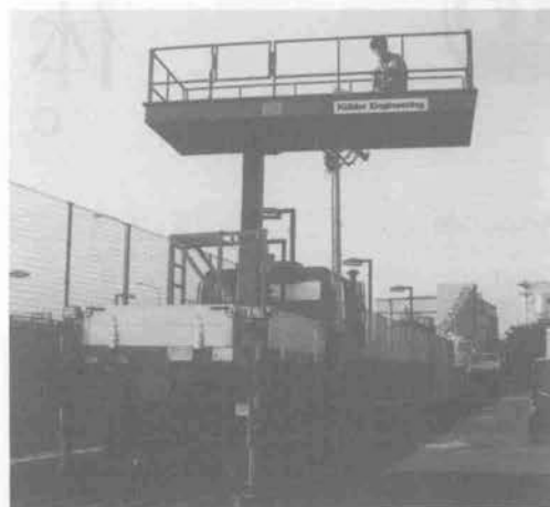
高所作業装置
