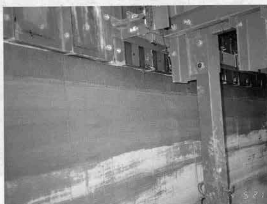
⇨ 脱型後のコンクリート躯体
