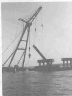
杭切断後の撤去
