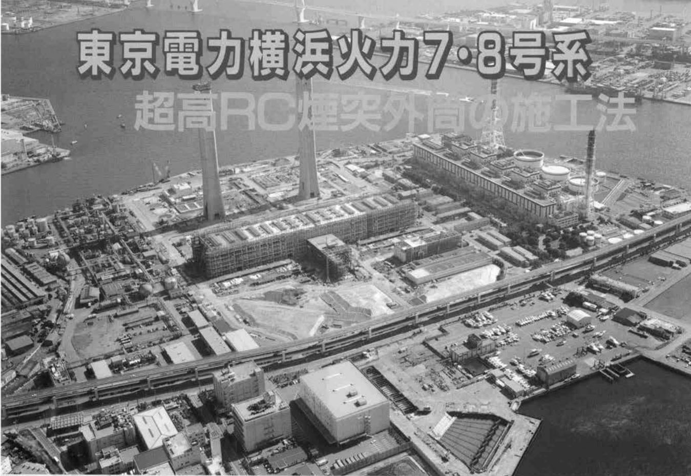
⇨横浜火力発電所全景
