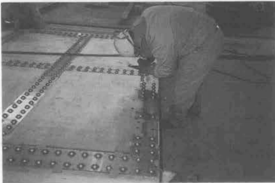
写真-17 擬似リベット施工状況
