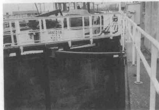
写真-11 オランニエ開門開閉機
