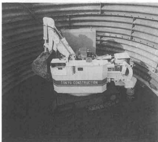
写真—1 深礎工事ロボット
