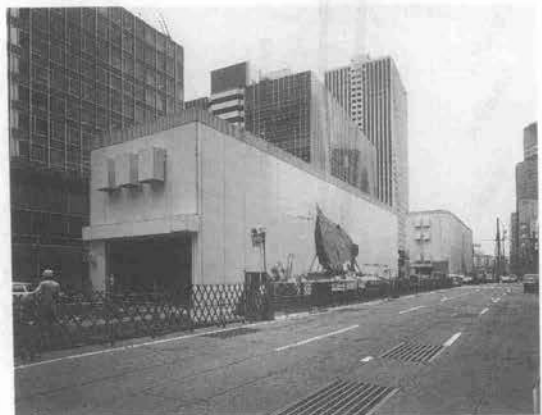
写真-1 基地防音建屋
