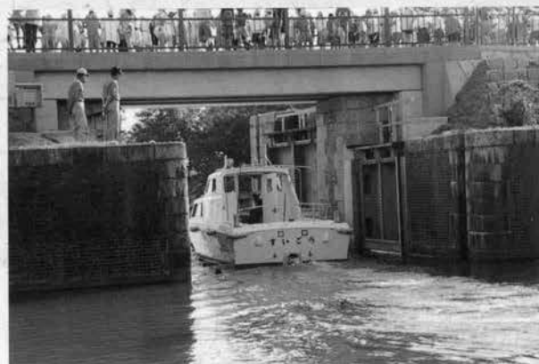
⇨ 新閘門扉を通過する船
