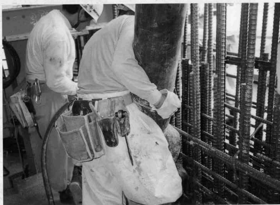
⇨ シュートによるコンクリート打設
