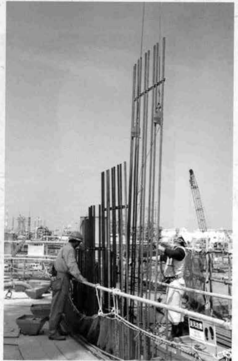
⇨上段作業床での 主筋(たて筋)配筋状況
