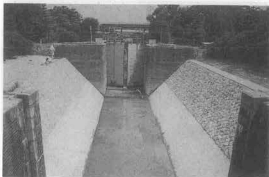
写真-14 閘室のり面
