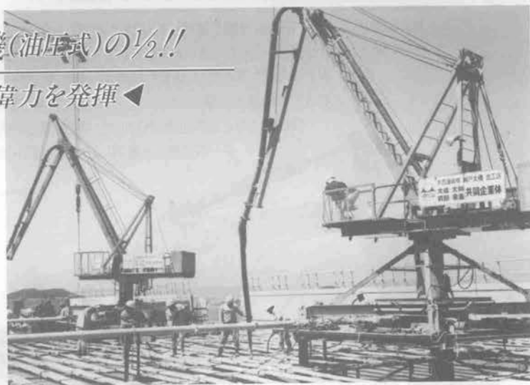
(本四架橋現場設置例)
