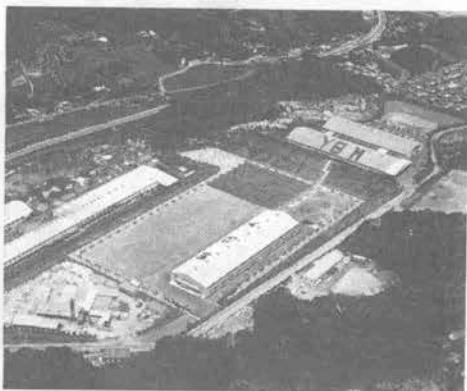
岸山工場全景
