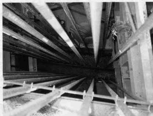
⇨ コンクリート打設天端
