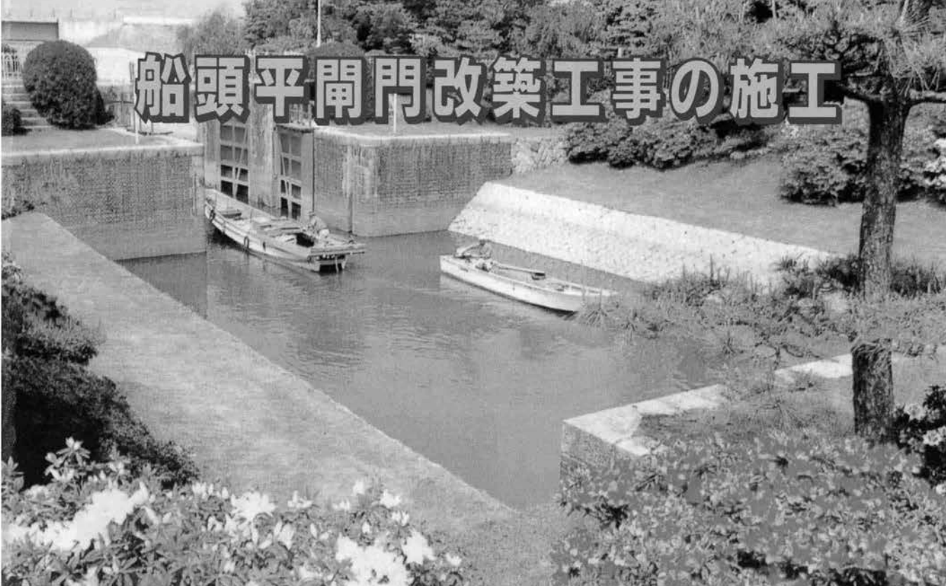
⇨旧閘門扉通船状況
