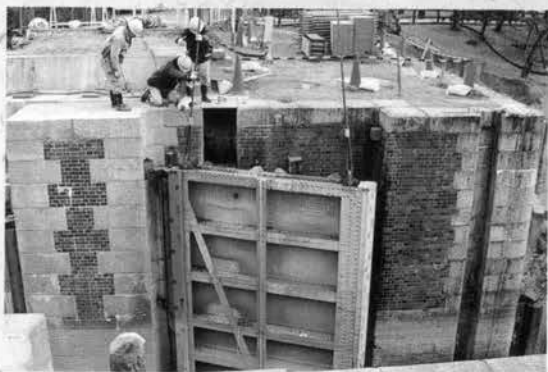
⇨旧閘門扉撤去状況
