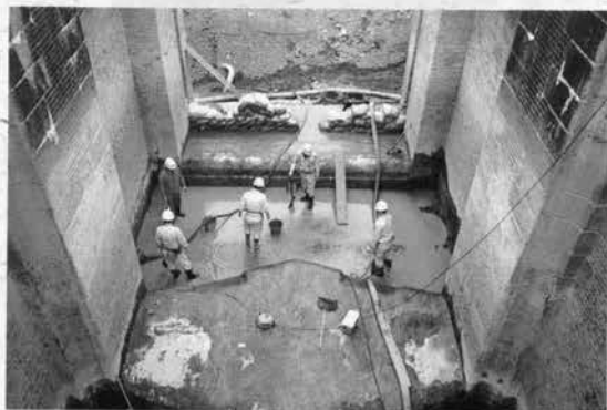
⇨旧閘門扉撤去後
