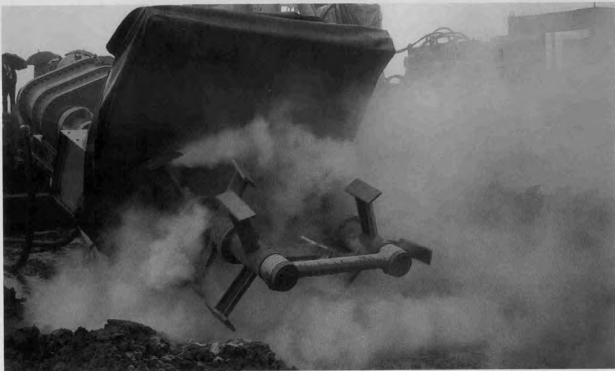
浅層混合処理機
