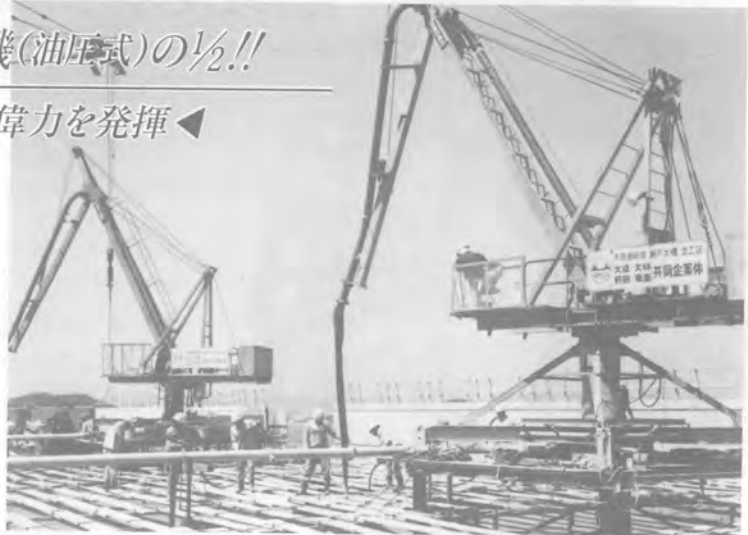
(本四架橋現場設置例)
