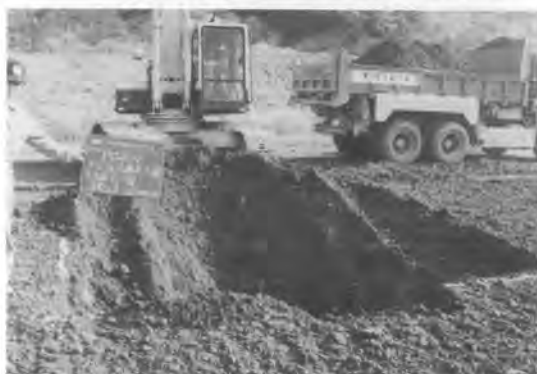
写真三 遠隔操縦建設機械に関する調査試験 (ラジコンバックホウの遠隔操縦による掘削・積み込み状況)
