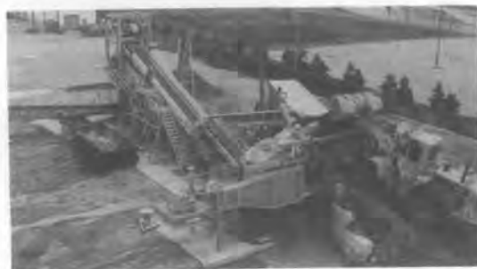
写真三 Grasanのリサイクルシステムは鉄筋、金網、釘を取除ける。
