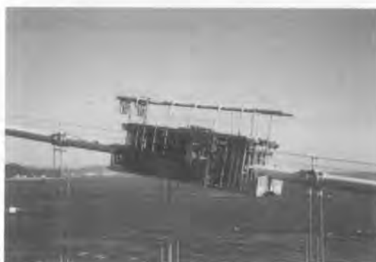
写真四 ケーブル塗装試験工事 (大鳴門橋におけるラッピング作業車)
