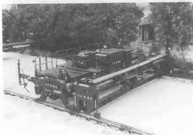
写真-5 コンクリート舗装機
