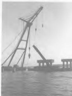
杭切断後の撤去
