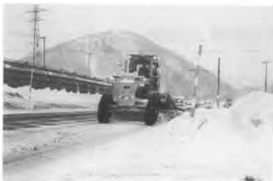
写真一 除雪グレーダの高度化技術に関する検討 (除雪グレーダによる実際の除雪作業状況)
