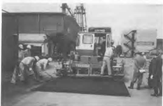
写真一八 無型枠施工装置を装着したアスファルトフィニッシャーによる舗設
