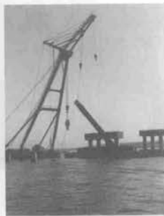
杭切断後の撤去
