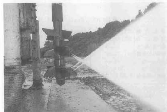
写真-3 固化材スラリーの噴射状況
