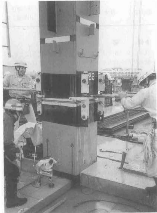
写真-1 建入れ直し作業
