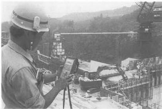
写真-2 打設場所でのハンディターミナルによる作業状況
