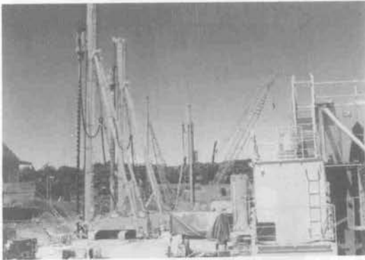
写真—2 施工ヤード
