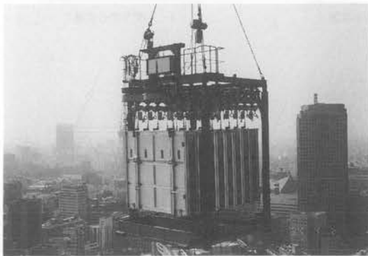
写真二 本システム揚重状況
