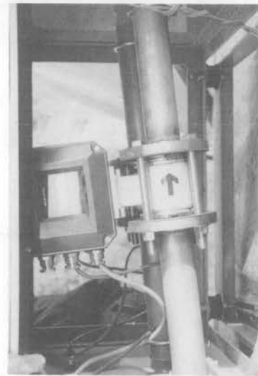
写真-5 注入量計測・電磁式流量計
