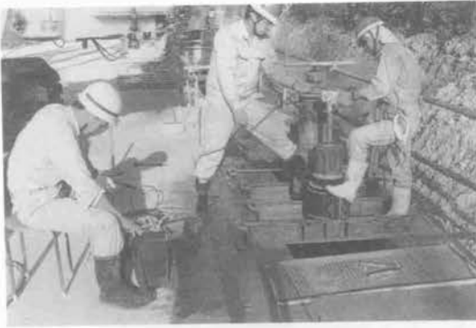
写真-7 挿入式傾斜角度測定
