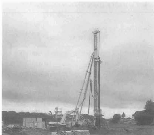
写真-1 JACSMAN 施工機
