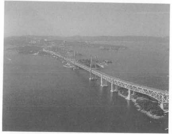
写真-7 瀬戸大橋
