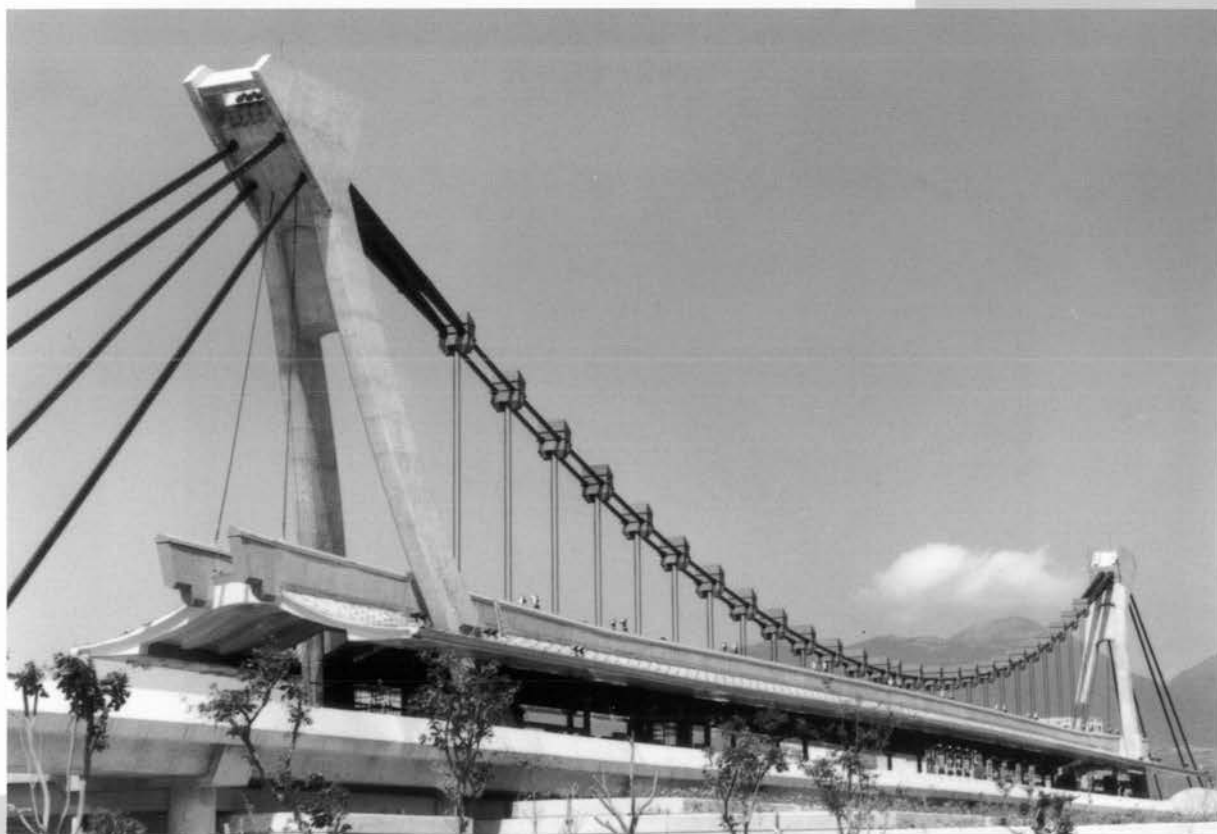
⇨ 竣工時の剣潭駅（ドラゴンボート）
