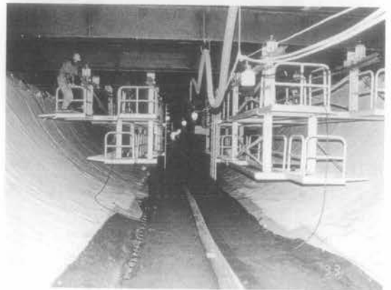
写真-3 下部半断面防水シート工
