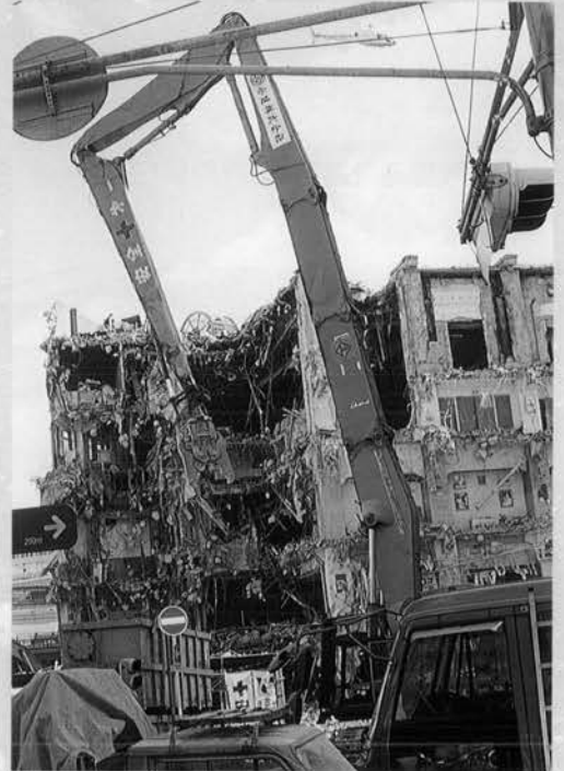
⇨ 神戸市三宮駅 阪急神戸会館ビル解体作業 30t級 20mロングブーム、カッタ使用
