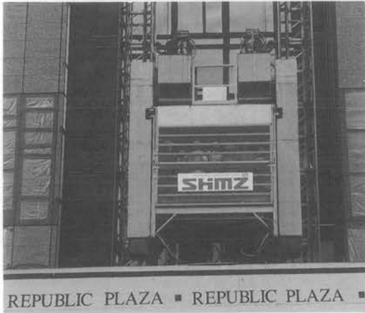
写真—7 4tエレベータ作業員輸送状況
