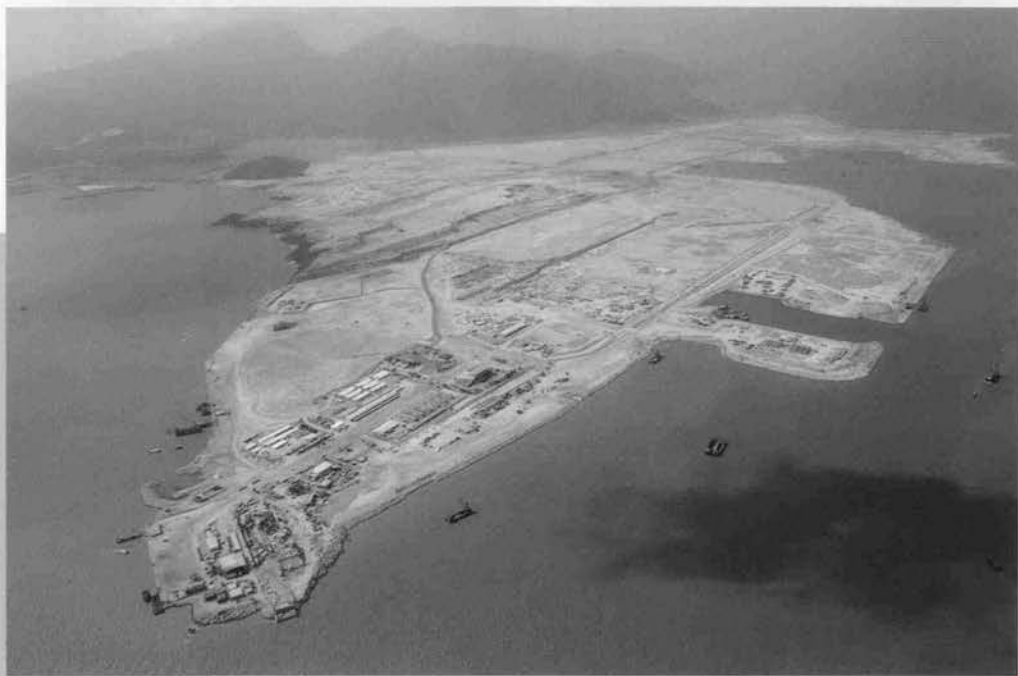
⇨ 掘削・埋立状況
