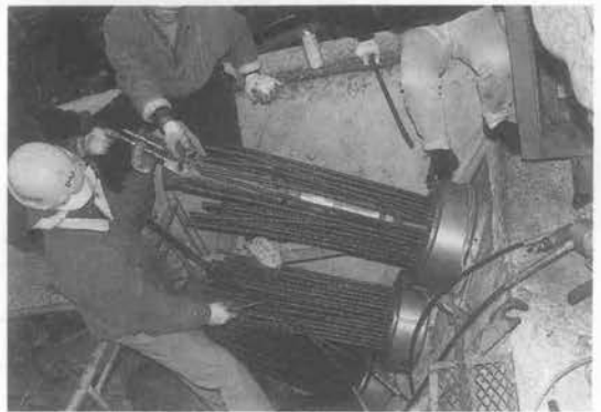
写真-6 バックステイケーブルジャッキ
