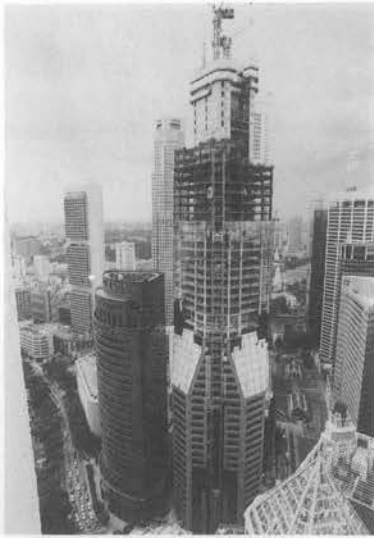
写真—6 現場全景，エレベータ設置状況（1994年7月）
