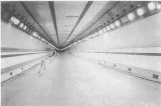
写真-5 完成間近のトンネル
