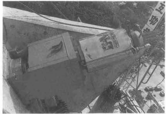
写真-5 バックステイケーブルジャッキ
