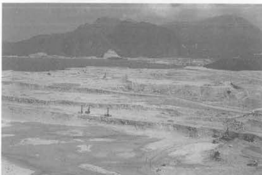
写真-4 CLK島掘削ベンチ
