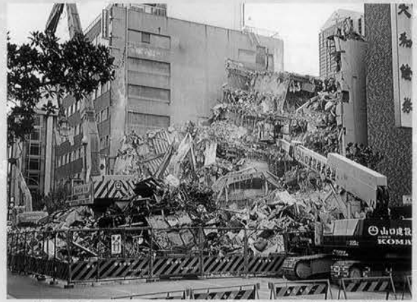
⇨ 神戸市三宮、ビル解体作業 リフト車は撒水 用であるが、水がないため作業監視のみ
