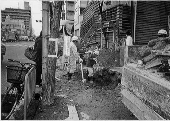
⇨西宮市 ライフライン(水道)の復旧作業
