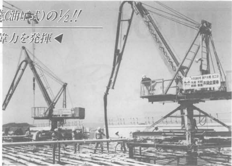
(本四架橋現場設置例)
