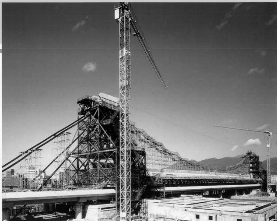
⇨ 工事中の剣潭駅（ドラゴンボート）
