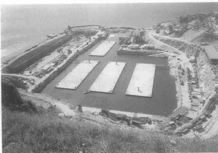
写真-3 ドライドック注水状況
