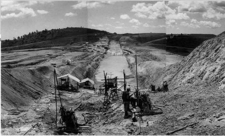
↳レフトウイングダム 施工状況
