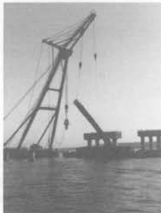
杭切断後の撤去
