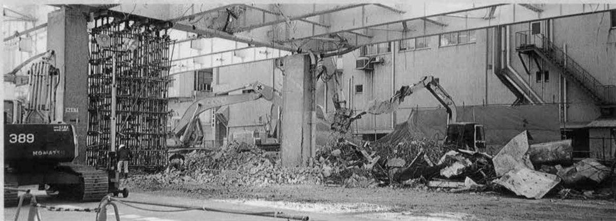
⇨ 阪神高速道路3号神戸線(三宮附近)高架橋撤去作業、バケット、カッタ、グラブプル使用
