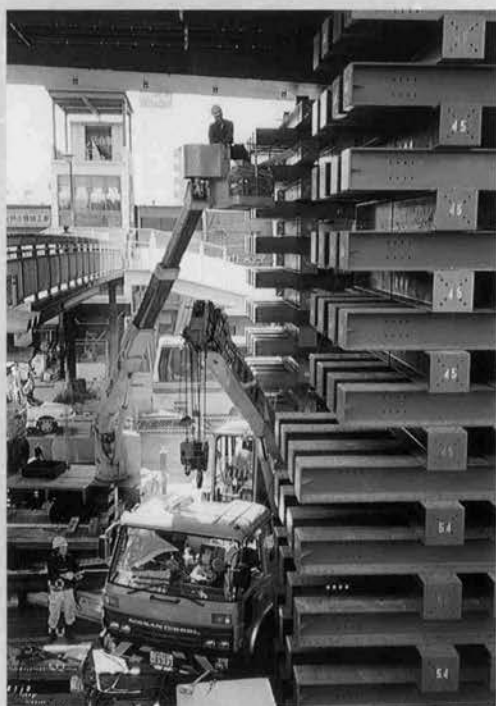
⇨ 阪神高速道路3号神戸線 高所作業車によるサンドル組立作業
