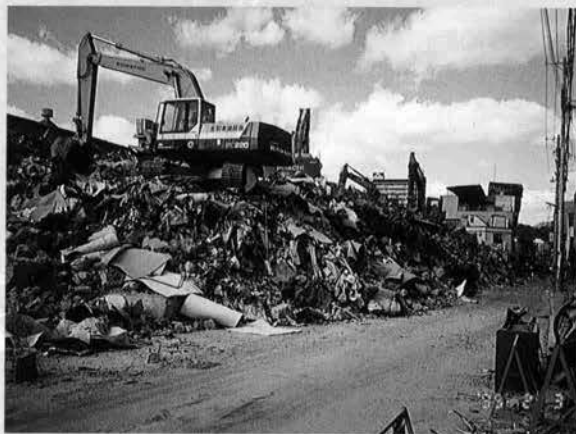
⇨ 神戸市兵庫区 倒壊工場の上を廃材置場として使用
