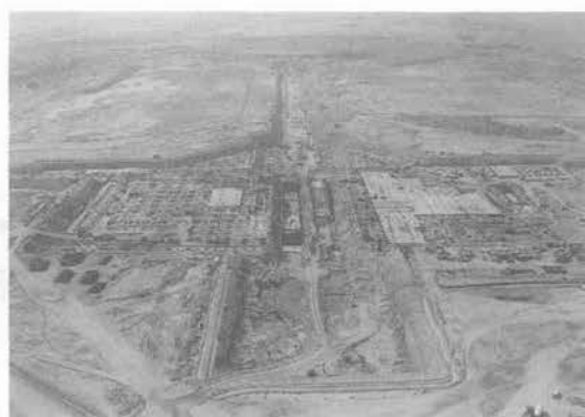
写真—7 ターミナル・ビルディング建設
