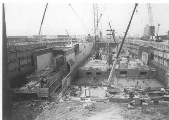
写真-2 構築全景
