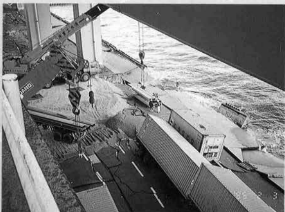
⇨ 神戸市摩耶大橋上から見た 摩耶埠頭岸壁の復旧作業
