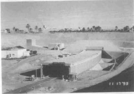
写真-1 西側坑口付近
