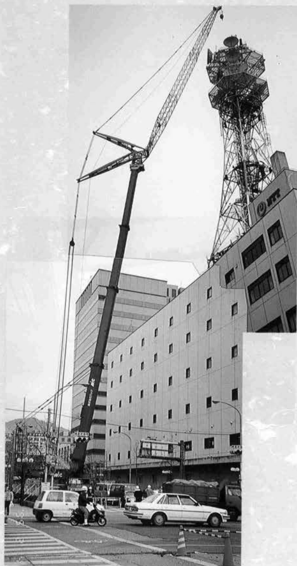
⇨ 神戸市三宮 NTTアンテナ解体作業 800t吊オールテレーンクレーン現地組立完了
