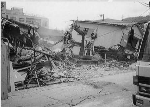
⇨神戸市東灘区 木造人家の解体作業 (グラップルが有効)
