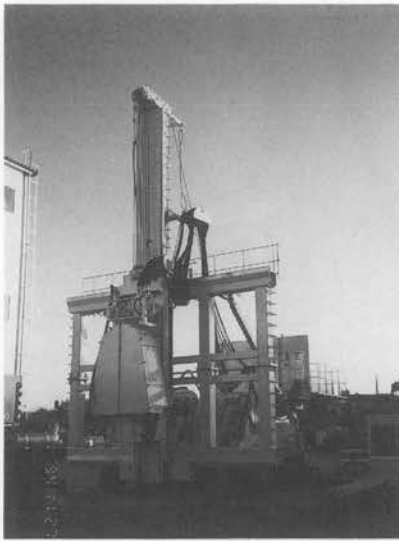
写真-5 連続壁造成機 トレーダ
