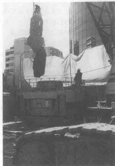
写真—4 大口径掘削機 ロダム
