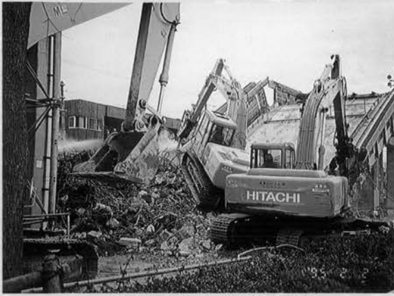
⇨ 山陽新幹線 西宮市甲東園 落下した床版の破碎作業
