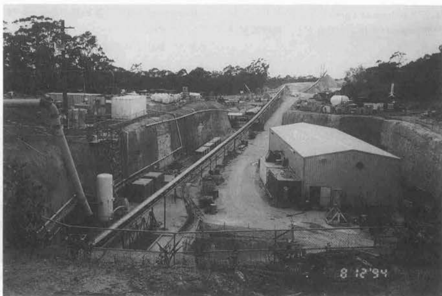
写真-1 坑口付近
