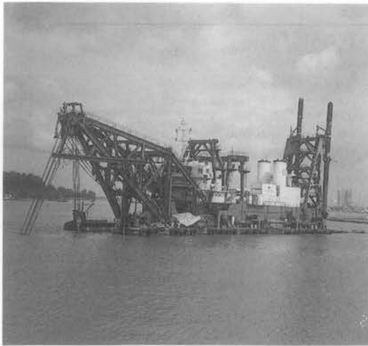
写真-3 フローティングドック仕様製作状況
