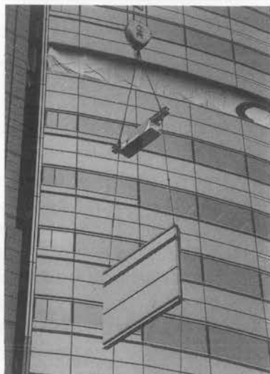
写真-1 つり荷の回転制御をする“ジャピタス”
