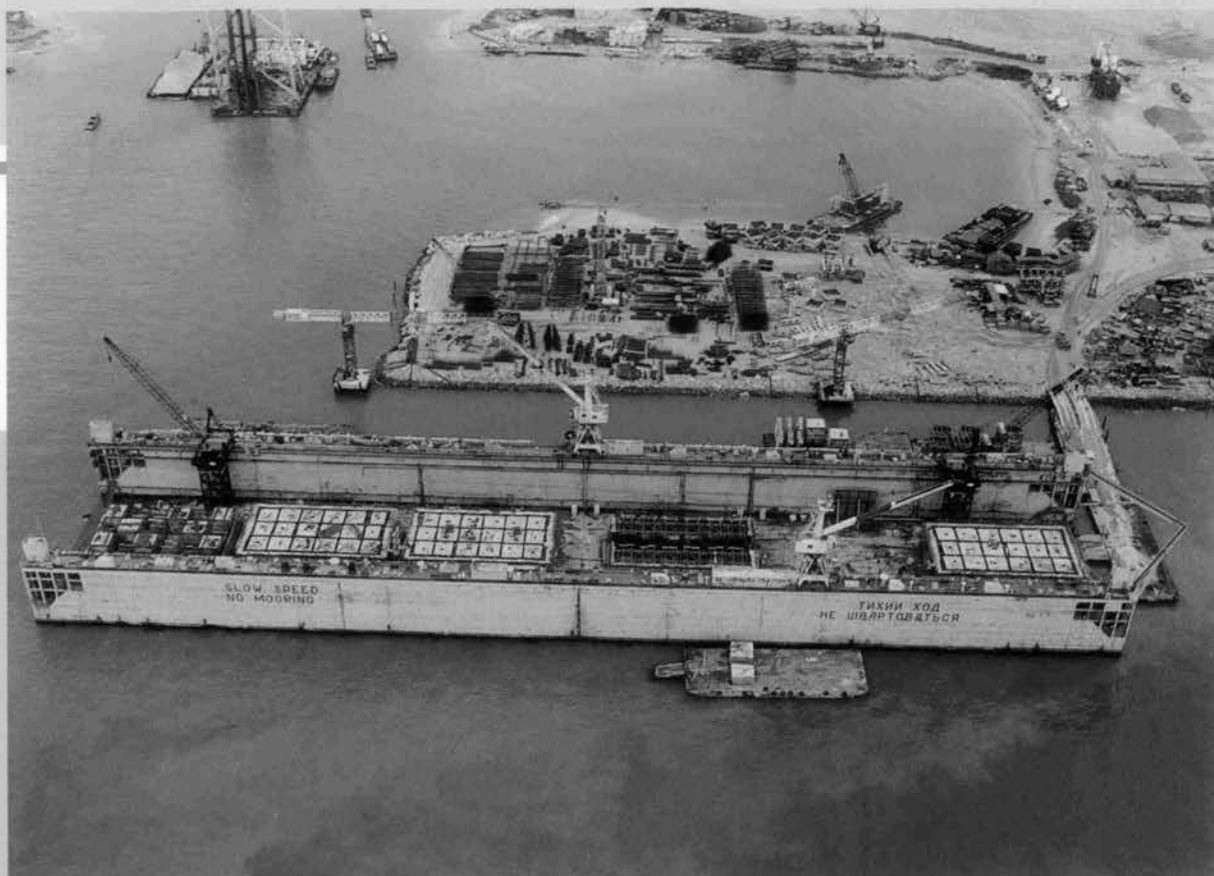
◆フローティングドック ケーソン製作状況
