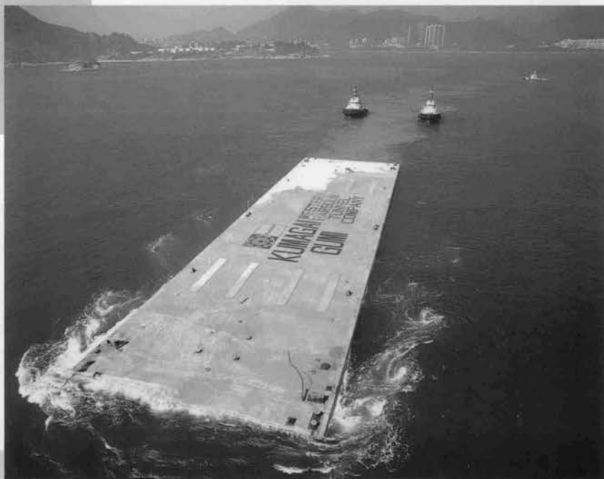
⇨ ドライドックを出て大潭湾（TAI TAM WAN）を雄壮に曳航中の沈埋函
