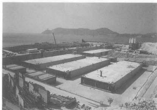
写真-2 沈埋函製作状況
