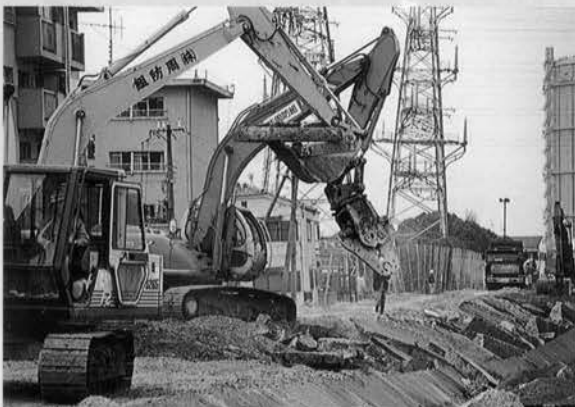
⇨淀川河口部左岸側堤防が最大約3m沈下、護岸 全面破壊約1.8km、油圧圧砕機、ショベル、ダンプ による崩壊護岸処理、緊急盛土
