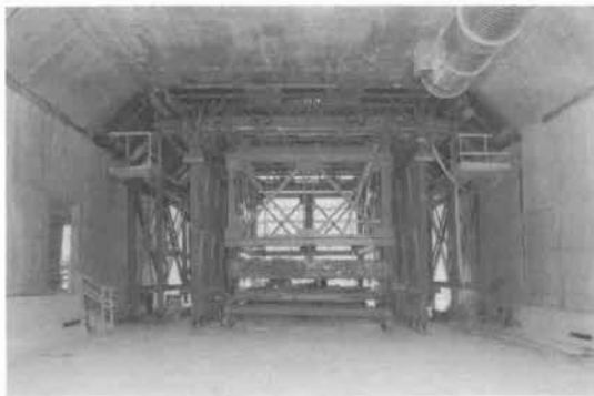
写真-3 移動式大型屋根型枠支保工
