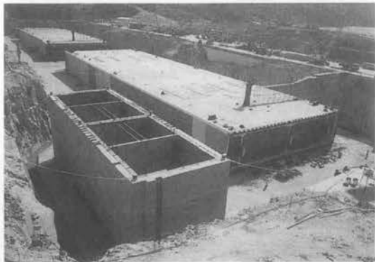
写真-1 ゲートケーソン
