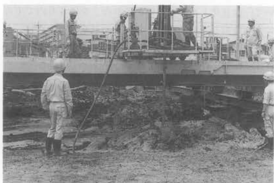
写真-3 施工状況
