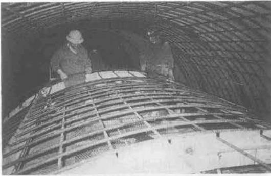
写真一2 鉄筋組立作業
