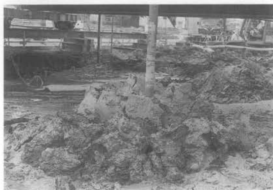
写真-4 排土状況
