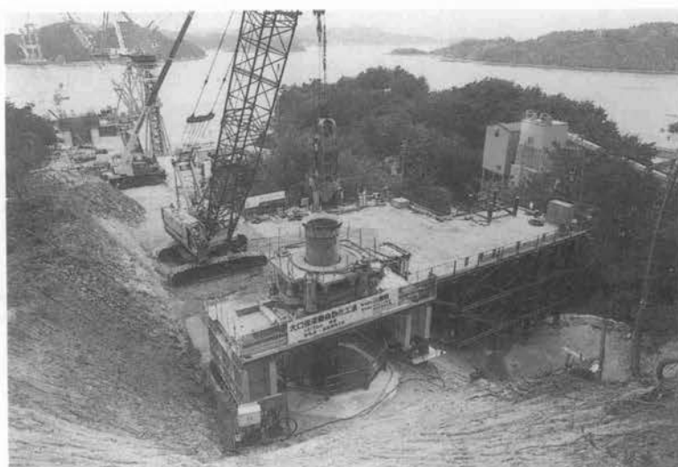
写真-1 スーパー RD 工法施工状況
