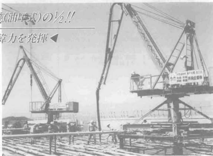
(本四架橋現場設置例)
