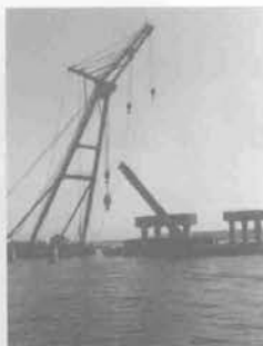
杭切断後の撤去
