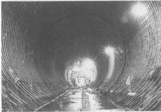
写真一3 鉄筋組立状況
