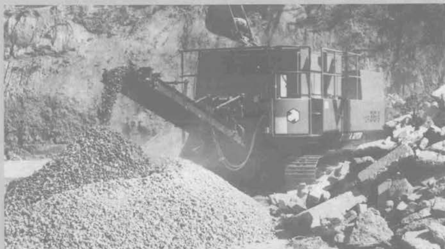
低コストでコンクリートガラを再資源化する!
