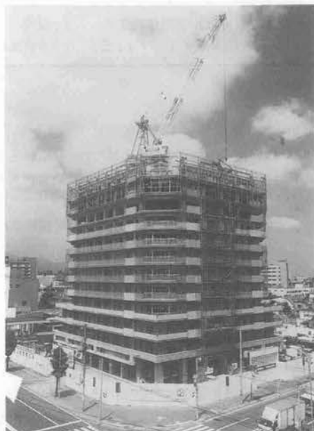
写真-1 稼働状況 (苗穂再開発工事)
