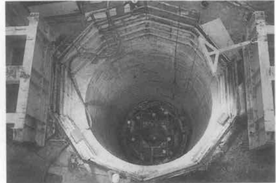
写真-5 施工完了状況
