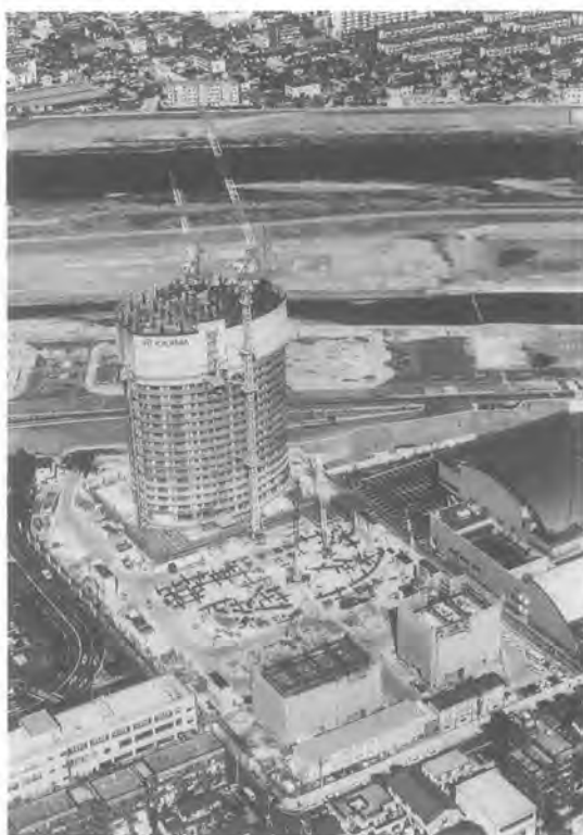
写真-1 ザ・シーン城北工事全景
