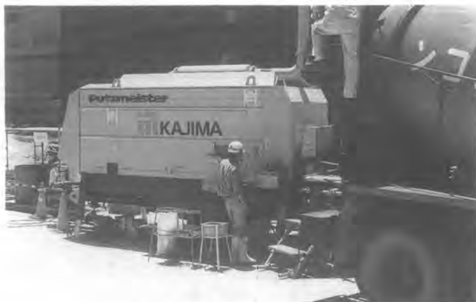
写真-4 高圧コンクリートポンプ
