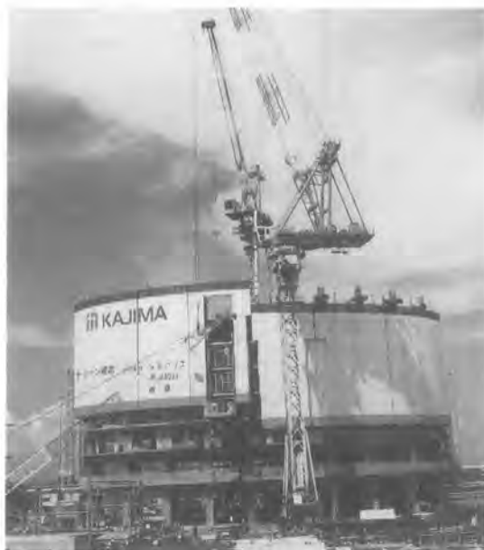
写真-2 自昇式外部養生設備
