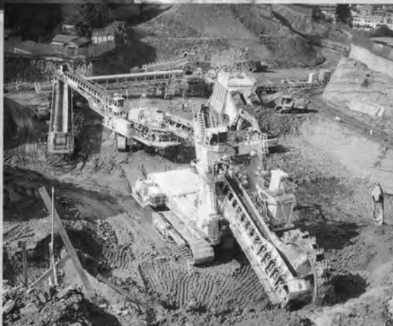
⇨掘削システム (BWE→TWM→MSC)
