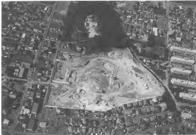
写真一 施工箇所全景
