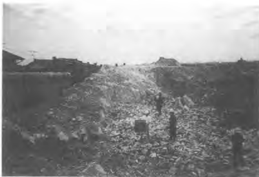
写真-2 岩盤発生状況
