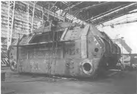
写真-2 製作中のフレーム部
