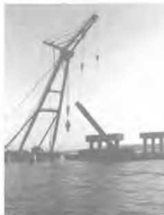
杭切断後の撤去
