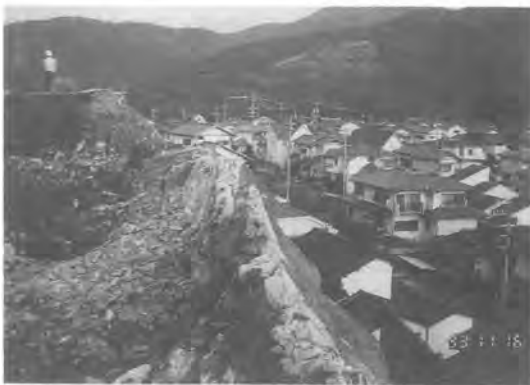
写真-5 現場内より近接住宅地を望む
