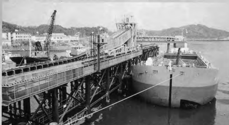
⇨海上運搬積込システム
