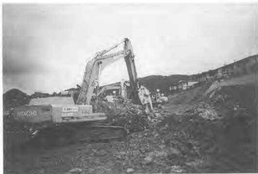
写真—9 岩石破砕機試験工事
