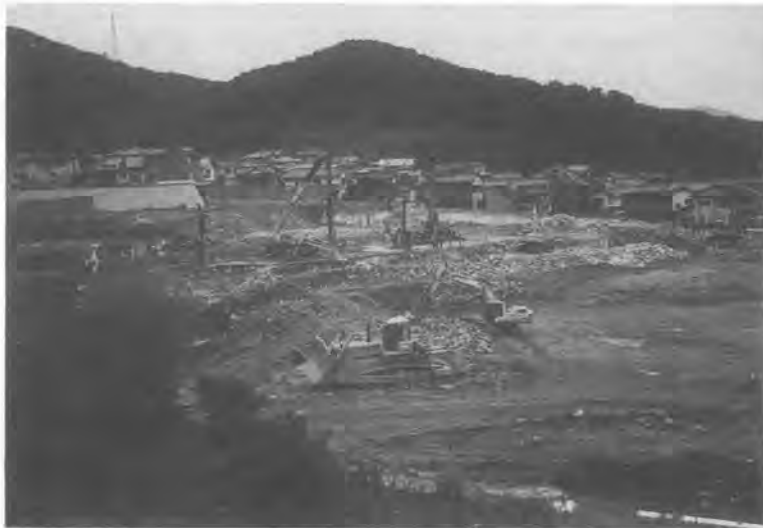
写真-4 KNBB 工法施工状況
