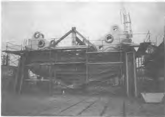
写真-1 製作中のシェル部
