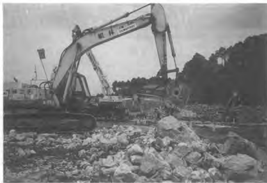
写真—8 小割り状況
