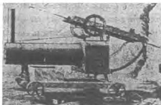
図-3 蒸気式回転さく岩機
