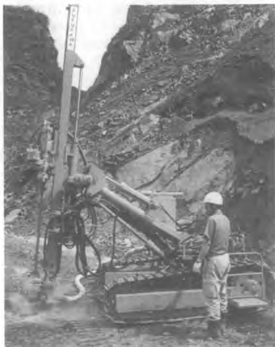
図-18 空圧式クローラドリル
