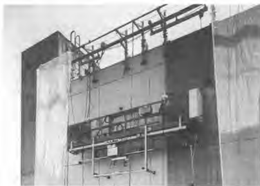
写真-1 塗装ロボット施工状況
