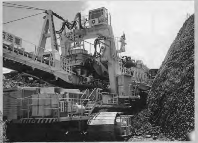
⇨ 後方から見たBWEの掘削状況
