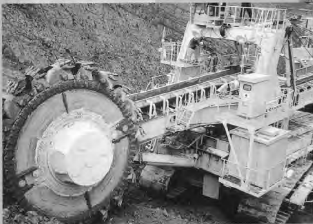
⇨ 斜め前方から見たBWEの掘削状況
