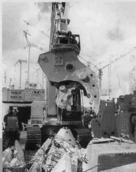
⇨ コンクリート破砕機
