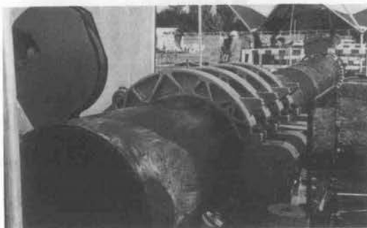
Fusion グループの自動突合せ溶接
