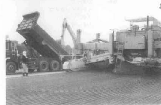
写真-6 整形仕上げ
