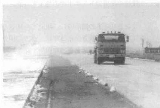
写真—14 養生散水
