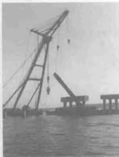
杭切断後の撤去
