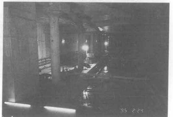
写真-5 仮柱部の撤去部分
