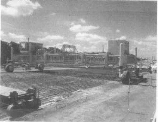
写真—2 ブレーサスプレッタ PS-60 スリップフォームベーパー GP-3000 キュアリングマシン TC-400
