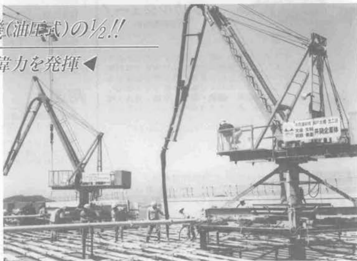
(本四架橋現場設置例)
