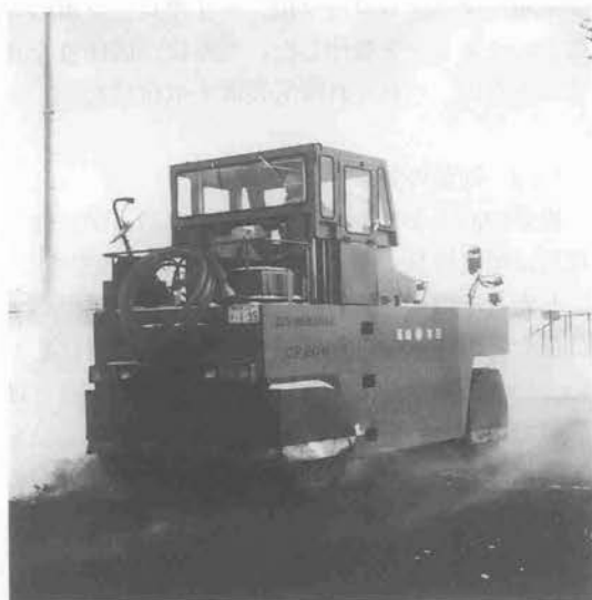
写真-5 熱風加熱装置を装備したタイヤローラ
