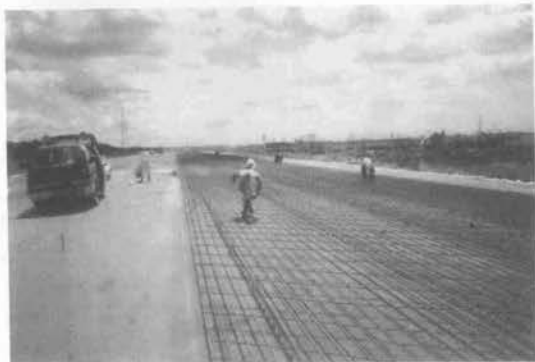
写真-4 鉄筋配置
