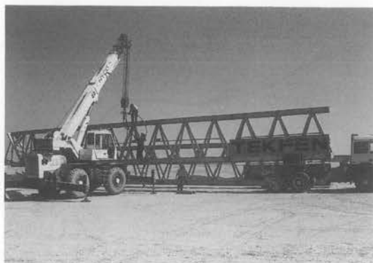
写真-5 移動後の取降ろし中のトルコ製手延桁(アダナ～ガジアンテップ道路)
