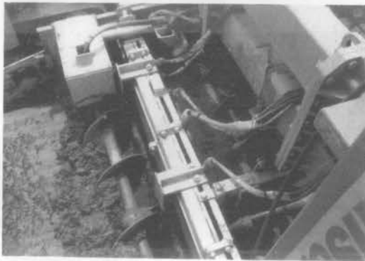
写真-9 大オーガ ストライクオフ バイブレータ 小オーガ
