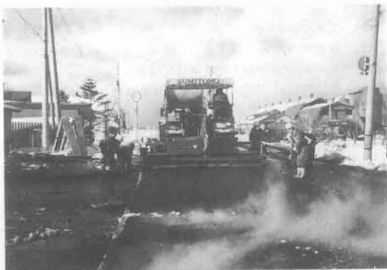
写真-4 寒冷地用フィニッシャによる施工状況
