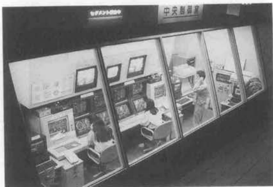
写真-1 システム全景
