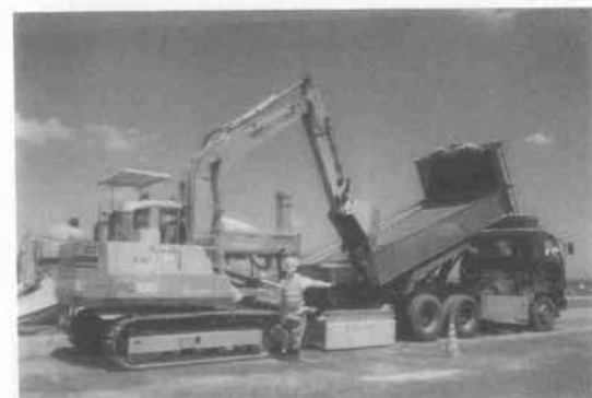
写真-5 生コンクリート荷卸
