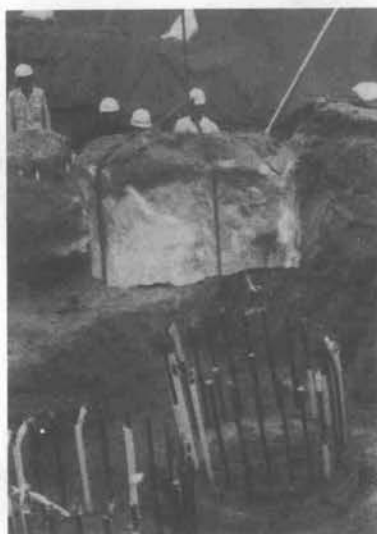
写真-2 杭頭撤去状況
