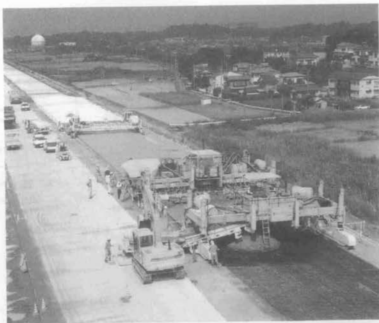
写真-1 東関東自動車道市原舗装工事
