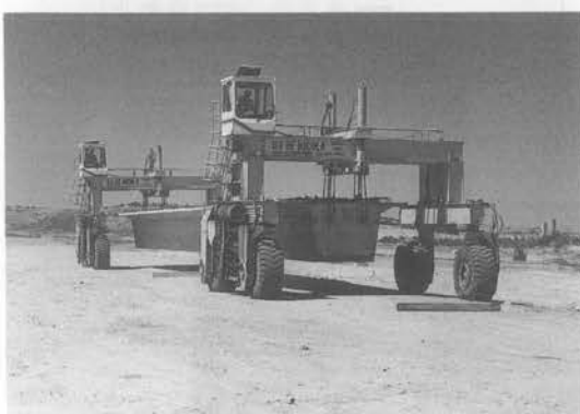
写真-3 エレファントと名付けられたイタリア製工事車両(アンカラ周回道路)
