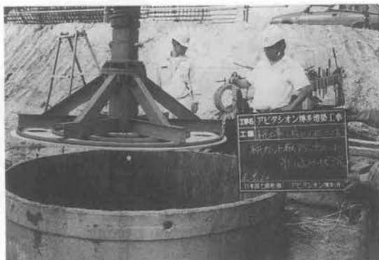
写真-1 カット板つり込み状況
