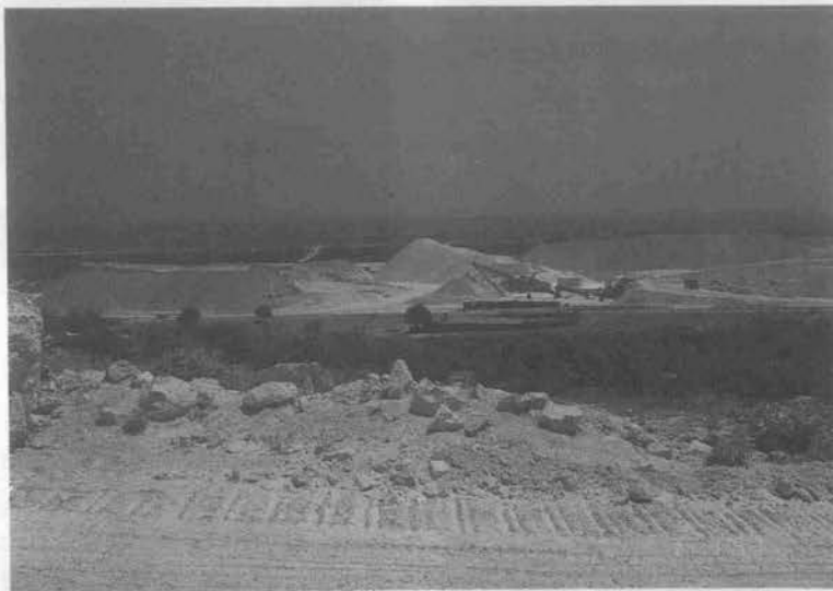
写真一 骨材採取場より骨材ヤードを経て建設中の高速道路を望む（イズミール～アイドゥン道路）
