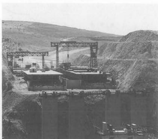
写真-6 ダム湖の両側で組立中のロシア製鋼床版箱桁(アンカラ周回道路)
