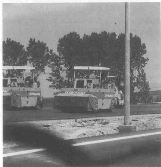
写真-8 アスファルト舗装の締め固め（クナル～エディルネ道路）
