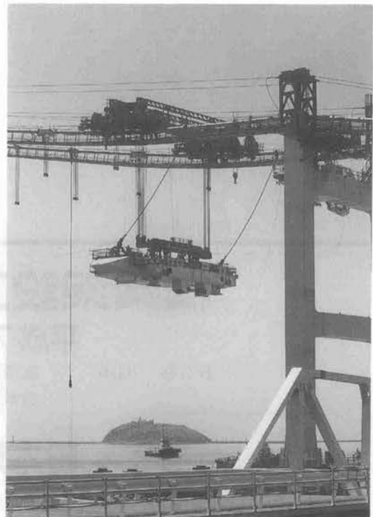
写真-2 補剛桁第1ブロックの架設
