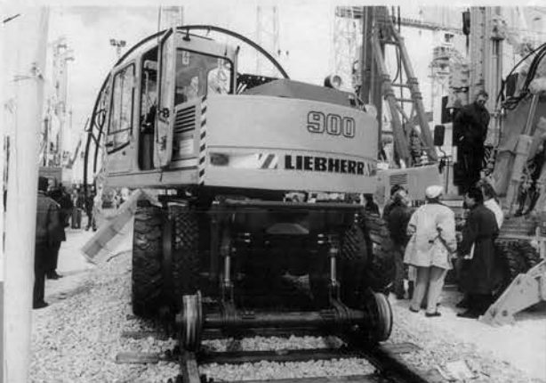
⇨ 路床作業用に鉄道レール走行仕様の油圧ショベル
