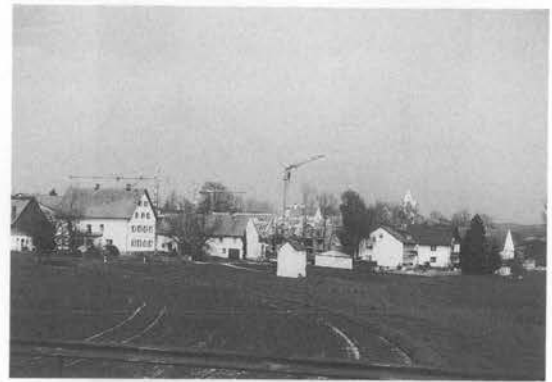
写真-12 住宅建設にはタワー式移動クレーンを使う
