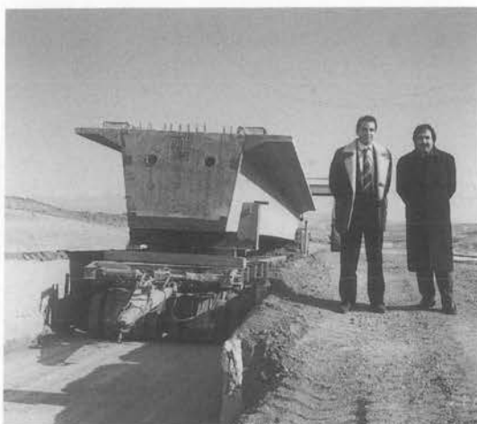
写真-2 PC 桁仮置ヤードへの搬出入装置(アンカラ周回道路)
