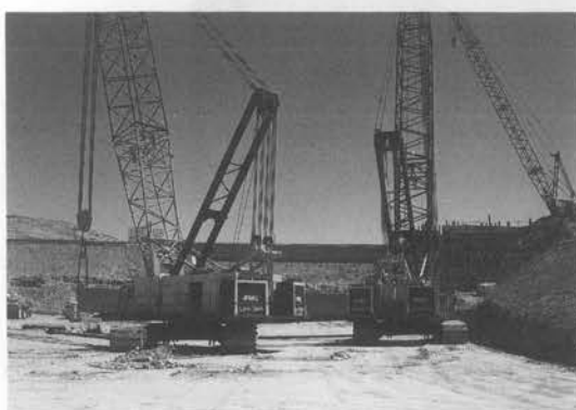
写真-4 PC 桁を架設するドイツ製クレーン車(アンカラ周回道路)
