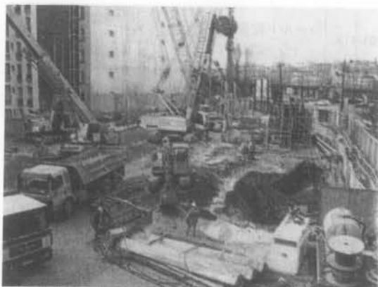
日本文化センターはパリの中心部の狭い所で建設中
