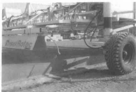
写真—13 養生剤散布
