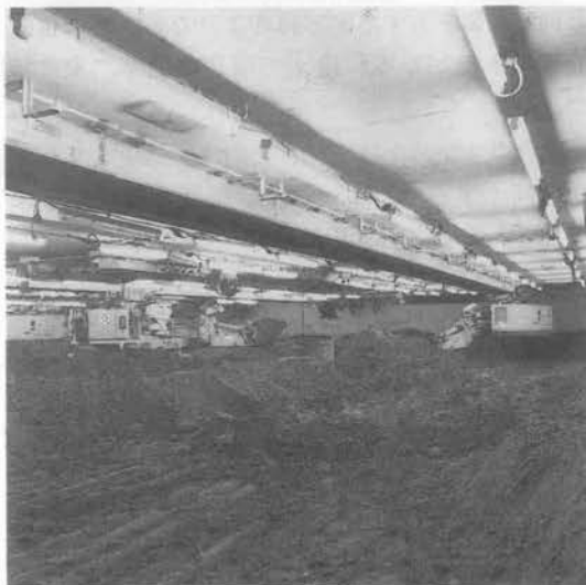
写真2 函内無人掘削機の稼働状況
