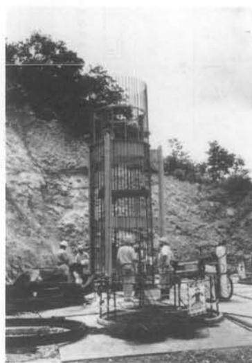
写真—8 鉄筋組立・建込み装置
