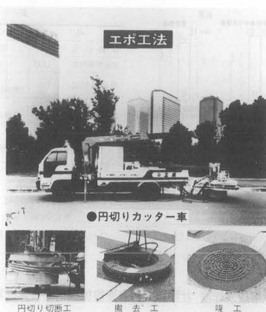
写真-1 エポ工法
