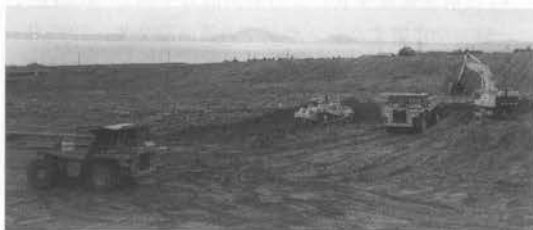
写真-1 施工状況
