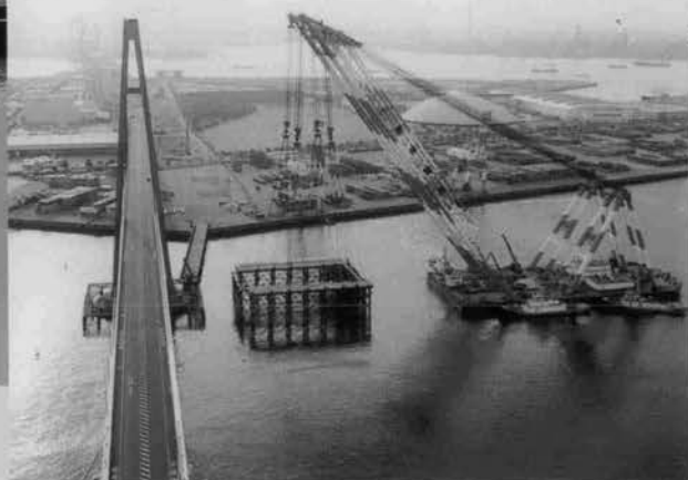
⇨ジャケット据付状況
