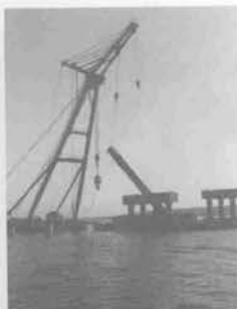
杭切断後の撤去
