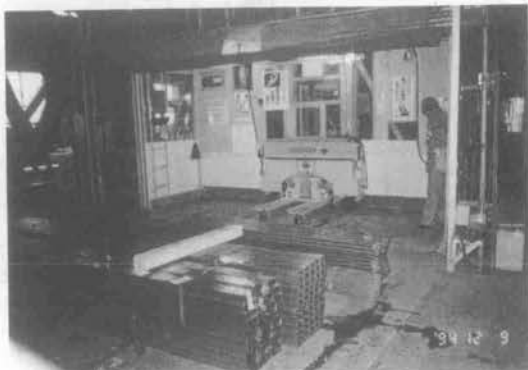
写真—6 人貨エレベータで待機
