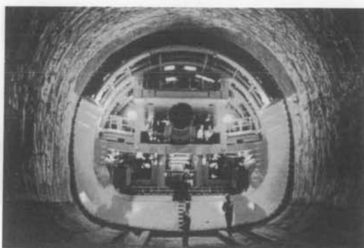
写真一 ECL 工法の稼働状況
