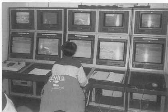
写真-2 コントロールルーム 作業状況
