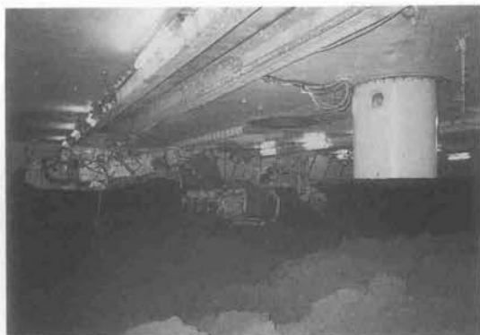
写真3 大気圧カプセル（手前の黄色い筒）での遠隔操縦作業
