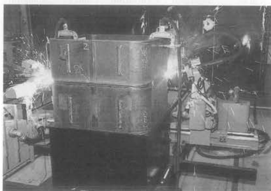
写真一 溶接作業中
