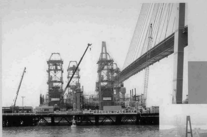
⇨P3ケーソン工事
