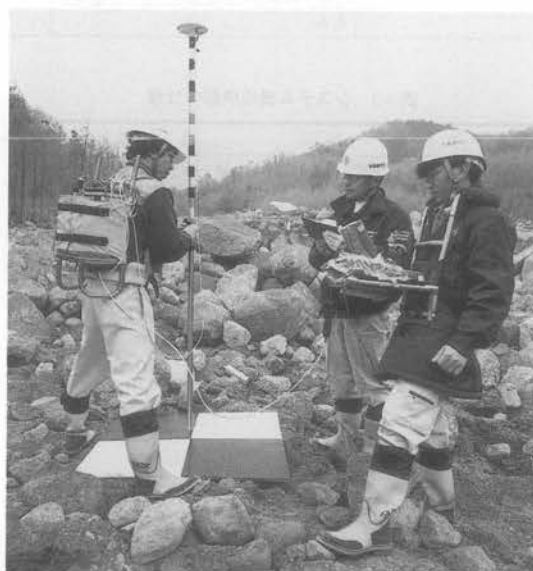
写真-3 PTK-GPS による基準点設置
