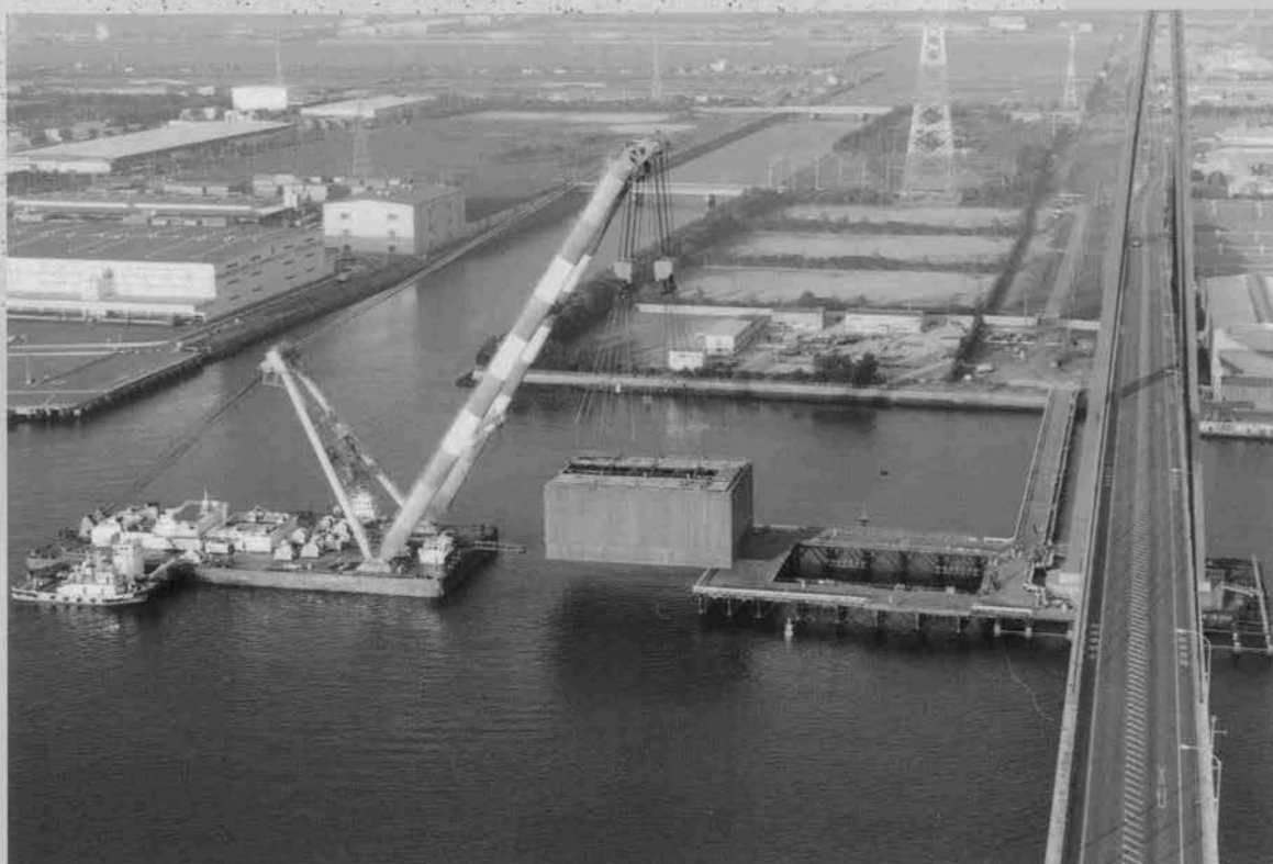
⇨ 鋼殻据付状況
