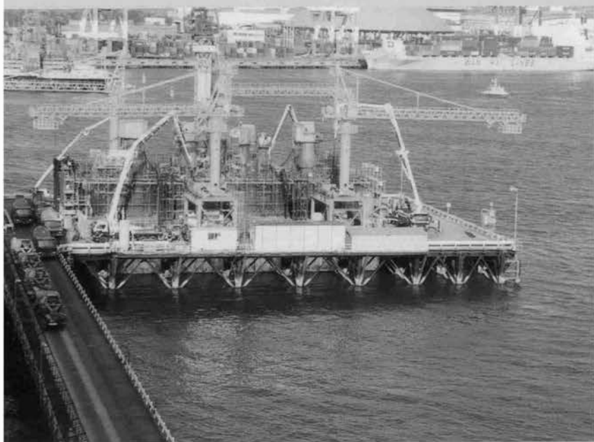
⇨P2ケーソン工事
