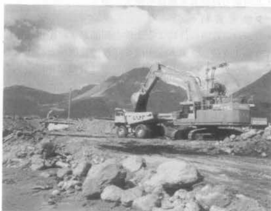
写真-1 施工状況（雲仙・普賢岳）
