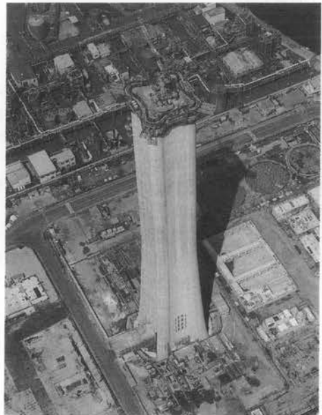
写真-19 新型スリップフォーム (New SVETHO) システム
