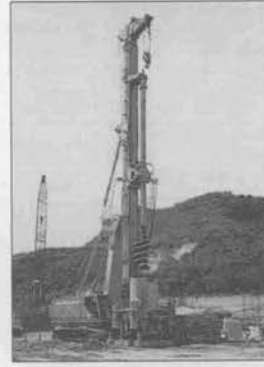
ソーマススーパードリル工法 SOMAS Super Drill Method
