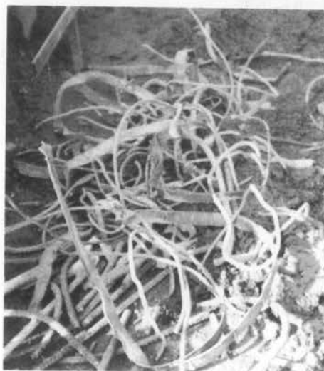
写真-8 二軸同時軸式ドーナツオーガによる旧基礎ぐい破砕工事（工事で破砕された場所打ちぐいの鉄筋類）
