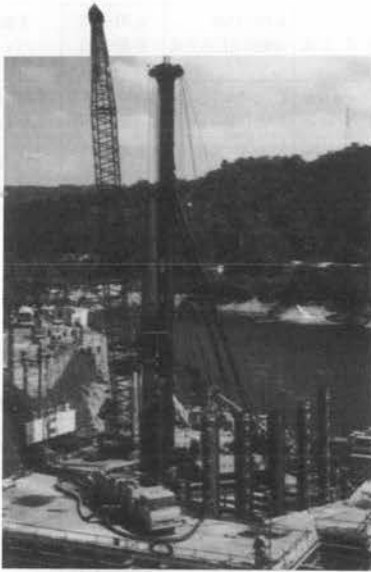
写真-4 重錘掘削機
