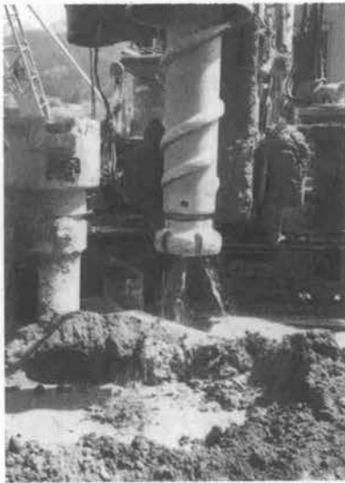
写真-8 オーガ型エアハンマ掘削機
