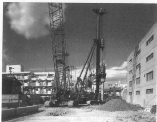
写真-7 二軸同時軸式ドーナツオーガによる旧基礎ぐい破砕工事
