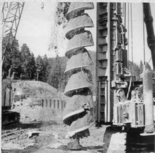
◆二軸同軸式ドーナツオーガ(SDA型)による場所打ちくい破碎工事
