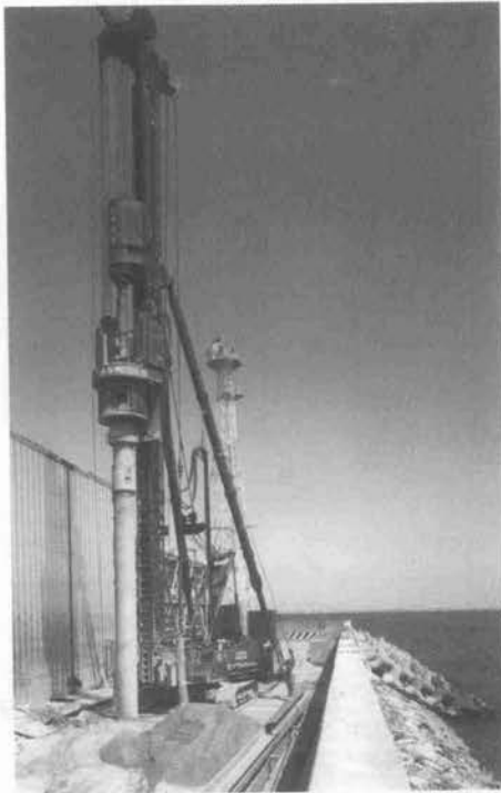
写真—6 二軸同軸式ドーナツオーガによる護岸用捨石・張石 破碎工事
