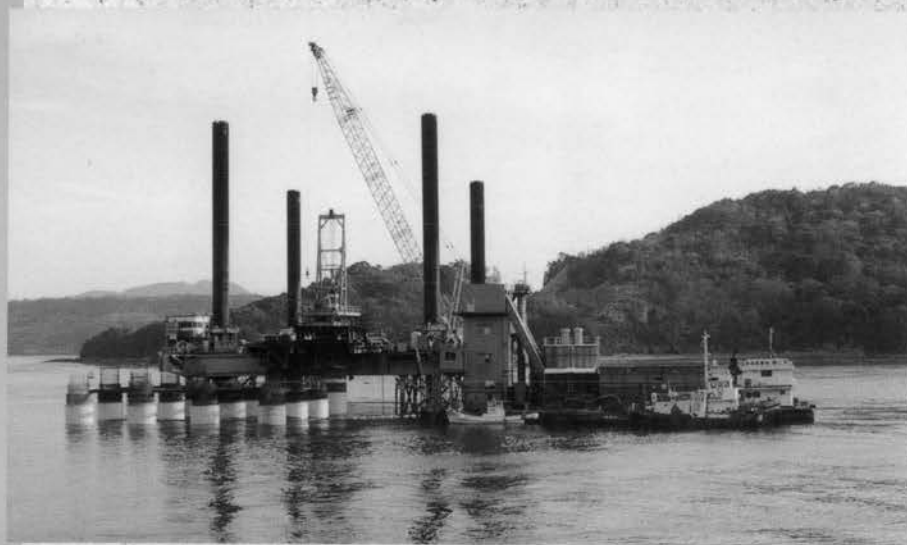
⇨P 3 基礎杭施工，中詰コンクリート打設
