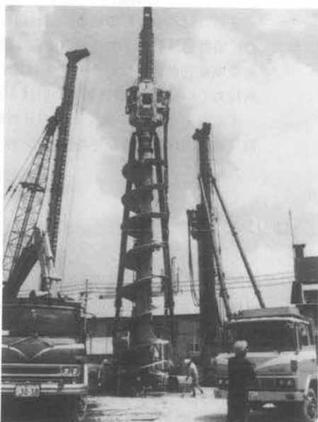
写真-1 ロックオーガ工法
