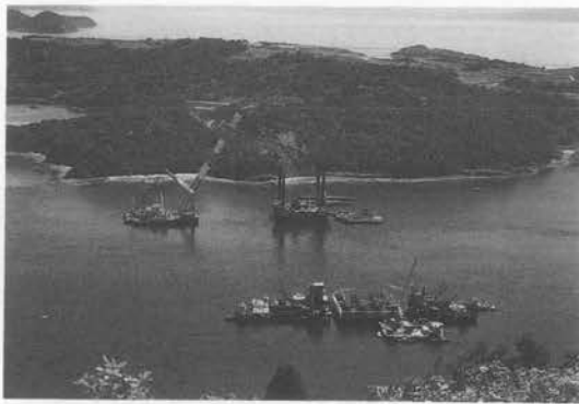
写真-1 基礎杭施工状況
