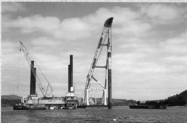
⇨P 4 基礎杭施工：300t起重機船によるケーシングパイプ建込み
