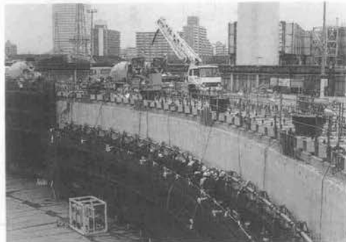
写真—18 逆打ちコンクリート自動打設システム施工状況
