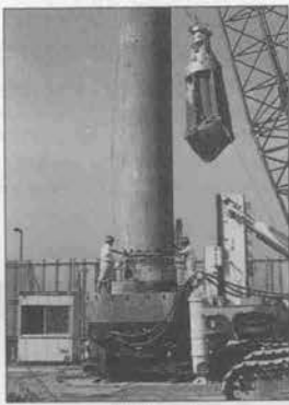
ロダム工法 RODAM method
