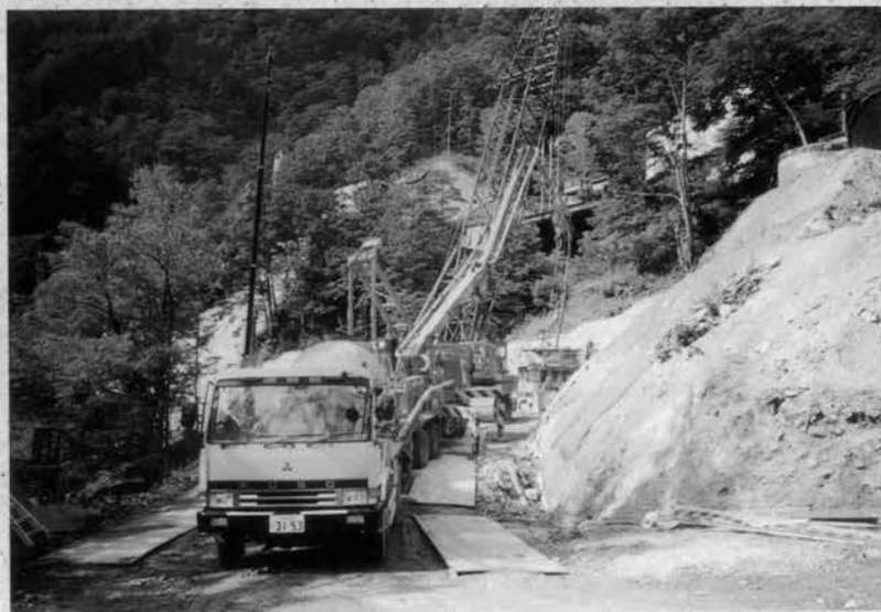
コンクリート打設状況
