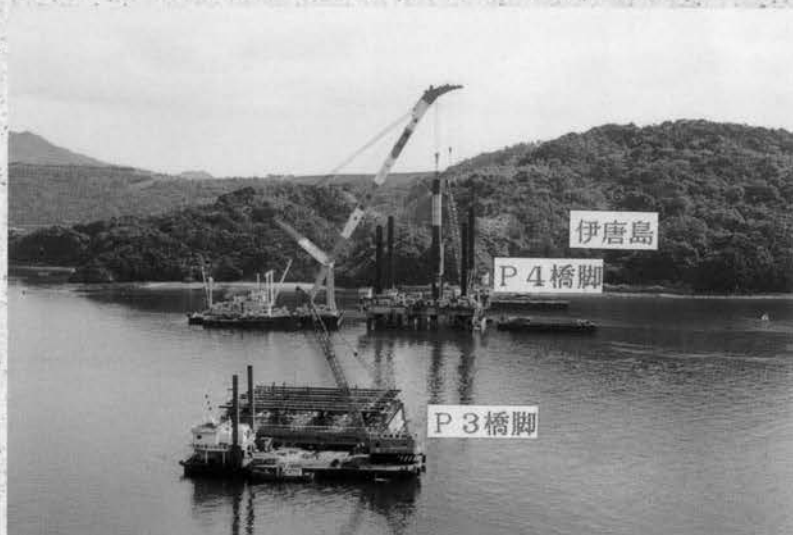
⇨下部工施工状況（長島側から）
