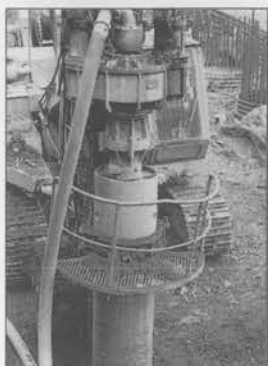
ダウンザホールハンマー工法 Down-The-Hole Hammer Method
