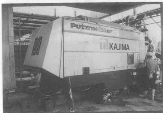
写真-16 高強度コンクリート圧送システム
