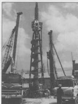
ロックオーガ工法 Rock Auger Method
