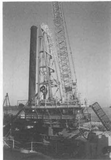
写真—6 削孔状況
