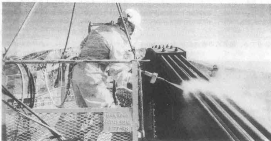
写真一 下地用塗料とプライマ上塗りの前に加圧水で洗浄する
