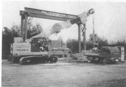
写真—8 低空頭利用工法
