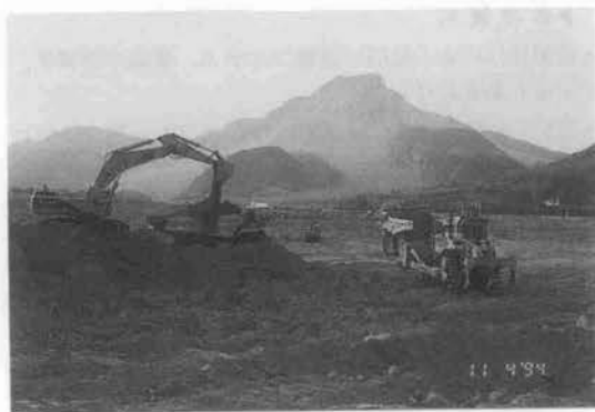
写真一 施工概要
