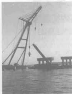
杭切断後の撤去
