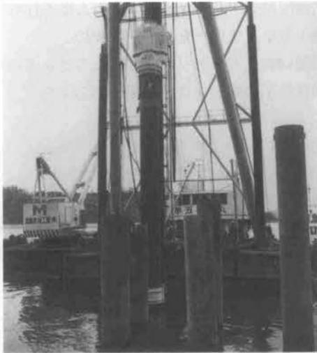
写真-3 ドーナツオーガ工法 (SMD型、一体型)
