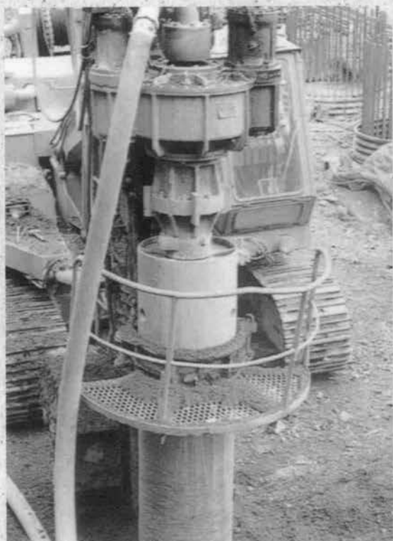
◆ダウンザホールハンマー工法
