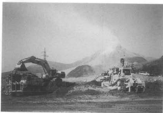
写真-1 施工状況
