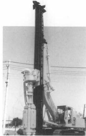
写真-6 湿式型ダウンザホールハンマ掘削機
