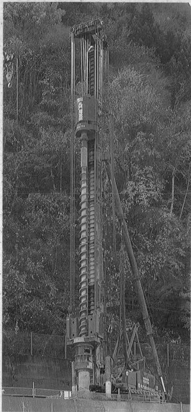
◆二軸同軸式ドーナツオーガ(SDA型)による岩盤削孔工事
