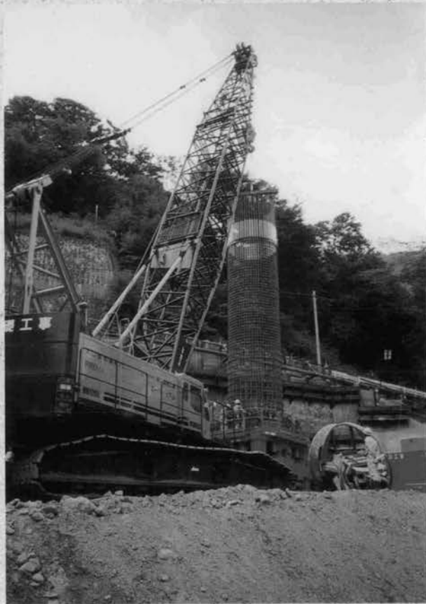
鉄筋かご建込み状況
