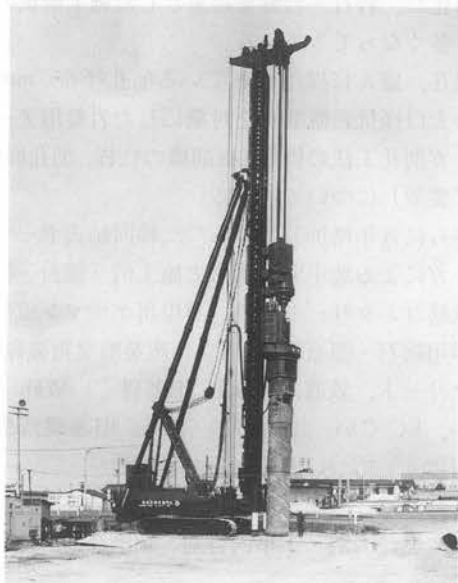
写真-2 ドーナツオーガ工法 (SDA型, セバレート型)
