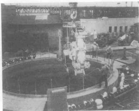
写真-2 立坑内に搬入される掘削機
