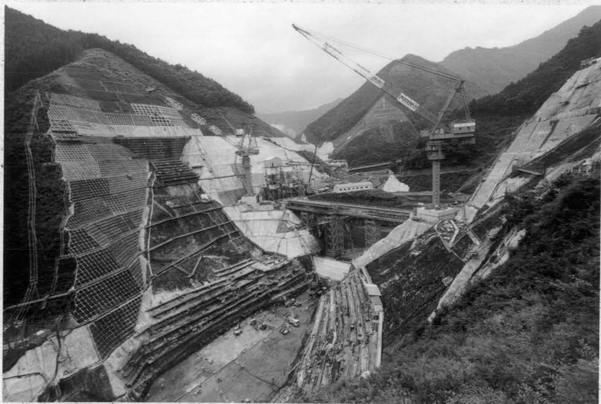
下部ダム工事状況
