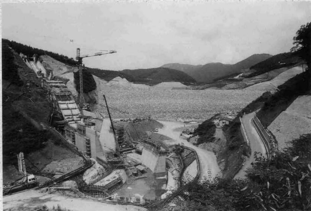
◆上部ダム工事状況
