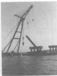
杭切断後の撤去
