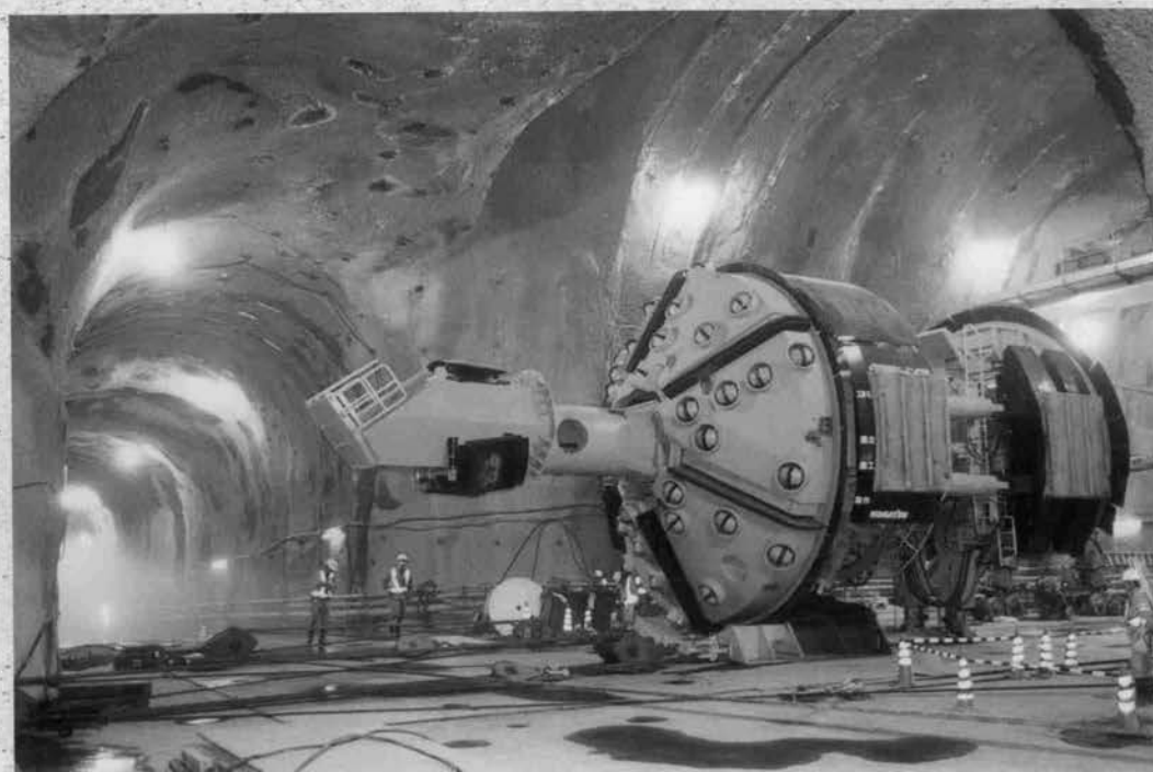
◆水圧管路下部斜坑ローリング用TBM組立状況
