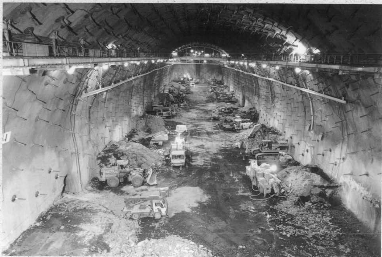
地下発電所工事状況
