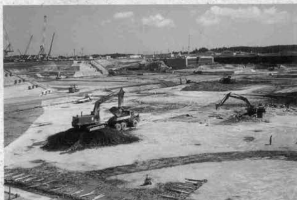
⇨掘削域の様子
