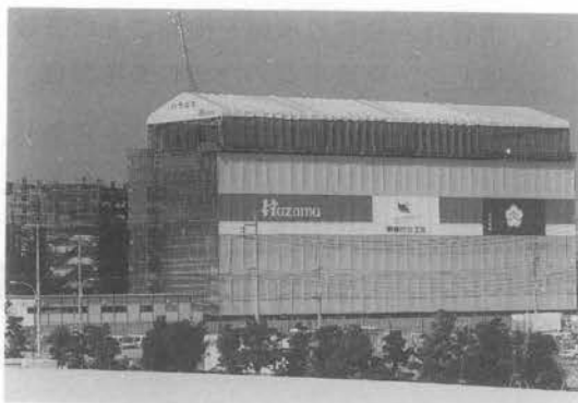
写真-1 全天候型仮設屋根「パラガス」
