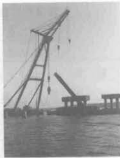
杭切断後の撤去
