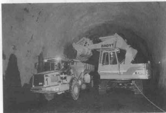
写真—2 補助車による坑内方向転換可能な25tダンプトラックとずり積み用電動ショベル
