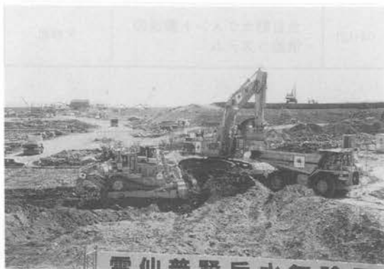
写真-1 押土および積込作業・無人化施工状況
