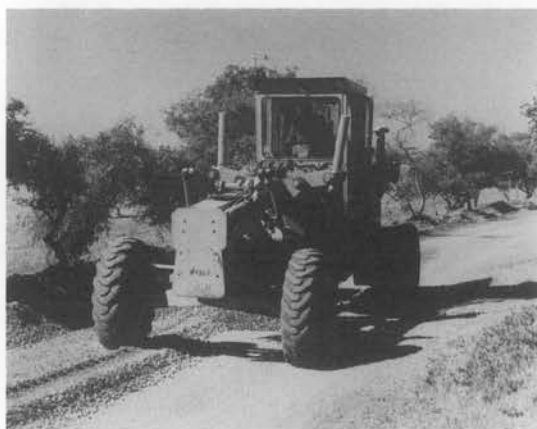
写真—4 路肩整正工事
