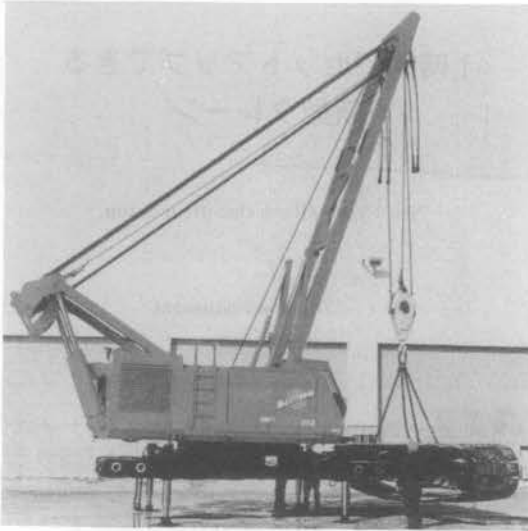
写真-3 稼働中の自己組立てジャック
