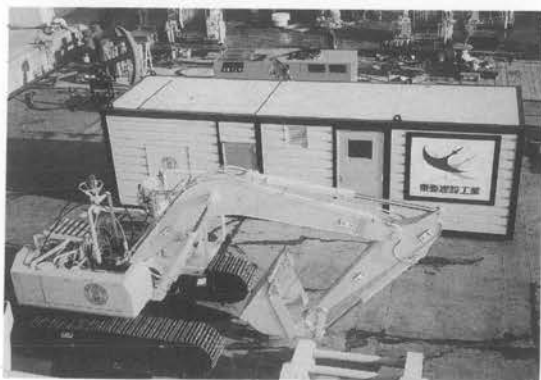
写真-1 水中バックホウとコンテナハウス
