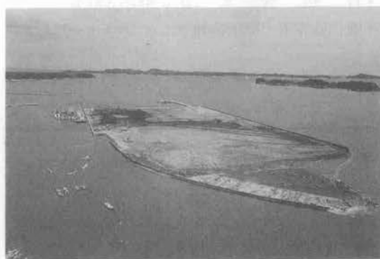
写真-1 工事区域全景
