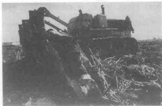
写真—5 転石除去工事
