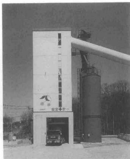
写真-3 キタガワ「コンパック」生コンプラント
