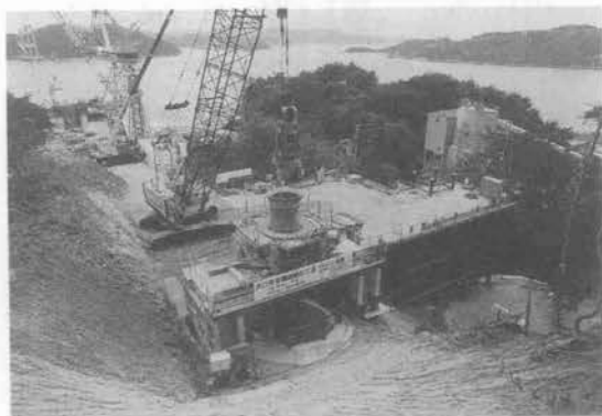
写真-1 スーパー RD 工法施工状況
