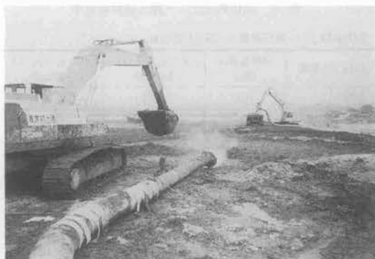
写真—6 埋立て地排出状況
