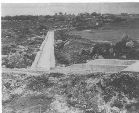
写真—6 完成した水路
