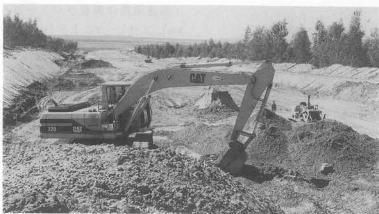
写真-1 工事中の高速道路
