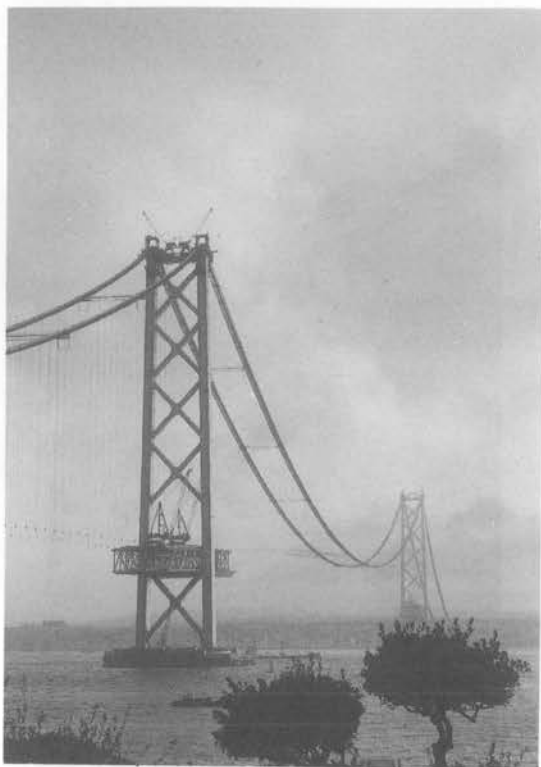
写真-7 明石海峡大橋架橋工事で稼働中のトラベラークレーン
