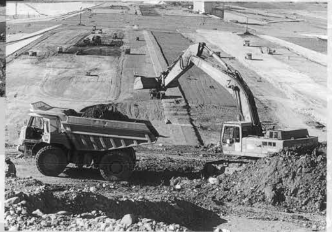
⇨ 左岸側から堤体を望む
