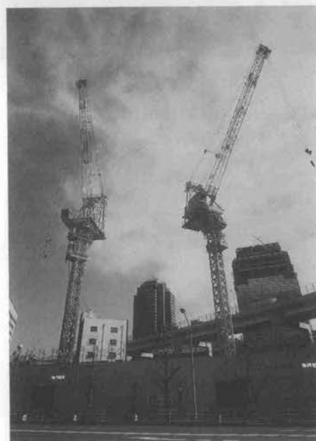
写真-6 クライミングクレーン「ビルマン」
