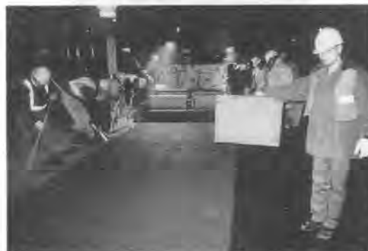
写真-1 バスレーンのカラー舗装工事
