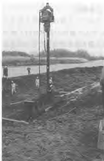
写真—2 試験施工実施状況
