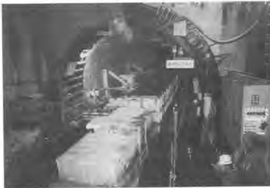
写真-4 現場使用状況
