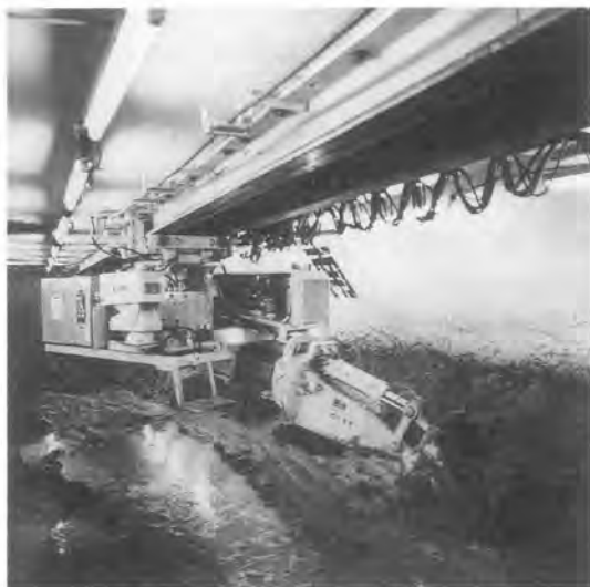
写真-8 ニューマチックケーソン無人掘削機
