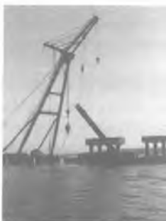
杭切断後の撤去
