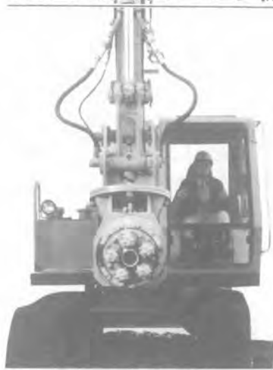
取付重機0.25m 3 以上
