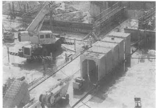
写真-1 通廊のプレキャスト型枠施工状況
