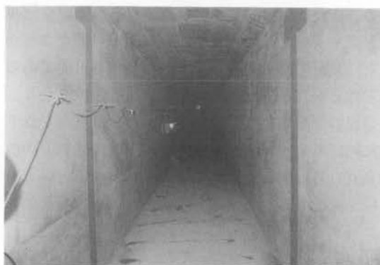
写真-4 完成した身障者用連絡通路
