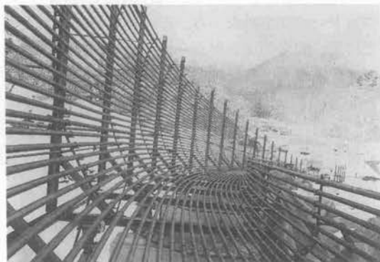
写真-6 配管・配筋状況
