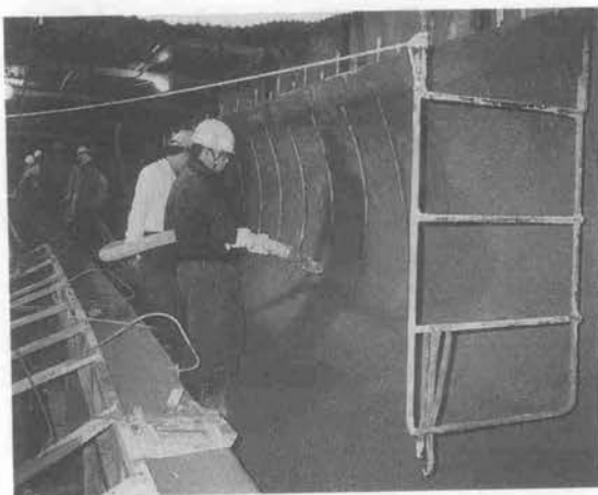
写真-4 コンクリートの吹付け状況
