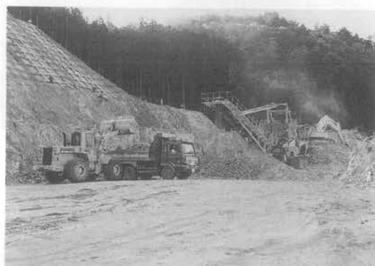
写真—4 一次破碎と積み込み状況
