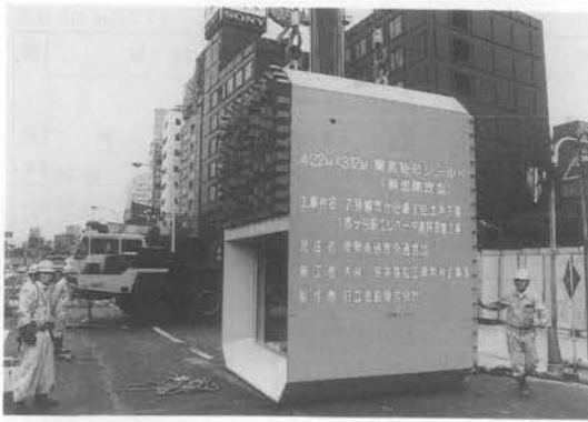
写真-2 現場に搬入されたマシン
