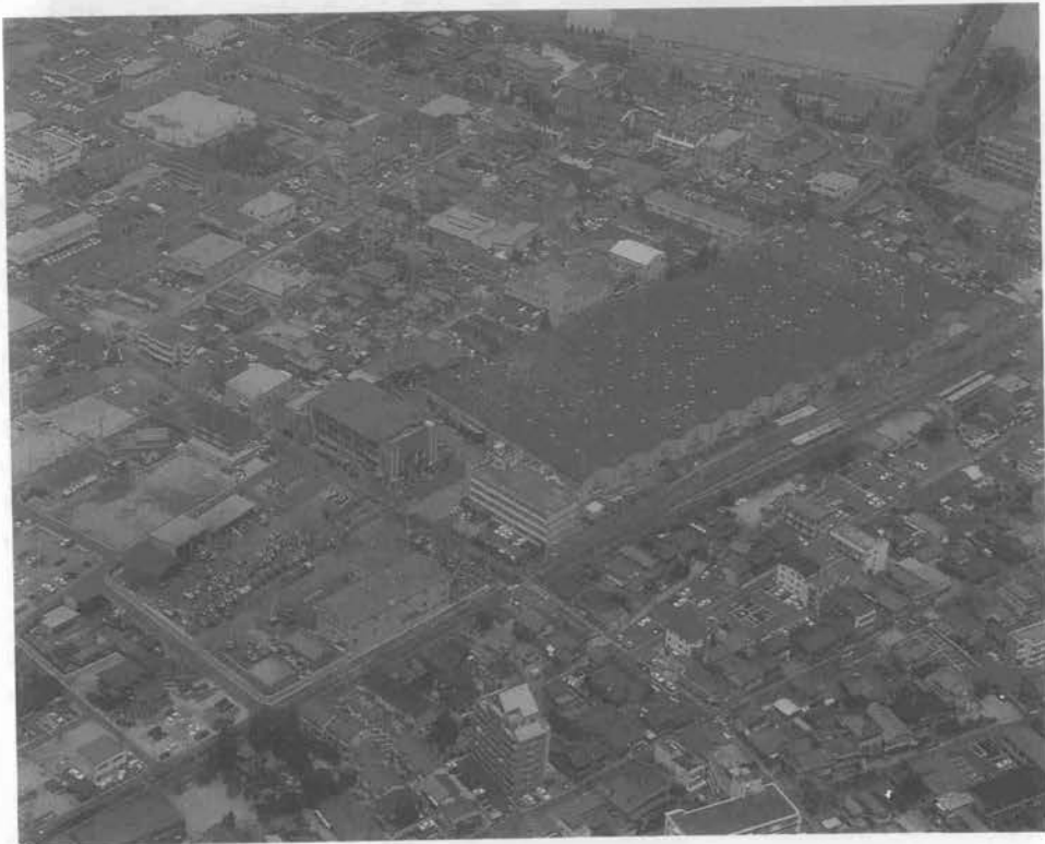
写真-1 祇園工場全景
