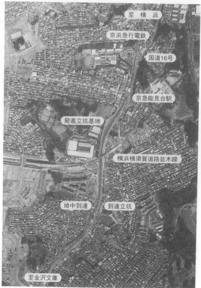
写真-1 施工位置
