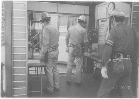
写真-2 現場入場状況
