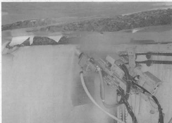
⇨ ウォータージェットによる研り作業状況
