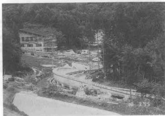
写真-7 自然環境に配慮した工事状況
