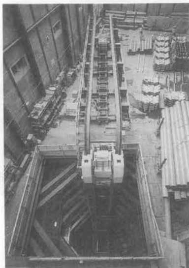
写真-1 セグメント搬送装置全景
