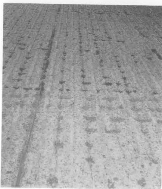
写真-2 コンクリート研り面の状況
