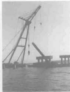
杭切断後の撤去
