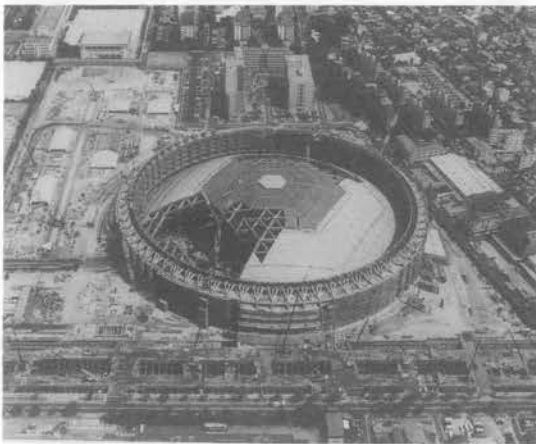
写真—3 工事全景 (1995.8)
