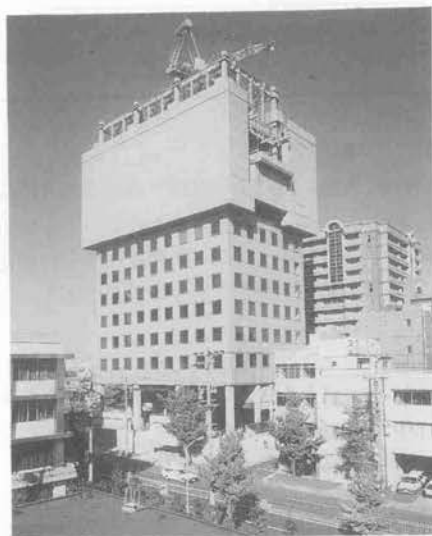
写真-1 施工状況
