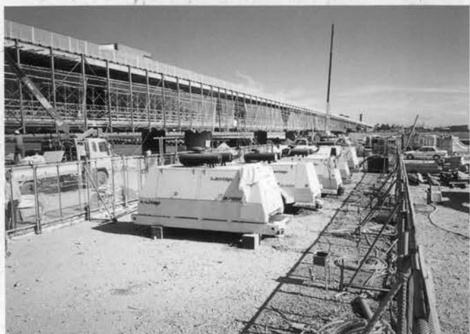
⇨ 北陸自動車道手取川橋 高圧水発生ポンプ(250MPa, 27l/min, 5台)と 施工仮設状況
