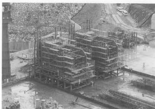
写真-2 主放流管の中ステージ工法施工状況
