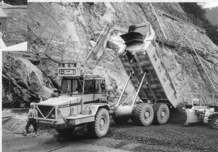
⇨ 富郷ダム コンクリート運搬用ダンブトラック(20t積)
