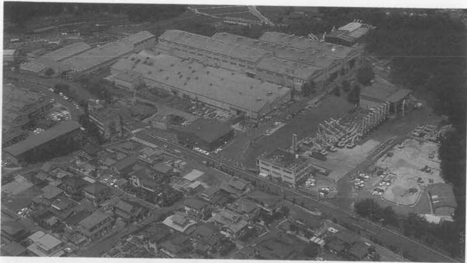
写真-2 沼田工場全景
