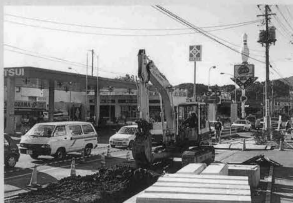
⇩ 開発された接触防止型油圧ショベルの適用 (現場での適用性調査)
