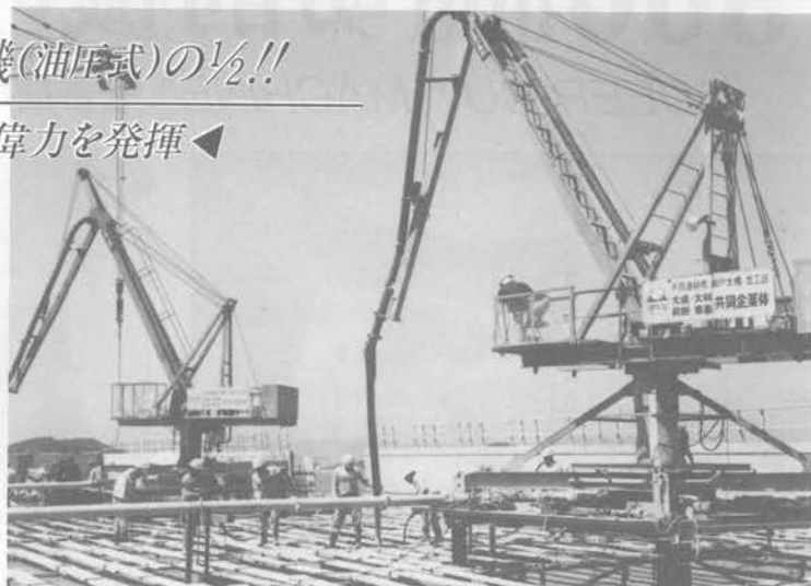
(本四架橋現場設置例)
