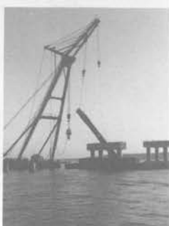
杭切断後の撤去
