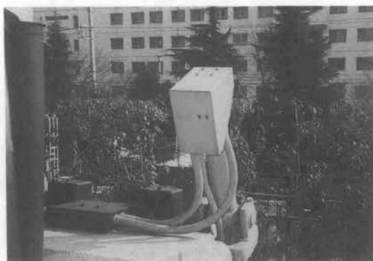
写真-3 リフトシリンダ頂部油圧ラインカバー
