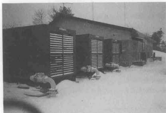
写真-4 スキー場で稼働するSDS 3000 S
