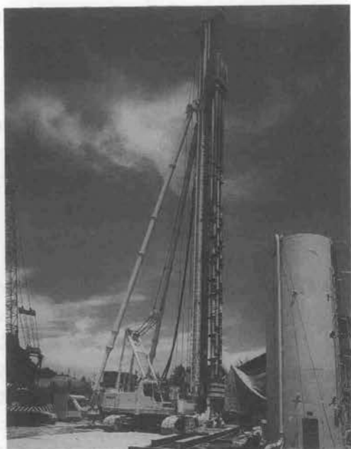
写真-1 3軸オーガによる地中連続土留壁施工
