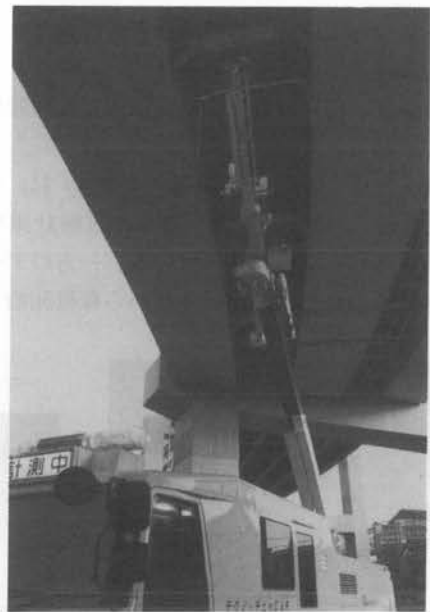
写真—3 レーザ計測
