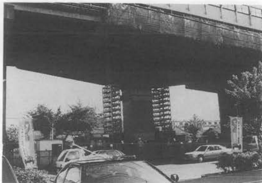
リフトアップ完了
