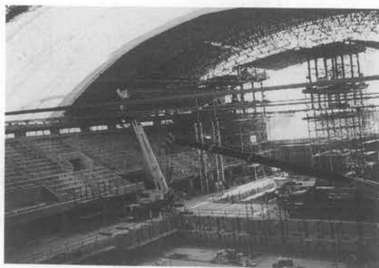
写真-2 全天候空間での上下ラップ作業状況
