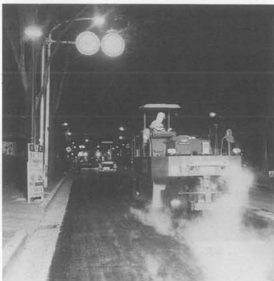
写真-2 赤外線反射方式の現場評価試験状況
