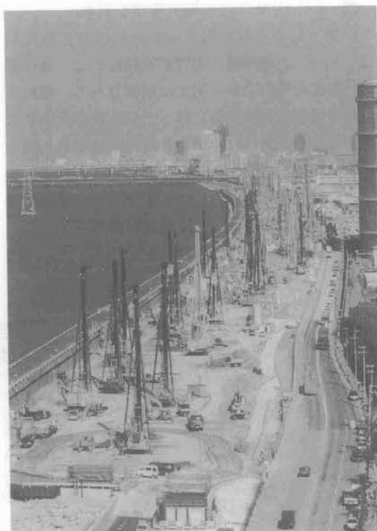
写真—1 施工風景
