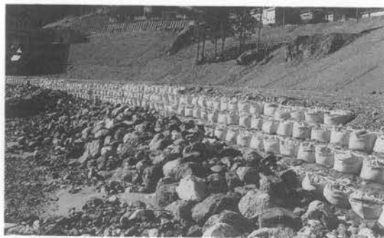
写真一 大型土のう設置状況（糸魚川市中川原）
