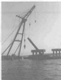
杭切断後の撤去
