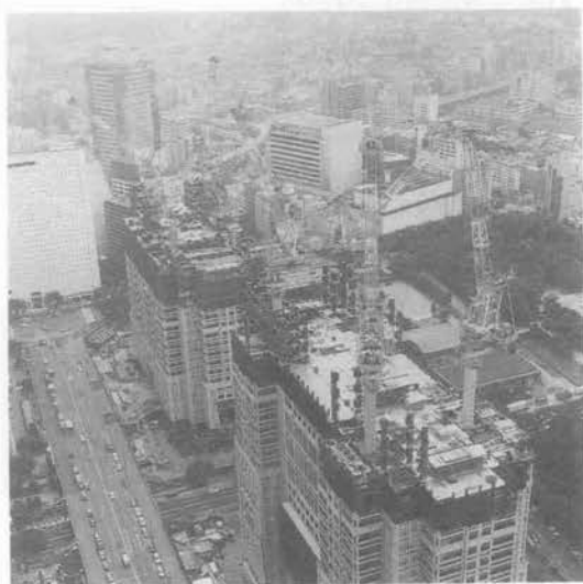
写真—1 新都庁舎建設
