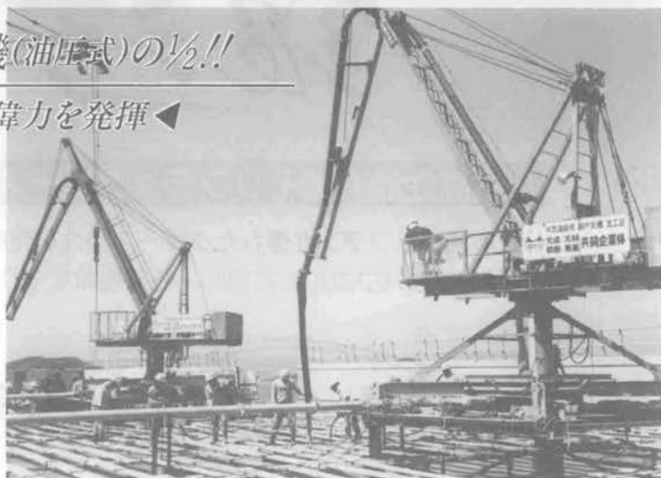
(本四架橋現場設置例)
