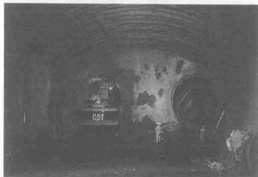
写真-2 大型ブレーカ掘削状況
