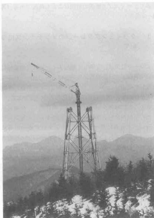
写真—2 送電鉄塔建設
