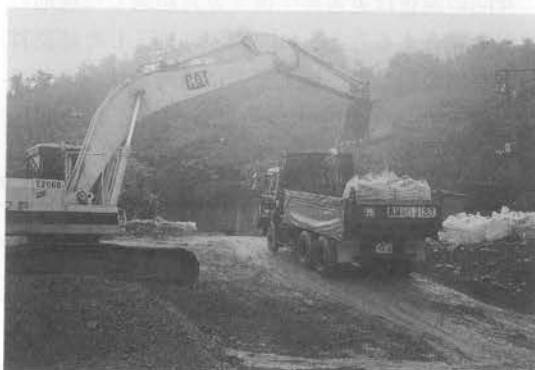
写真-3 積込・運搬
