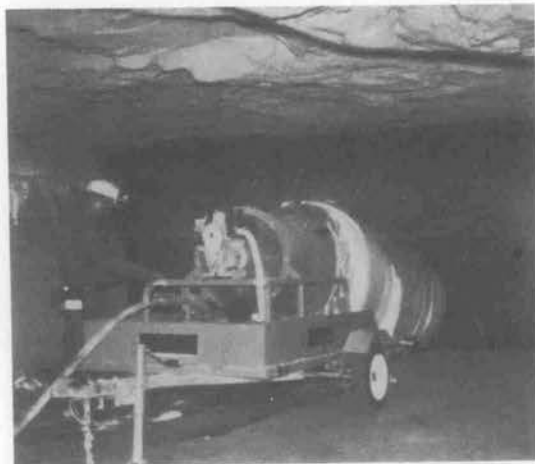
写真-1 Lake Lynn 地下実験鉱でのエアバック式間仕切り
