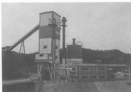
写真-4 「バッチャープラント搭載型真空冷却システム」設備外観
