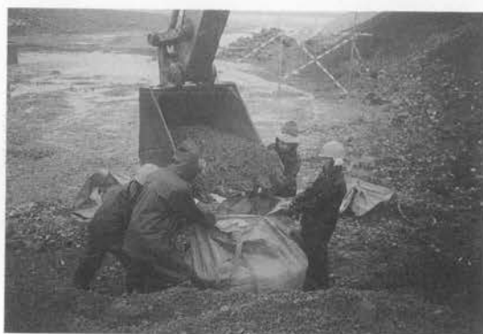
写真-2 土のう製作状況
