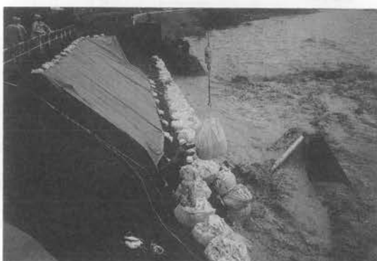
写真-4 クレーン車による設置
