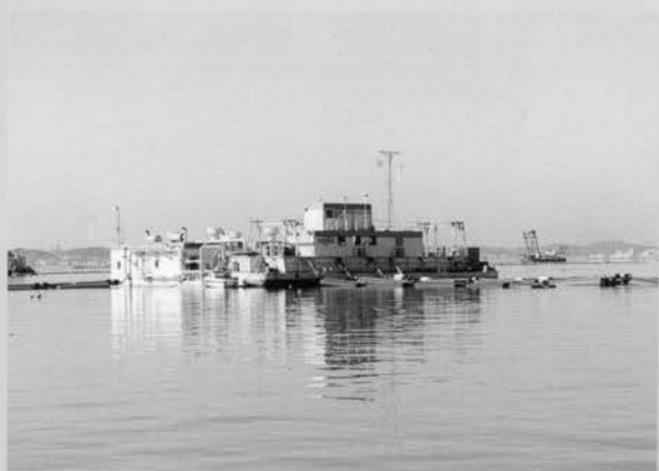
⇨ 稼働中の中継船「明日霞」 (左右後方は、浚渫船)
