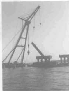
杭切断後の撤去
