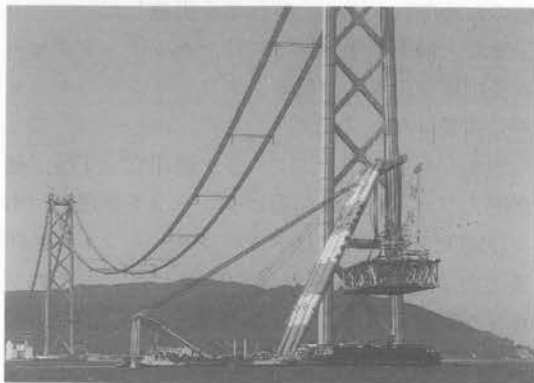
写真-1 塔部大ブロック架設状況
