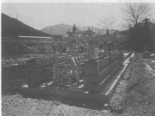
写真—1 型枠台車（試験機）
