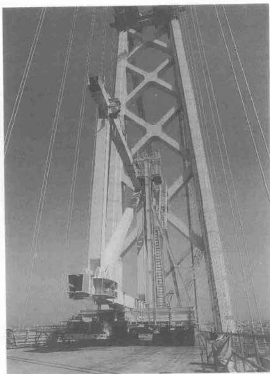
写真—3 運搬台車による面材輸送状況
