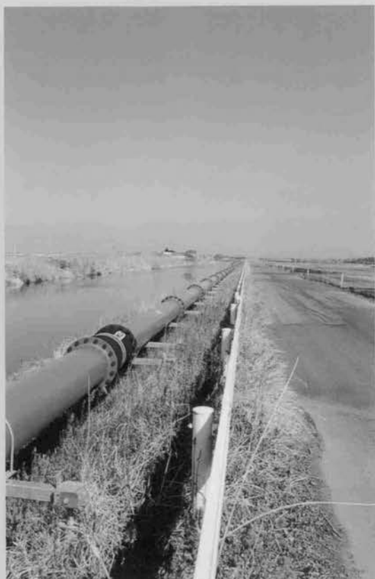
⇨ 堤防小段を走る長距離送泥管
