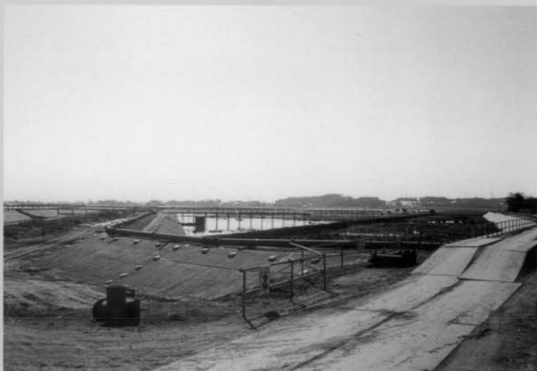
⇨ 処分地底泥受入準備 (囲繞堤と処分地内配管)
