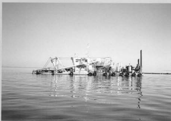
稼働中の浚渫船「カスミザウルス」⇨
