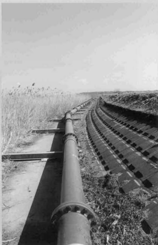
⇨ 流入河川に沿って処分地に向って延びて来た送泥管
