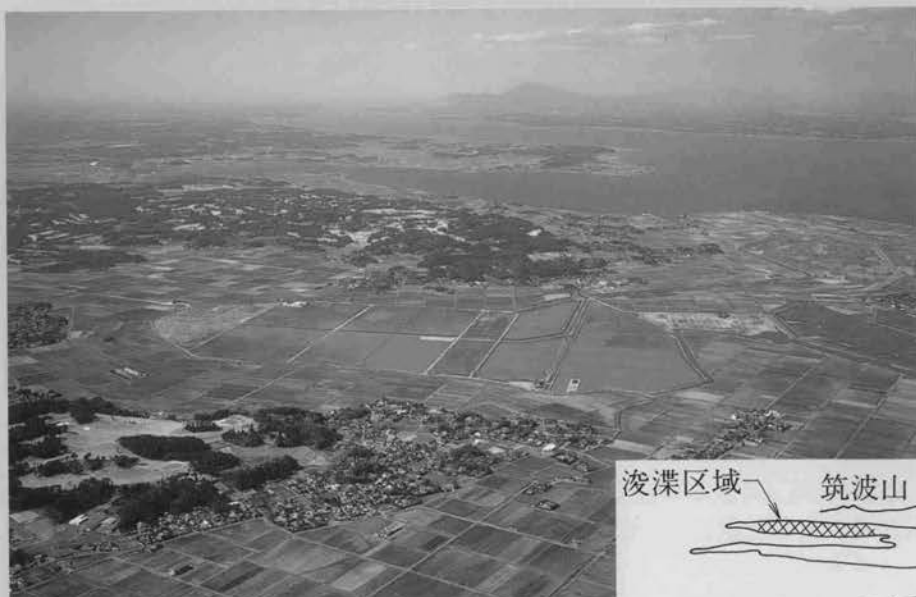
⇨ 工事現場全景
