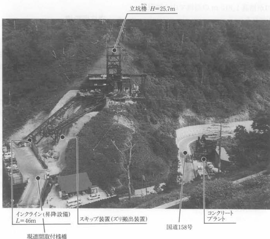
写真—1 立坑仮設備全景
