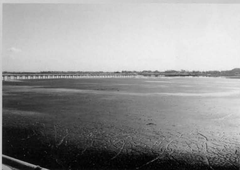
⇨ 排泥後、 (沈降分離後、余水である 上水を概ね除去した状態)
