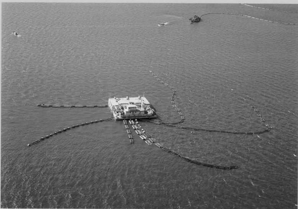
⇨ 定位置につき各浚渫船からの配管接継を待つ中継ぎ船「明日霞」
