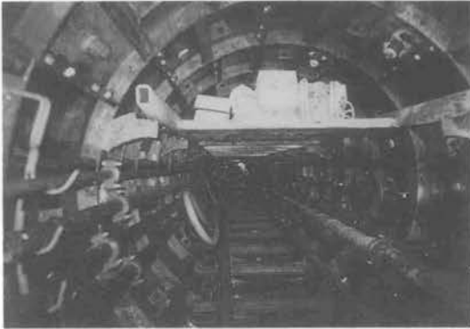
写真-2 ベルトコンベヤ後方
