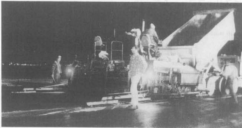
O'Hare 空港の舗装補修は昼間の交通量が多いため夜間行われる
