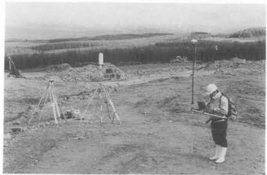
写真-1 旭川空港造成工事でのリアルタイム測位
