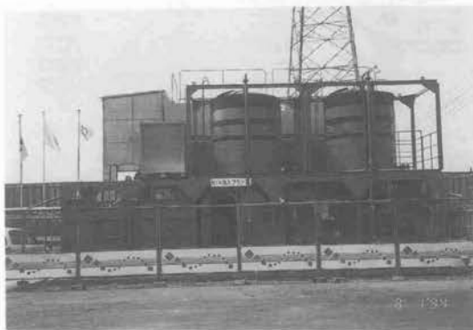
写真—8 Nゾル注入プラント
