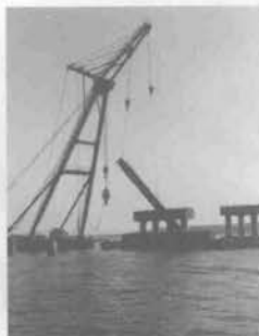
杭切断後の撤去
