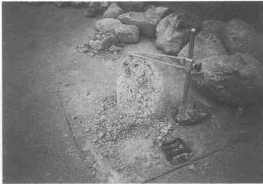
写真—4 掘削土砂の乾燥状態
