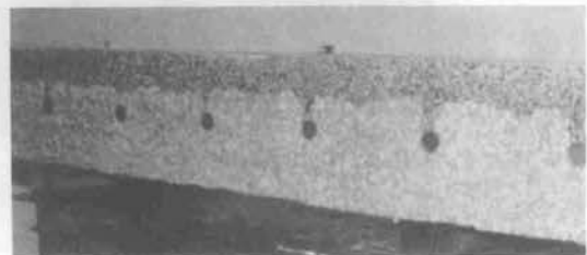
写真-1 舗装コンクリートの断面
