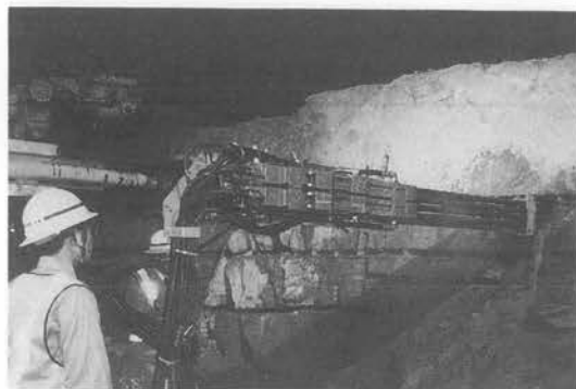
写真-1 SD機によるスロット穿孔
