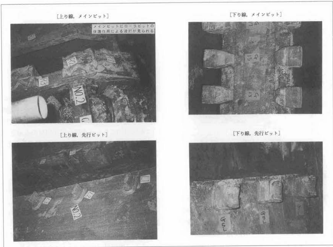
写真—1 カッタビット摩耗状況写真
