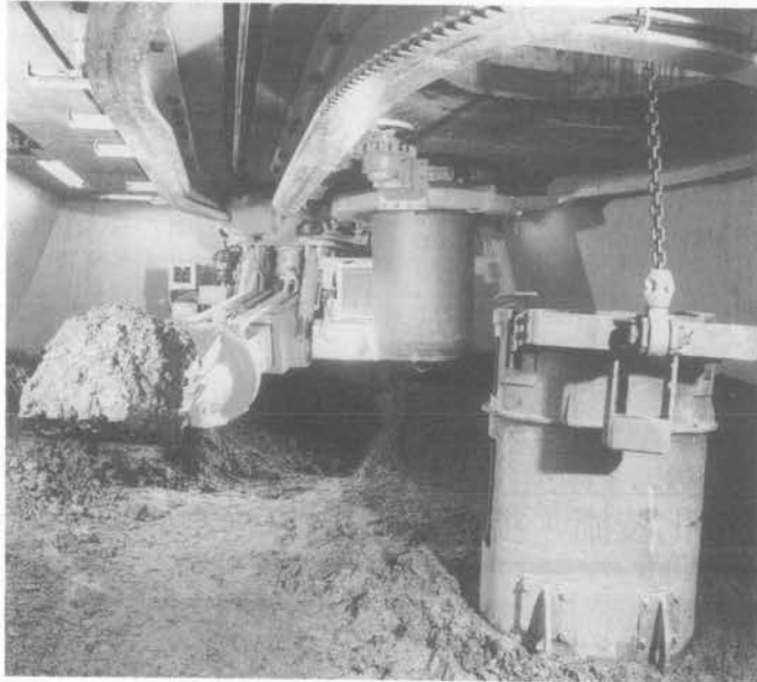
写真-1 遠隔操作による掘削状況（土砂積替え装置使用）
