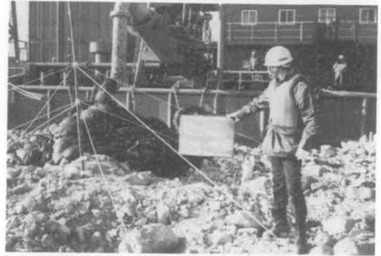
写真—3 陸上打設実験
