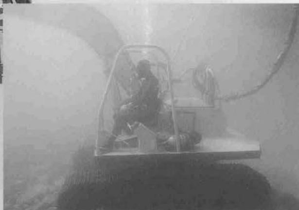
潜水夫による水中バックホウの運転
