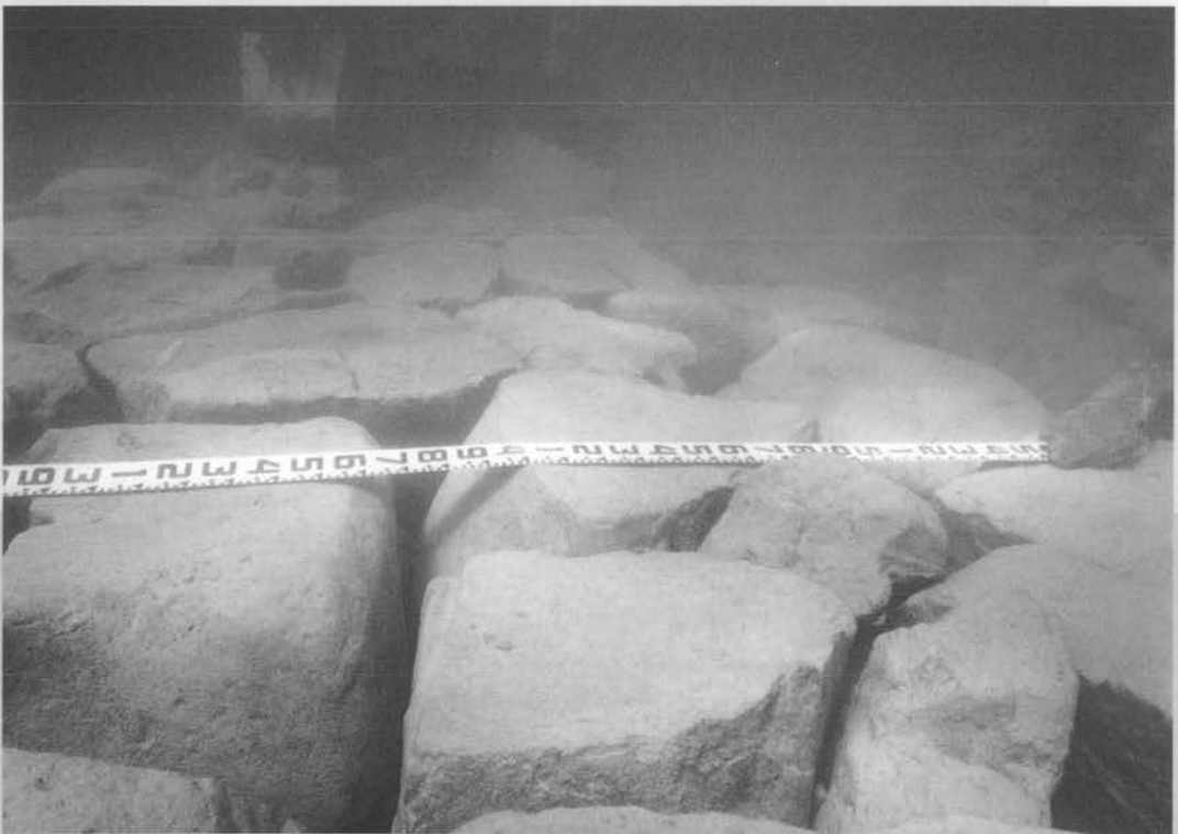
捨石均しの仕上り状況
