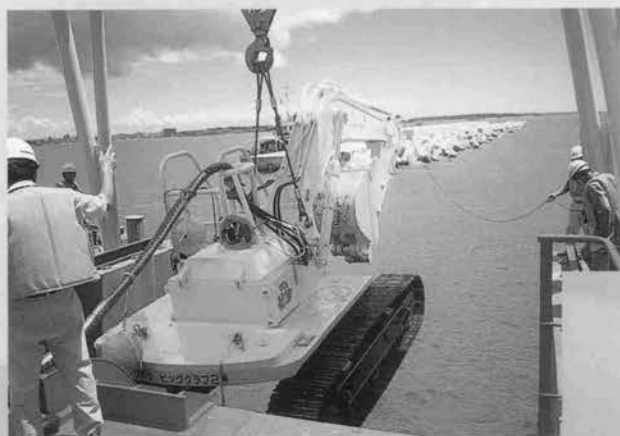
支援船「伯凜」から水中バックホウの進出作業風景
