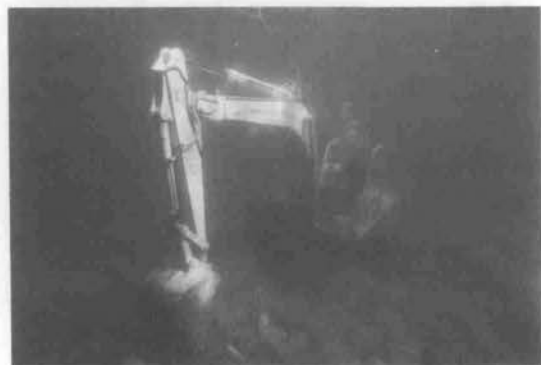
写真-1 水中作業状況
