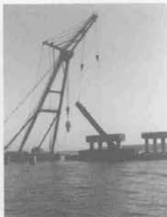
杭切断後の撤去
