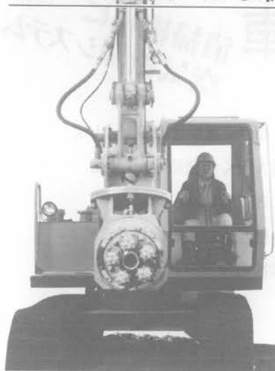
取付重機0.25m 3 以上
