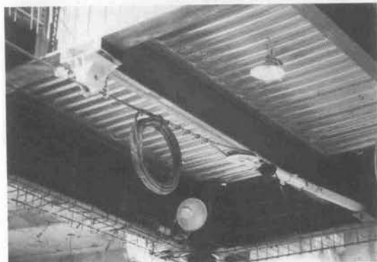
写真-2 主索緊張部
