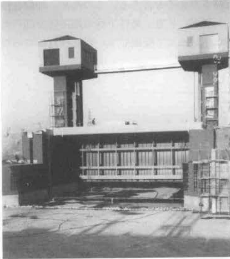
写真-1 建設中の芝川マリーナ水門
