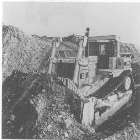
写真-1 CAT D 10 Rブルドーザ
