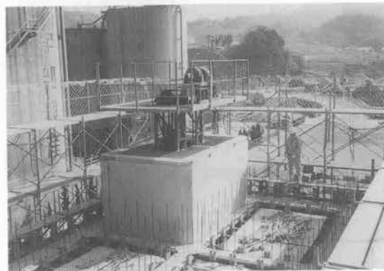
写真—38 OS リフトアップフォーム型枠上昇中
