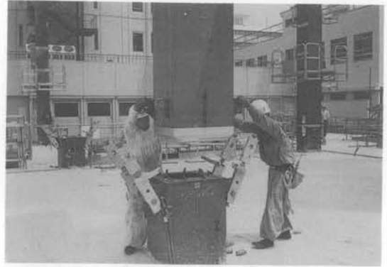
写真一31 鉄骨建方治具写真
