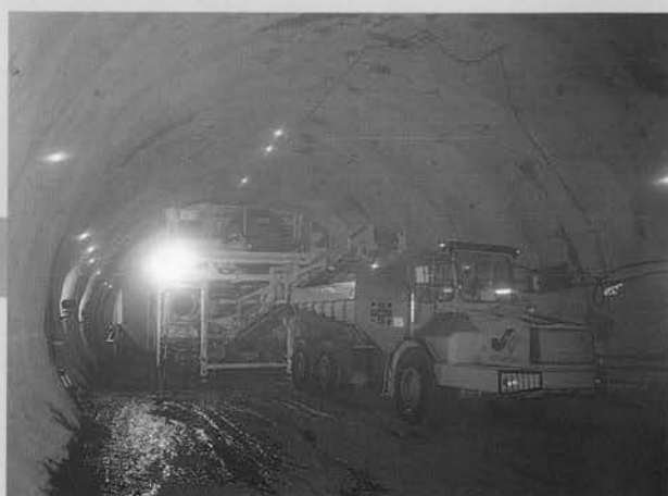
⇨ ずり積みみ状況
