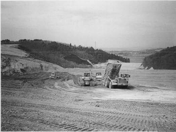
⇨ブルドーザ敷均し転圧
