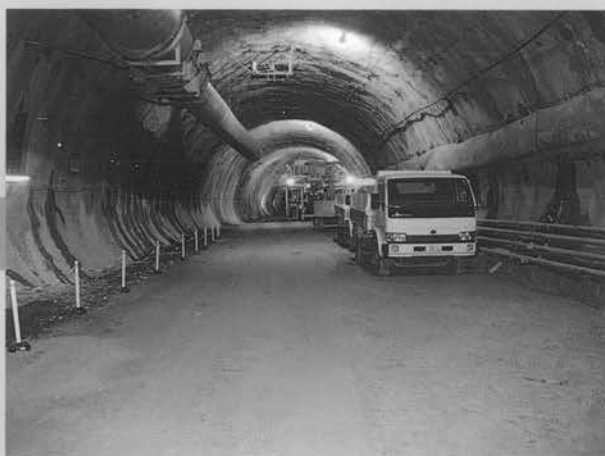
⇨ MM130Rによる掘削完了区間
