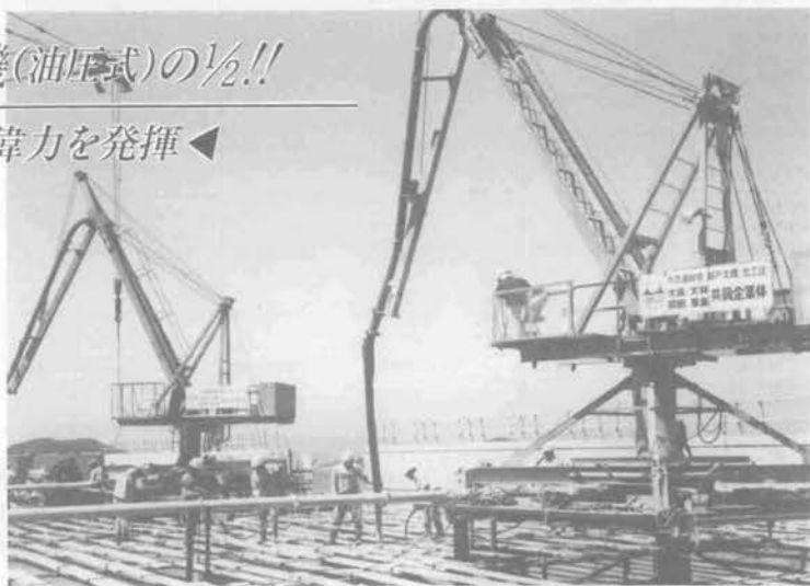
(本四架橋現場設置例)
