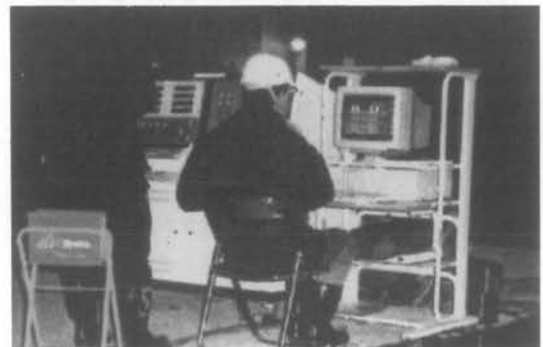
写真-3 ターミナルブロックの押出し制御状況
