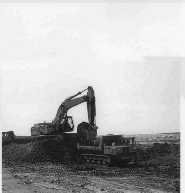
⇨バックホウ掘削積込(不整地走行車)
