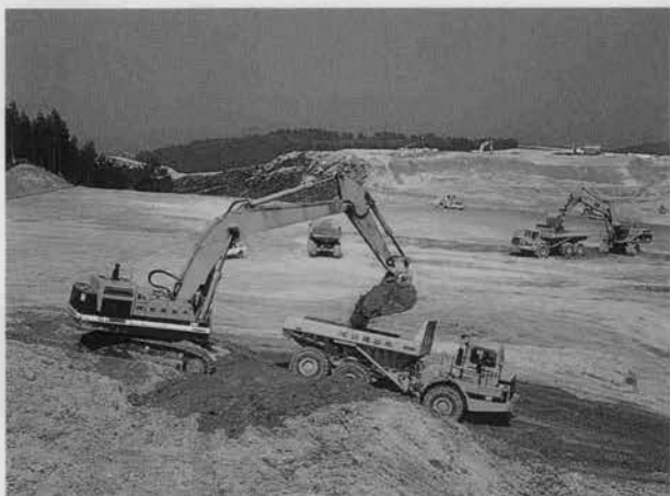
⇨バックホウ掘削積込
