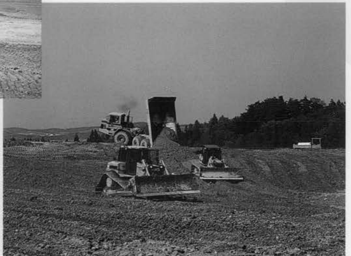
⇨ブルドーザ転圧
