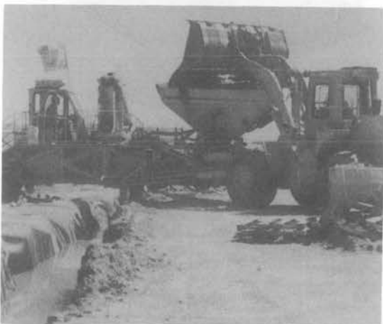
写真-1 水路壁工事のために12マイルの長さの溝から20万ヤードの土砂を除去しなければならない
