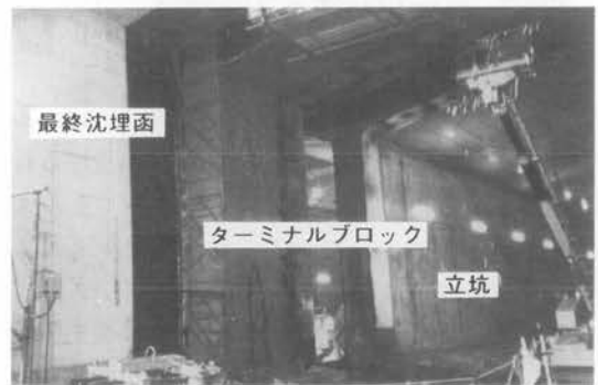
写真-2 バルクヘッド撤去状況 (トンネル貫通)
