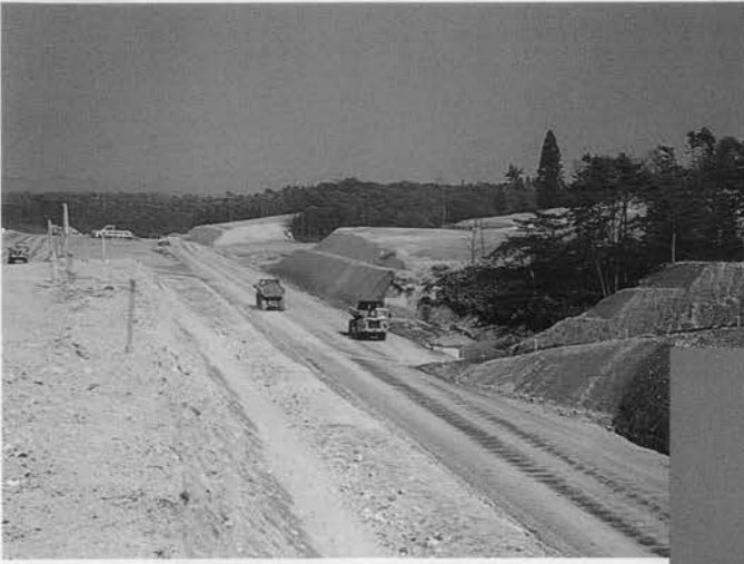
⇨重ダンプトラック運搬
