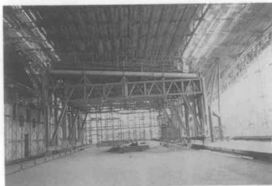
写真—32 モフス足場
