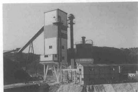
写真-27 バッチャプラント搭載型真空冷却システム
