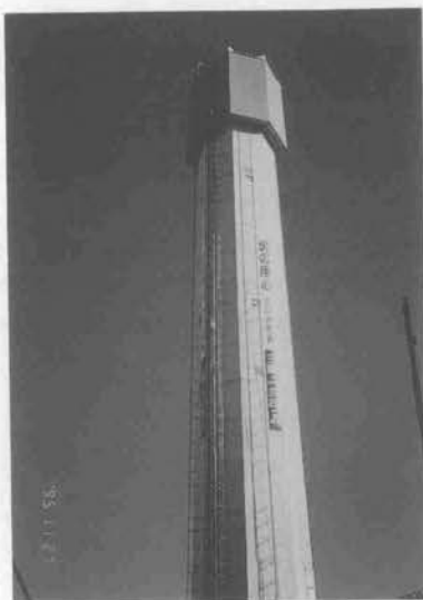
写真-42 高さ118mのPC造高層煙突を施工 (煙突上部に昇降ロボットジャッキシステムにより、上昇下降可能な全天候型作業空間がある。昇降ロボットジャッキシステムは作業空間最下部に躯体外部に8台、内部に3台セットされている。)
