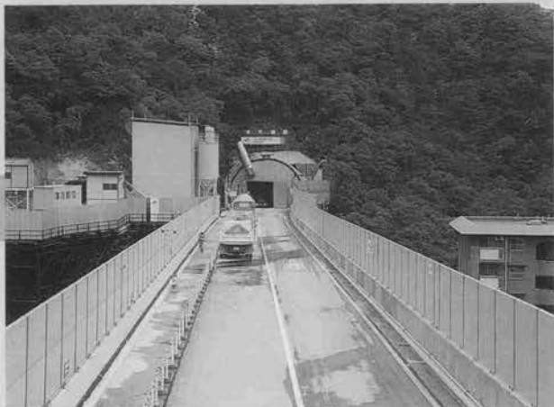
⇨ 高取山トンネル坑口全景
