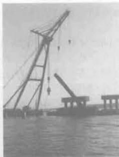
杭切断後の撤去
