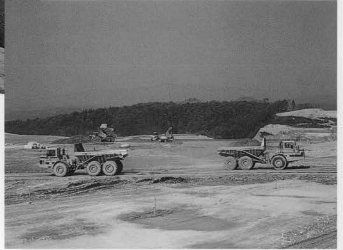
⇨重ダンプトラック運搬
