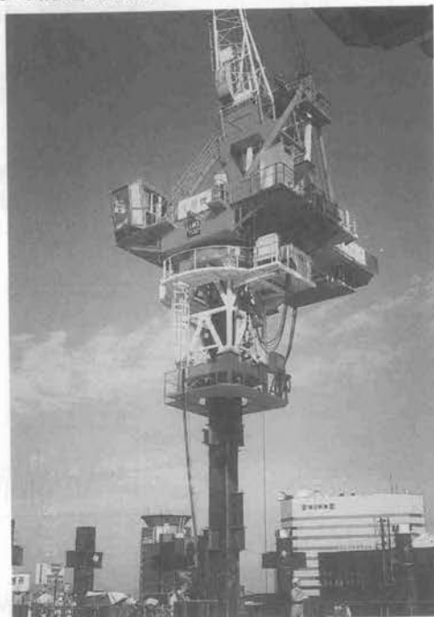
写真—1 稼働中のマスト・コラムクレーン
