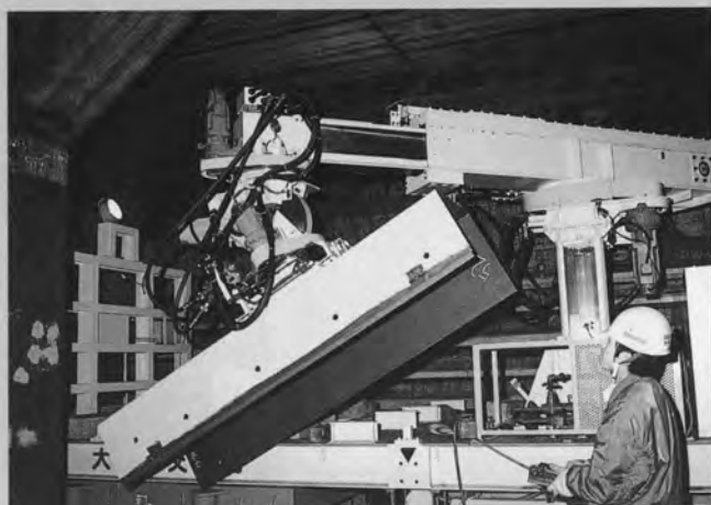
⇨ 補強鋼板の取り込み
