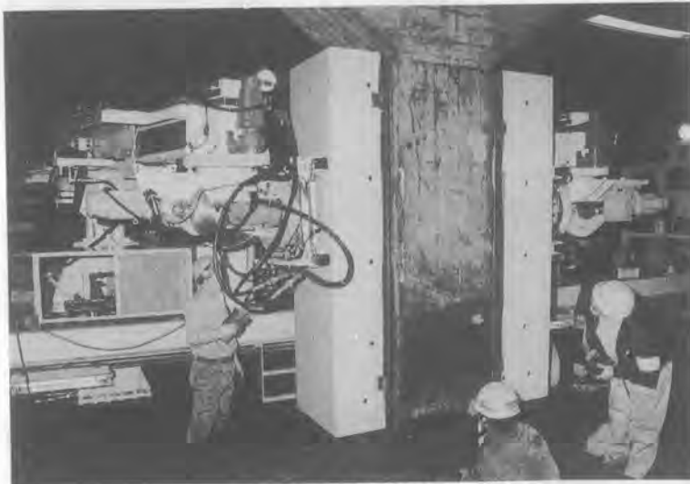
写真-2 鋼板仮付け作業
