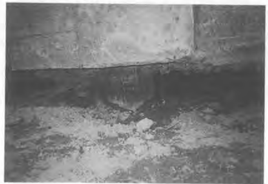
写真-2 杭頭部状況
