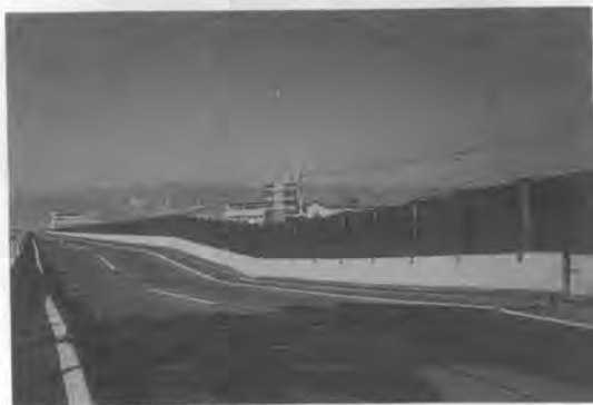
写真-1 守部高架橋と橋脚
