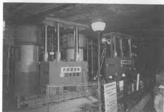
写真-6 パワージャッキシステムによる横移動
