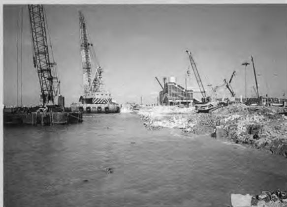
⇨ 裏埋土・裏込石撤去作業状況
