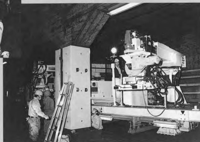
⇨ 中柱への取付完了状態
