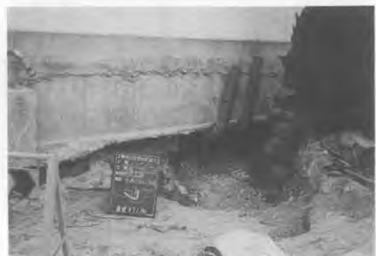
写真-6 圧送管設置状況
