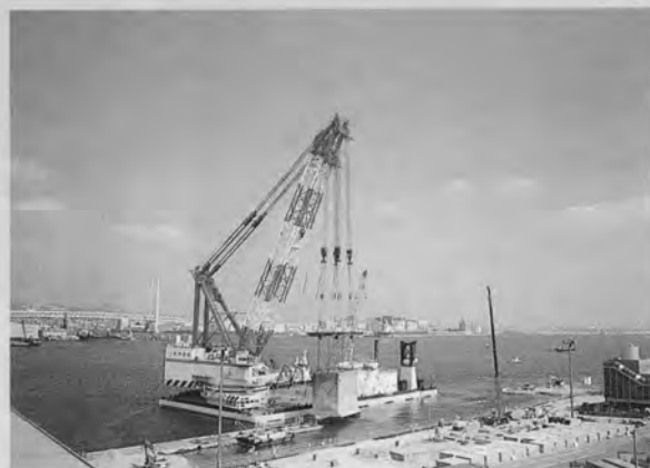
⇨ 1,600t吊全旋回起重機船による ケーソン撤去、据付作業状況
