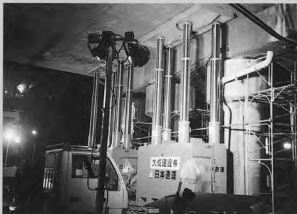
⇨パワージャッキのリフトアップ状況
