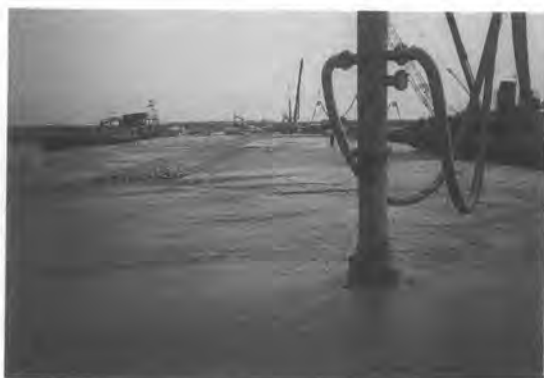
写真—7 軽量気泡混合土打設状況
