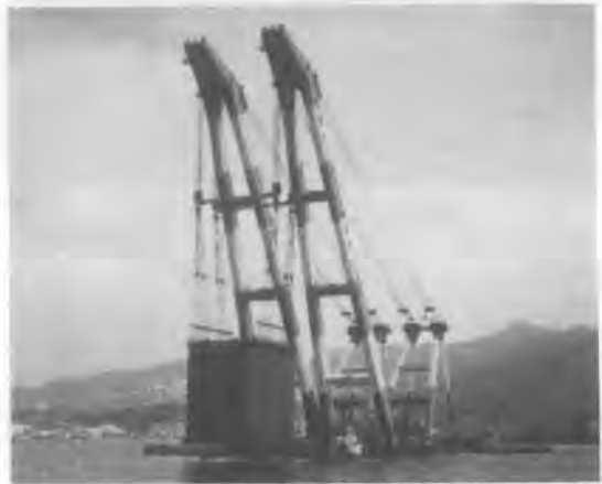
写真一1 ケーソン設置状況
