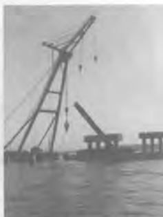
杭切断後の撤去
