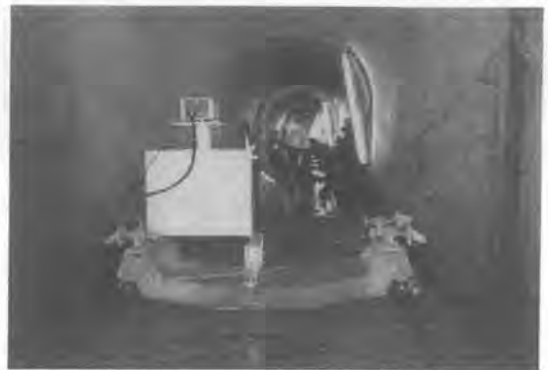
写真-1 打設位置の送信装置
