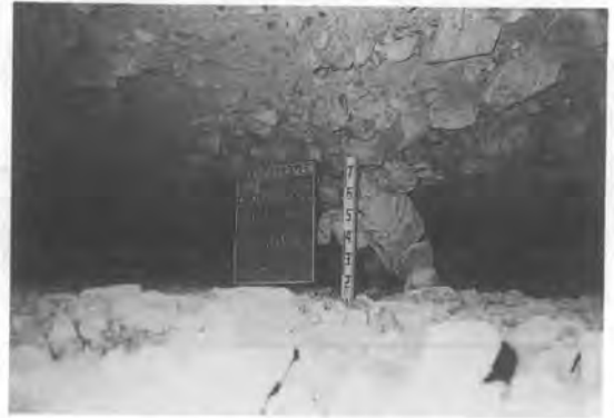
写真-1 充填区画内状況
