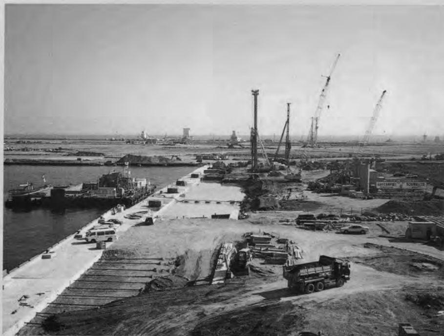
◀ 軽量混合土を岸壁裏埋材として使用した現場全景
