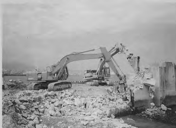
⇨ コンクリート撤去作業
