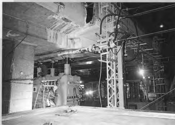
⇨パワージャッキ設置状況
