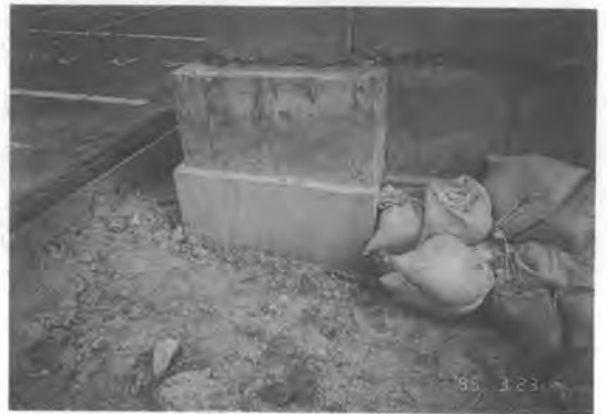
写真-3 杭頭部補強状況
