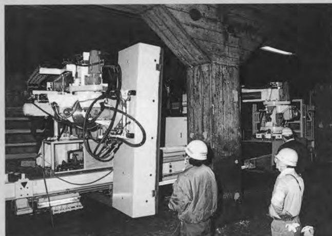
⇨ 中柱への取付状況
