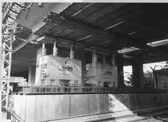
⇨パワージャッキ設置状況
