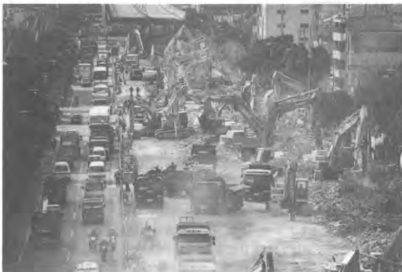
写真-1 深江地区高架橋撤去工事（岸本建設（株）より）
