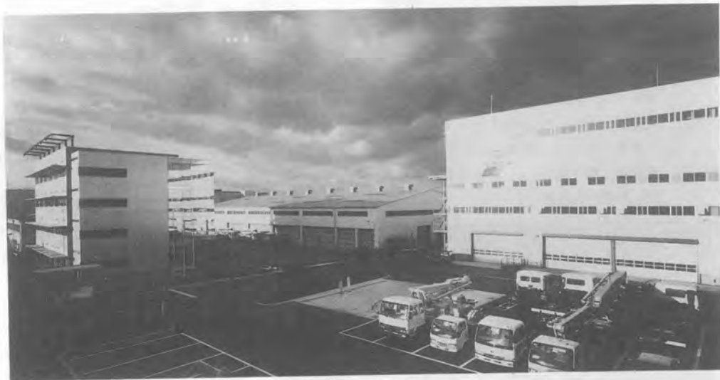
写真—1 三木工場
