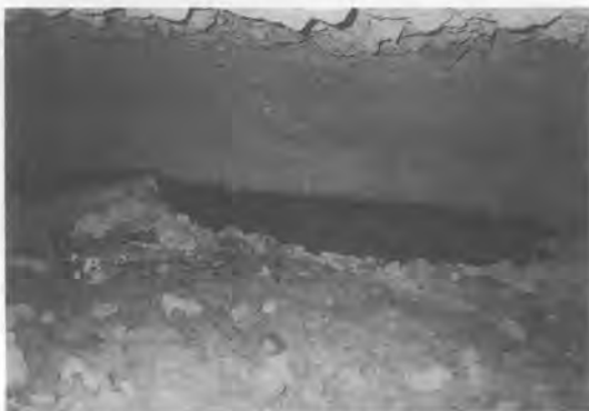
写真-4 充填部区画状況
