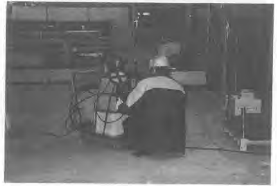
写真-3 調査状況
