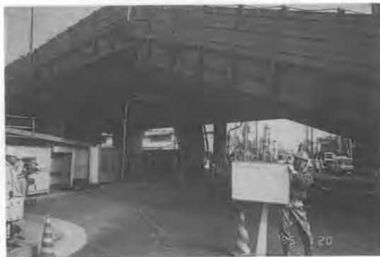
写真-2 瓦木西高架橋
