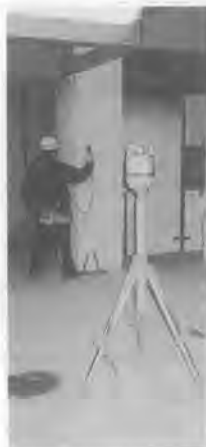
写真-1 墨出しシステム 施工状況
