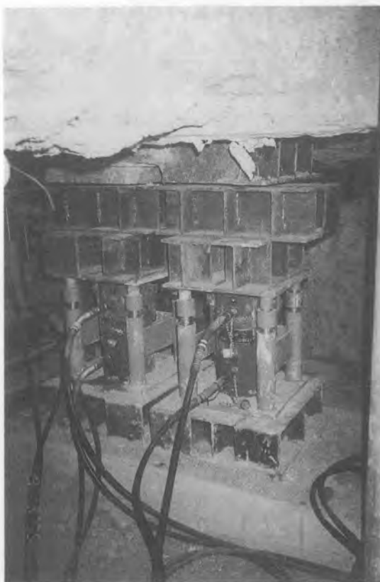
写真-7 ジャッキの盛替え
