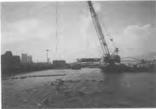
写真-1 アスファルトマット敷設状況
