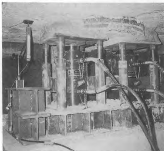
写真-6 ジャッキセット
