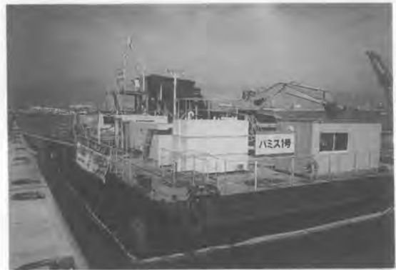
写真-2 解泥船全景
