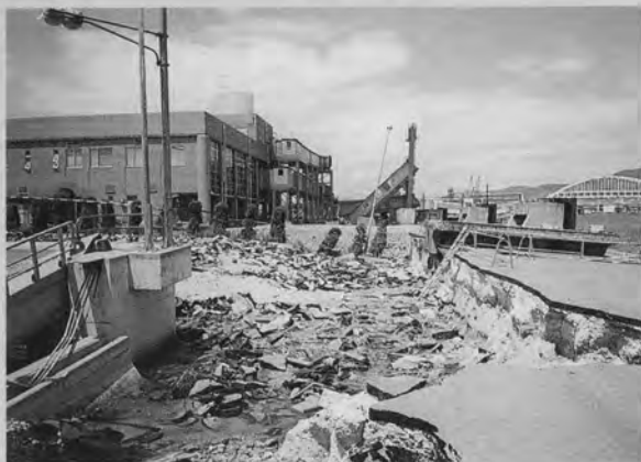
⇨ F2バース被災状況
