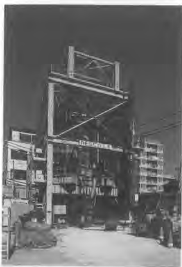
写真-1 RESCO 工法施工状況
