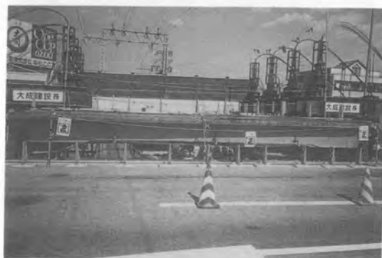
写真-5 桁のリフトアップ
