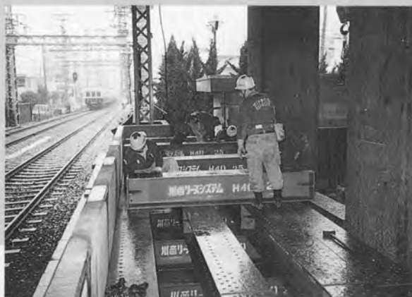
⇨パワージャッキの架台の施工状況
