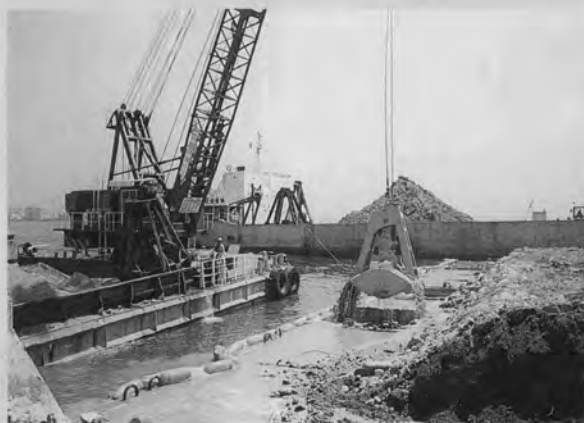
⇨ ケーソン中詰砂撤去作業状況
