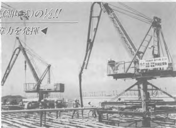
(本四架橋現場設置例)
