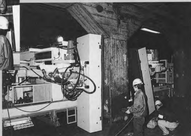
⇨ 中柱への取付状況
