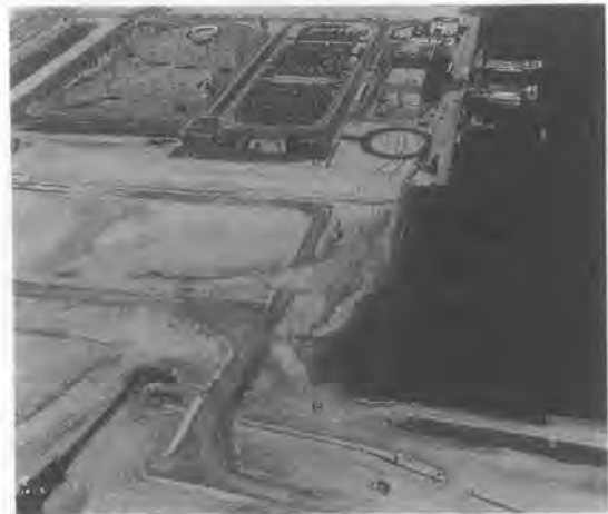
写真-1 被災後の現場状況写真
