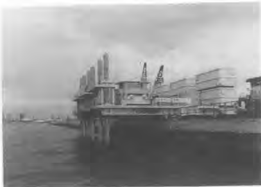
写真—1 施工状況
