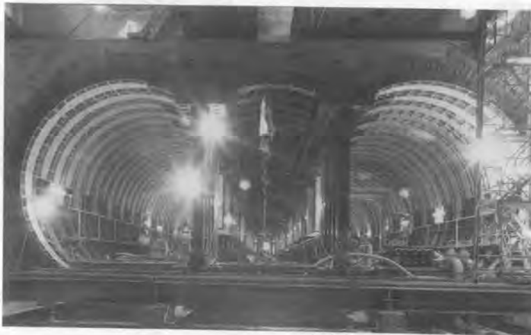
写真-9 3連MFシールドエントランス部
