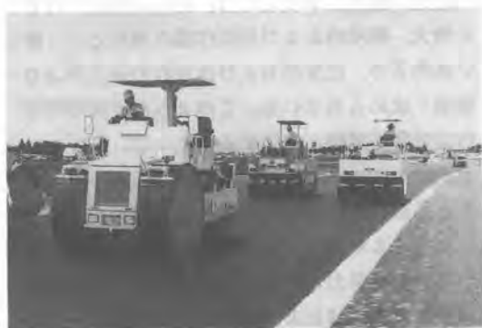
写真-5 ネッパラン S の使用現場
