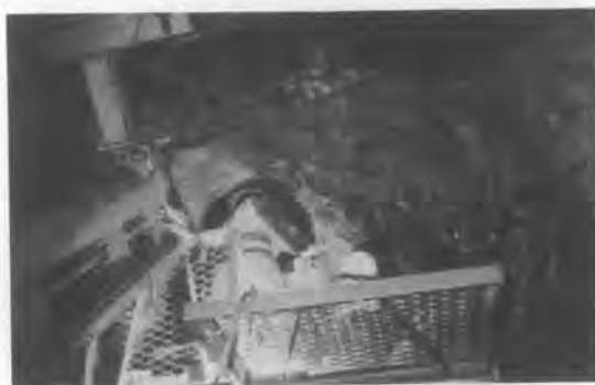
写真-4 切羽作業状況(装薬)
