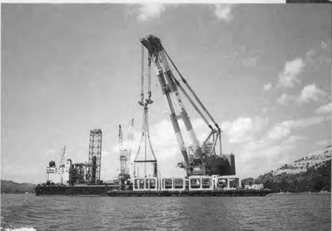
◀ 放水路沈埋函施工状況
