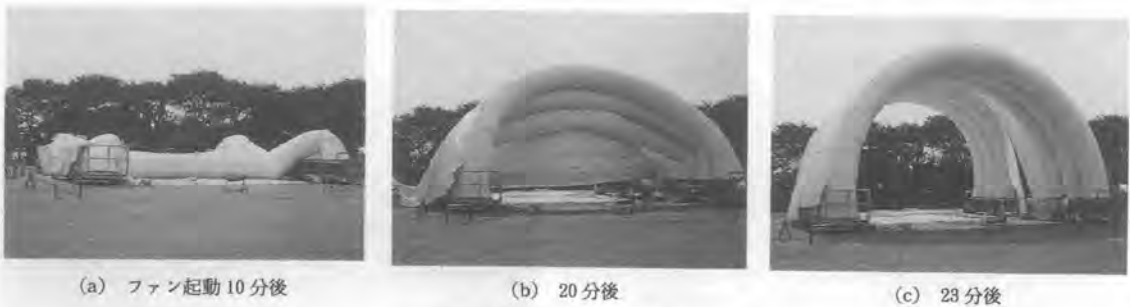
写真-4 エアアップ状況
