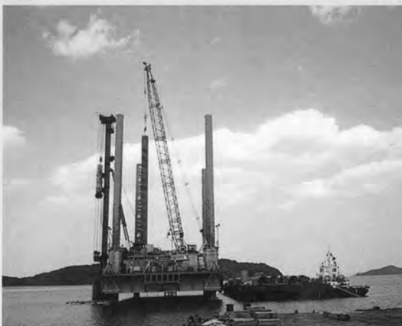
◀ 揚炭棧橋工事 自航昇降式作業台船による鋼管杭施工状況
