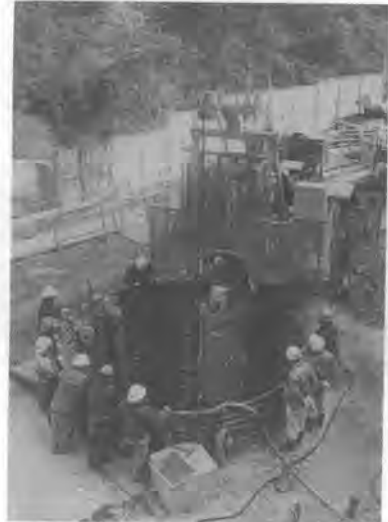
写真-10 三井三池製作・深礎杭用小型移動式エレベータ(清水建設共同開発)
