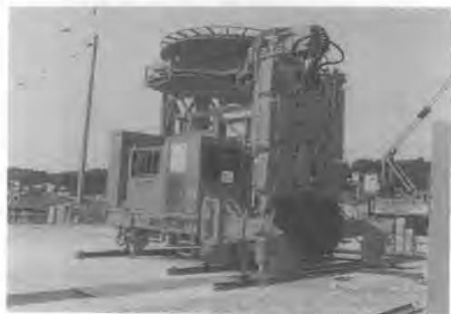
写真-13 利根 BMX-120 地中連続壁掘削機
