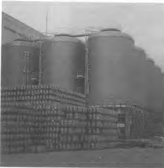
写真—6 ビールタンク
