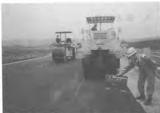
写真-4 ネッパラン W (5倍) の使用現場
