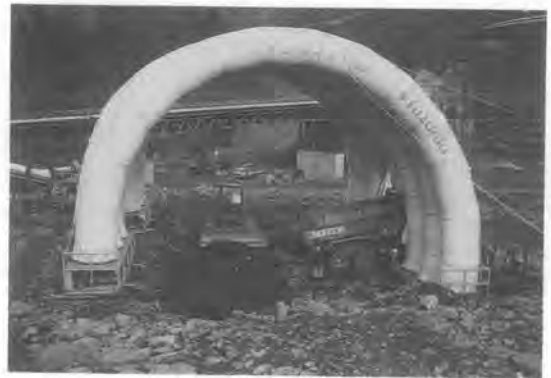
写真-5 現場実験状況
