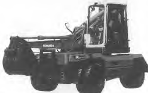
写真-6 コマツ PW 128 UU 1 「アーバンギヤ128」油圧ショベル
