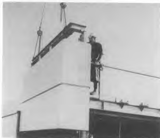
写真-3 ユニット式カーテンウォール取付状況
