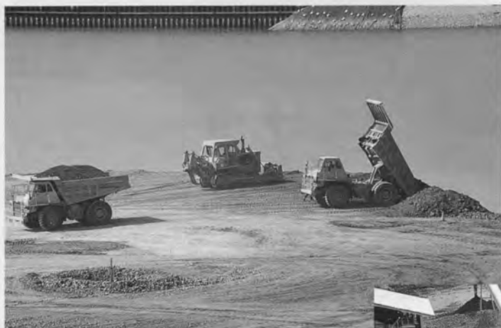
⇨ 敷地造成工事施工状況
