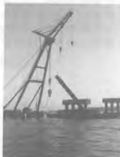
杭切断後の撤去
