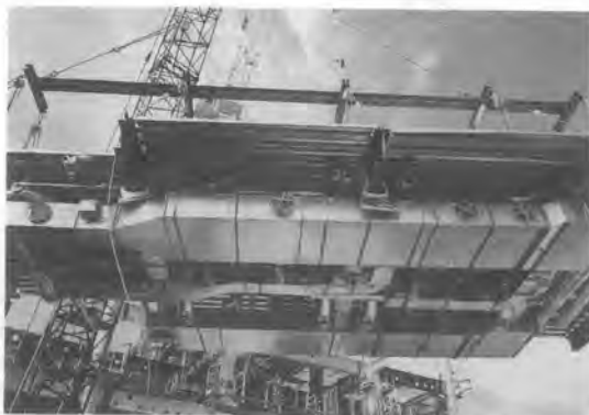
写真-2 床デッキと設備配管のフロアパネル
