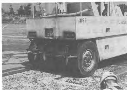
写真-7 ネッパラン S の使用現場
