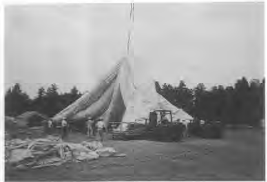
写真-3 膜材の吊上げ・台車の寄せ
