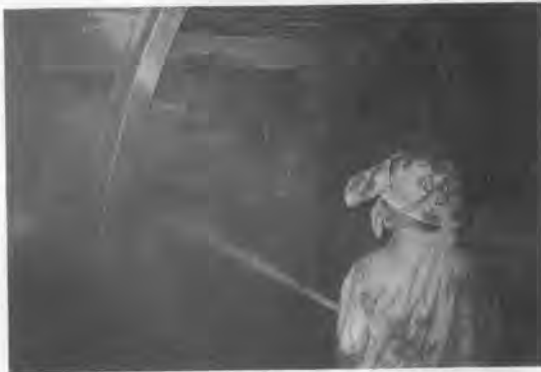
図-7 吹付け施工状況
