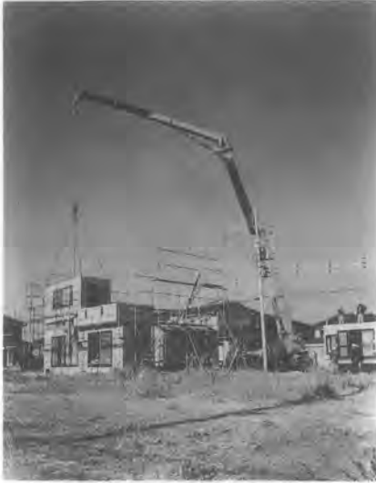
写真-9 コマツ LT 500 U 1 「ピタゴラス」リーチタワークレーン
