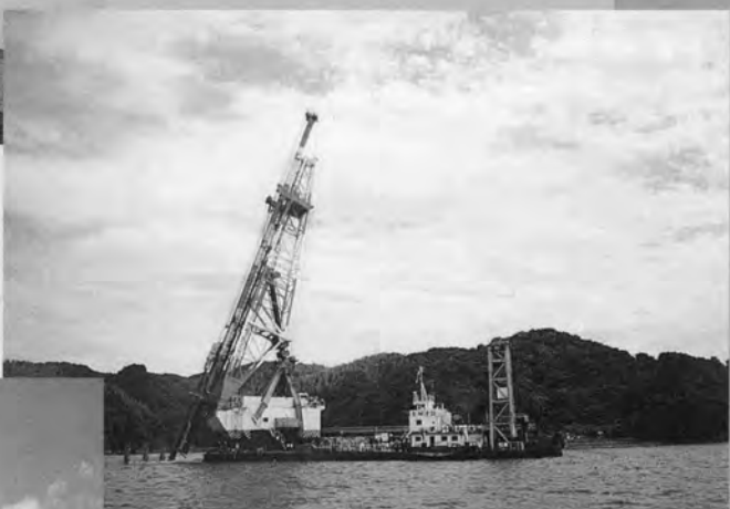
◀ 揚炭棧橋工事 旋回杭打船による鋼管杭施工状況
