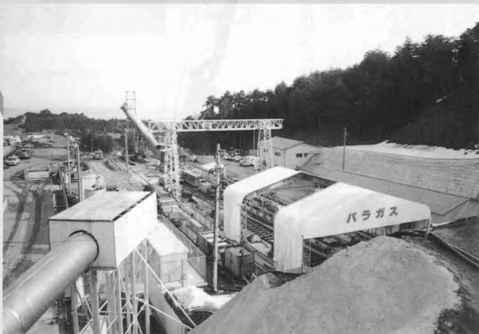
⇨ 城端トンネル避難坑仮設ヤード全景
