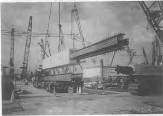
写真—1 構真柱の搬入状況と地下施工状況
