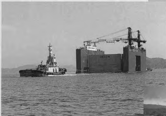
◀ フローティングドックによる 護岸用ケーソンの輸送状況
