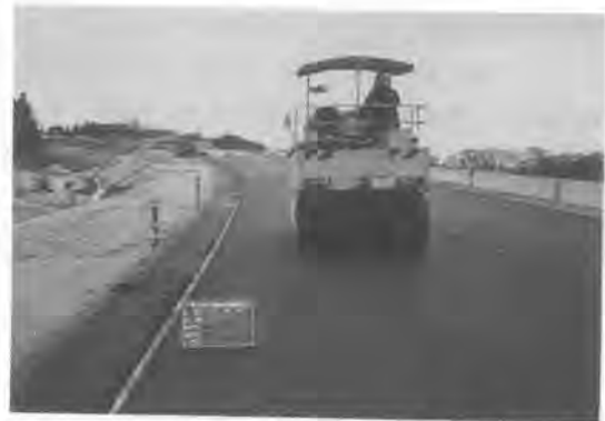
写真一3 ネッパランW (100倍) の使用現場
