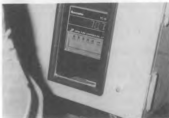
写真-4 デジタル計による回転油量表示
