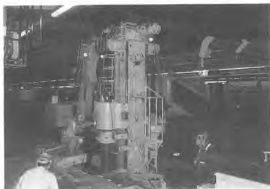
写真-3 施工状況
