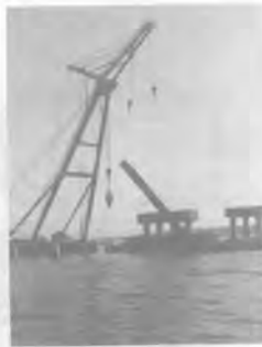
杭切断後の撤去
