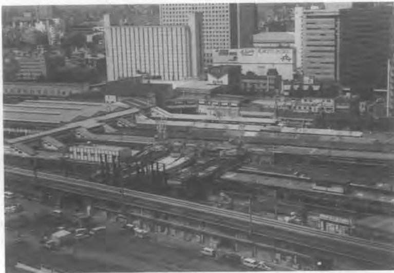
写真-1 施工状況の全景
