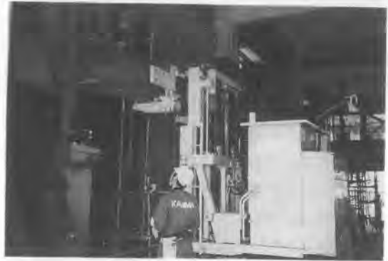
写真-3 S梁の取付状況
