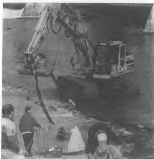
写真—1 擁壁 (ダム) 前面の浅床部でダイバを支援するショベルドレヅジャ
