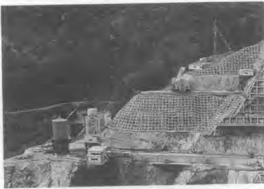
写真—2 左岸天端の仮設備
