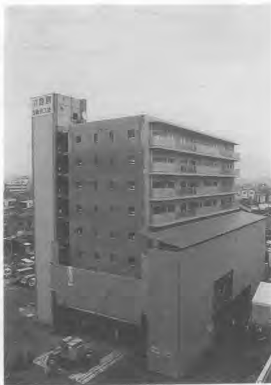
写真-1 施工状況
