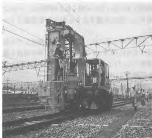
写真-4 機械搬出状況
