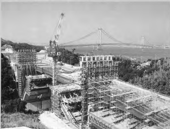
⇩ 施工中の茶間川橋全景 (向う側が明石海峡大橋)
