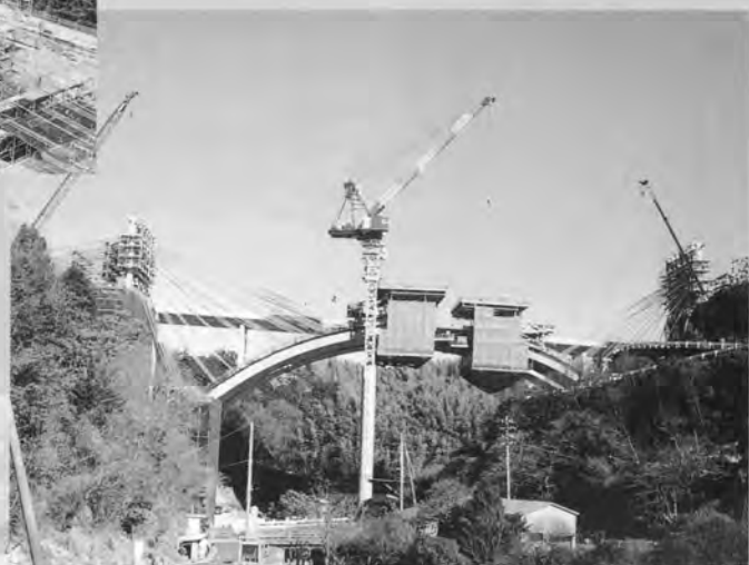
⇩ ピロン工法による施工
