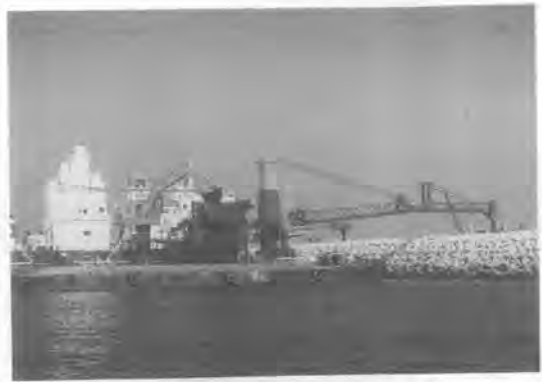
写真-4 四日市港埋立工事稼働状況
