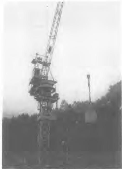
写真—2 ずり出し作業
