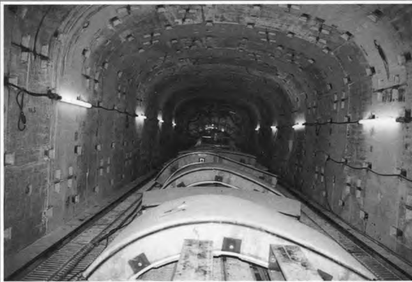
⇨ 坑内上半の一次覆工
