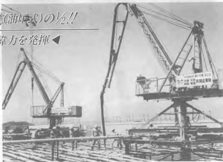
(本四架橋現場設置例)
