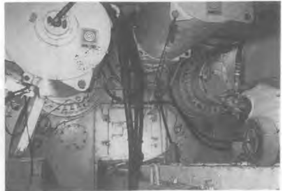
写真—3 TBM，油圧シリンダ部と中央マンホール
