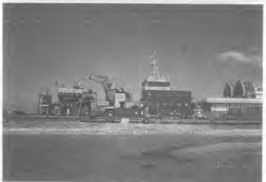
写真-3 圧送船全景
