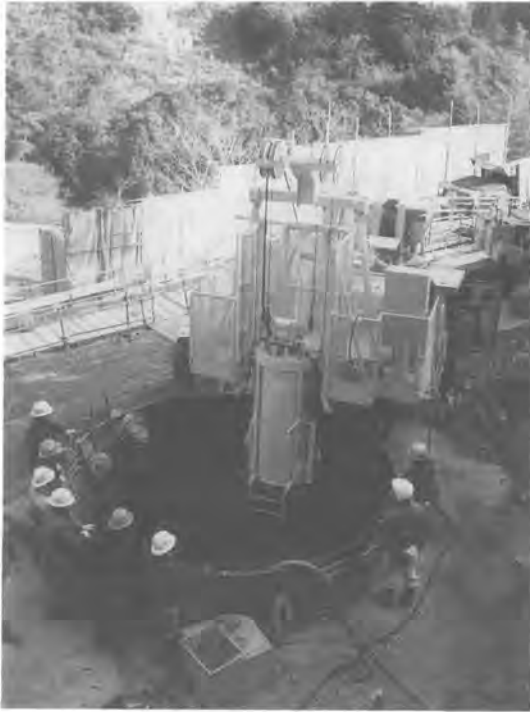
写真-2 小型移動式エレベータ使用状況
