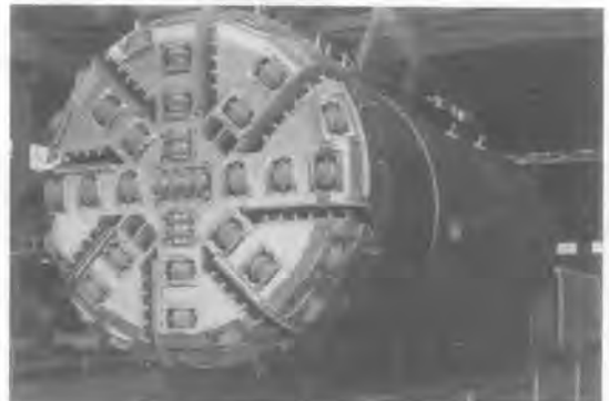
写真-1 先進導坑を掘削するTBM
