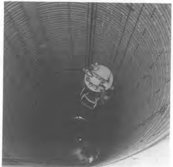
写真-3 小型移動式エレベータ使用状況
