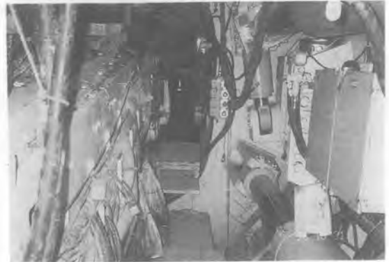
写真—4 TBM掘進機内部の油圧シリンダと電設機器
