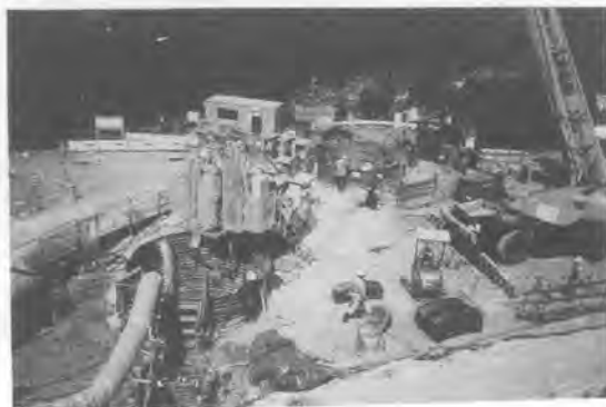
写真-1 現場状況
