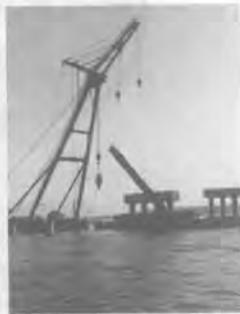
杭切断後の撤去
