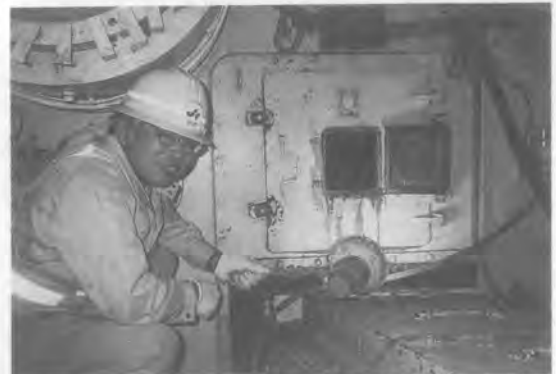
写真—5 TBMの開閉部，チャンバ内の状況，ローラビットの交換等を行う
