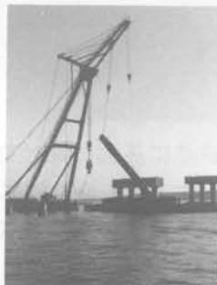
杭切断後の撤去
