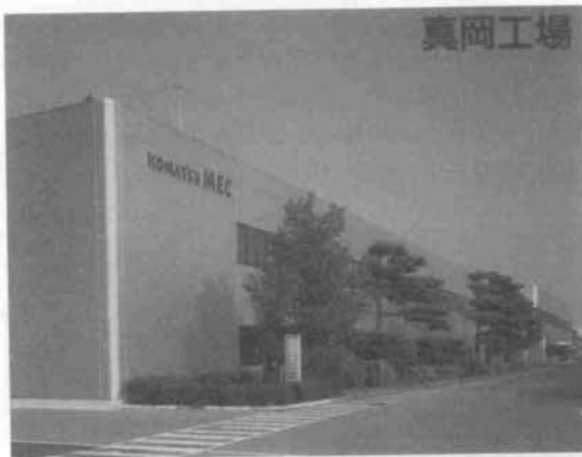
写真—8 真岡工場
