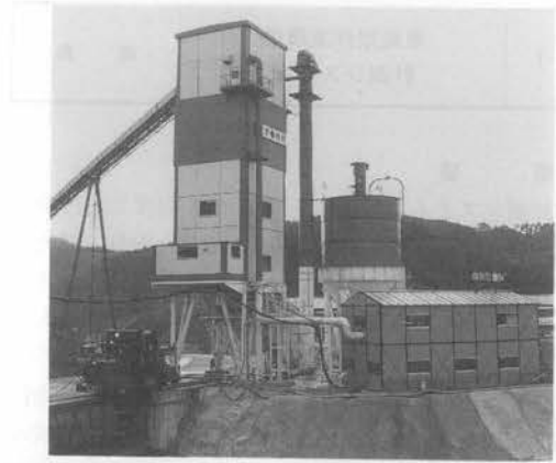
写真-1 バッチャープラント搭載型真空冷却システム設置状況(上津ダム)
