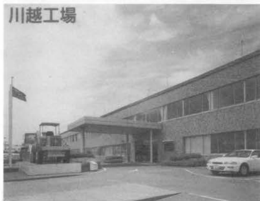
写真—3 川越工場
