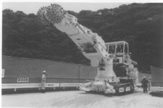
写真1 自由断面掘削機の全望
