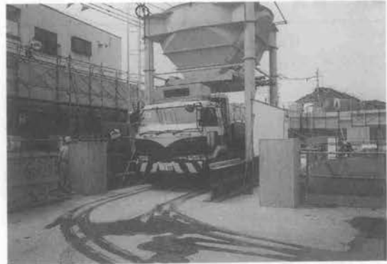
写真2 土砂積み込み状況
