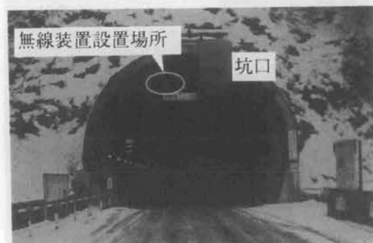
写真-2 坑口付近無線装置設置場所
