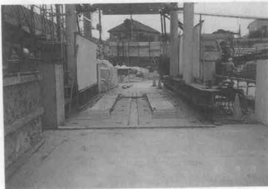
写真1 計量装置設置状況
