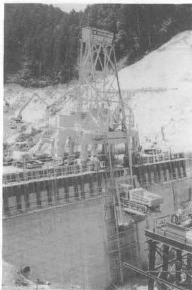
写真-1 施工状況(バケット上に車両搭載時)
