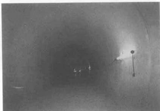
写真-2 施工完了
