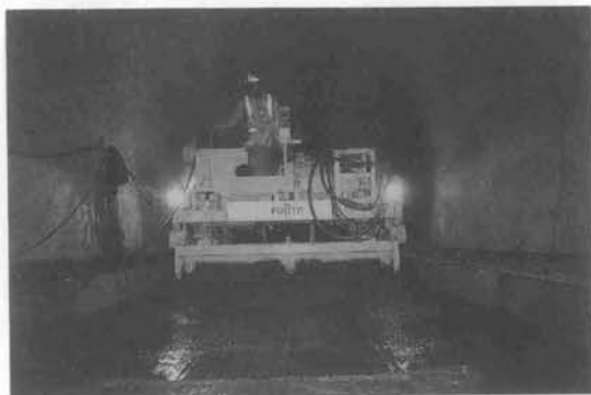
写真-1 施工状況
