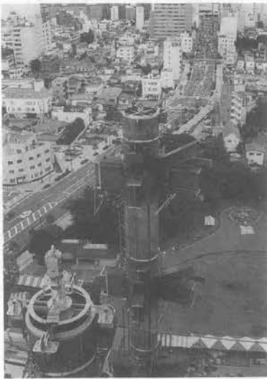
写真—3 基準柱と測定柱
