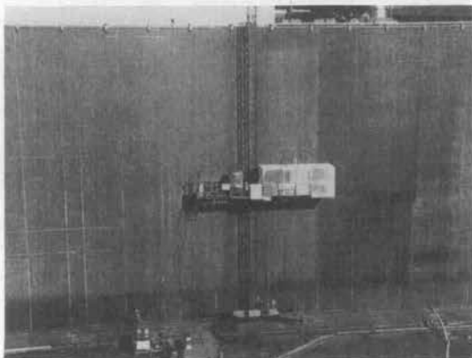
写真-1 マスト昇降式塗装ロボットの実証実験状況
