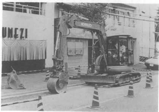
写真13 神戸・管路埋設工事用転圧ローラ装置
