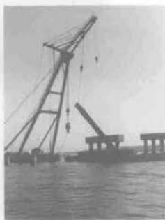
杭切断後の撤去
