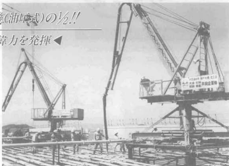
(本四架橋現場設置例)
