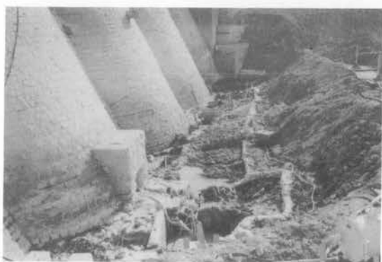
写真一 上流側の仕上げ掘削, 岩盤清掃の状況
