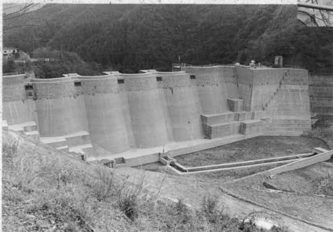
↓上流側の補修工事が完成し、貯水前の状況。
