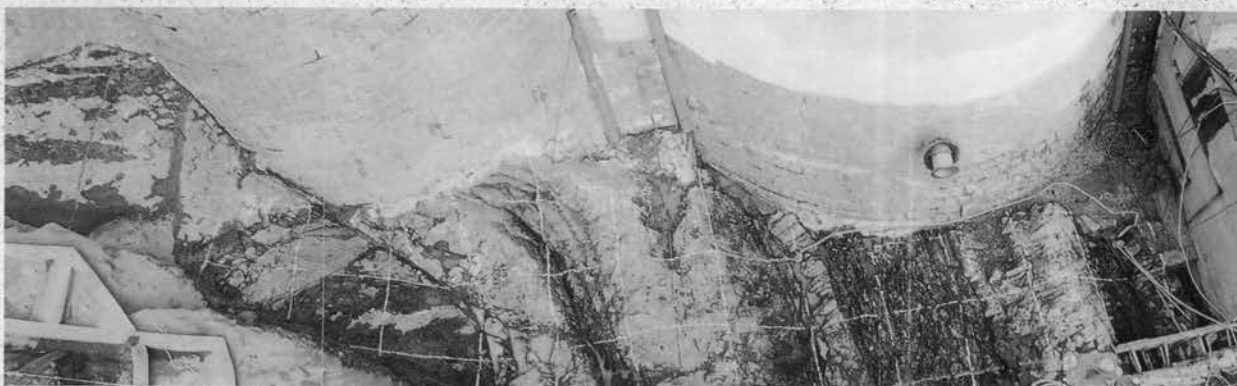
↓堤体上流側の岩盤状況。
