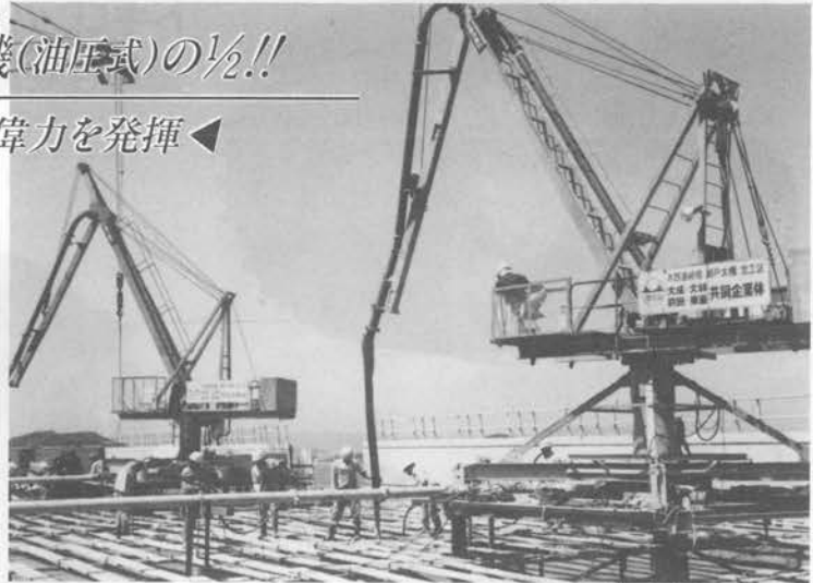
(本四架橋現場設置例)
