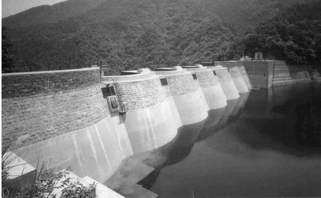
⇧ 補修完成した豊稔池ダムの上流面。
