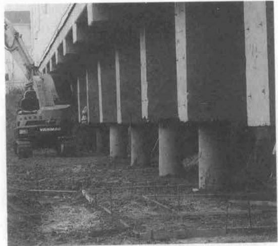
写真-6 掘削状況
