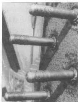
写真-1 鋼材に溶接したスタッド
