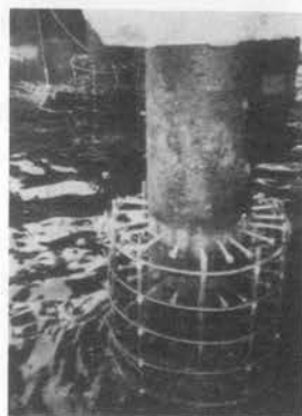
写真-2 被覆コンクリートの施工状況
