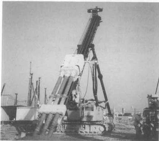
写真-1 斜め SMW 実験施工状況
