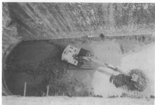
写真二 下流側のバットレス間の掘削状況
