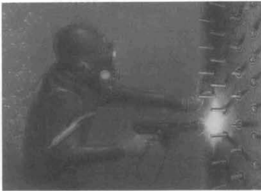
写真-3 水中スタッド溶接状況
