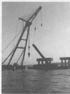
杭切断後の撤去
