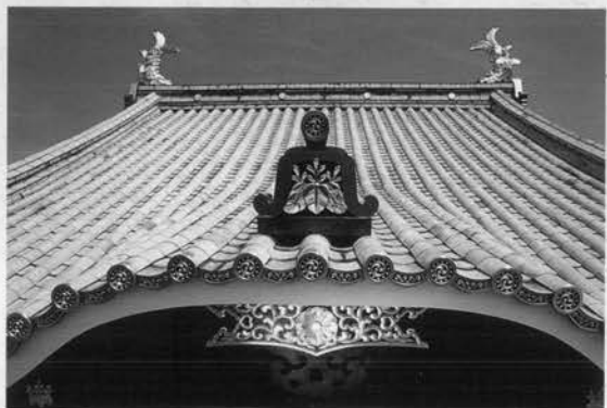
↑9※改修後の大屋根 (銅板瓦は, 再使用している)
