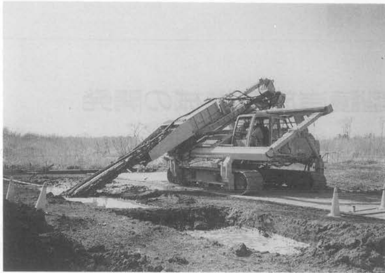
写真-1 施工の状況
