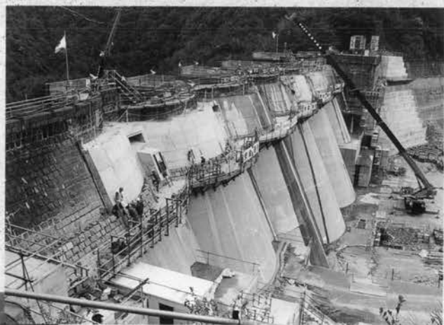
↑アーチ部コンクリート打設が完了し、石積み工に着手した状況。
