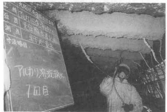
写真-1 電気化学的再アルカリ化工法
