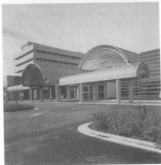
写真-6 総合病院にもガスエンジンコージェネ、300 kW×2基設置
