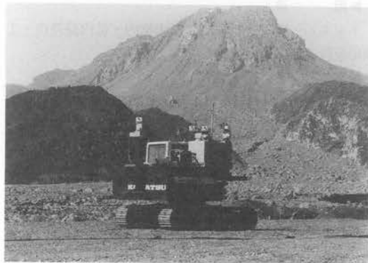
写真—1 中継車を用いた遠隔施工状況
