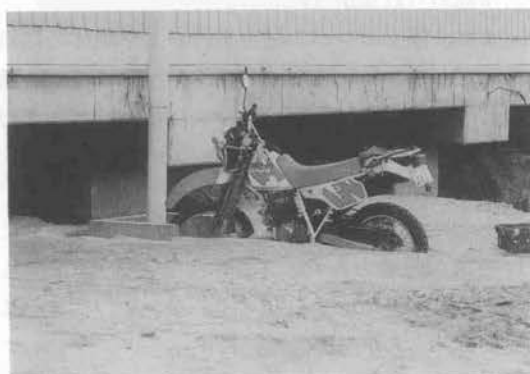
写真-2 震災後の周辺地盤
