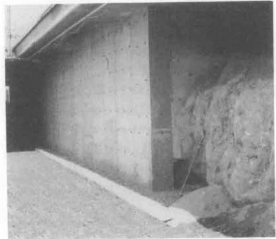
写真-7 スカートウォール外観
