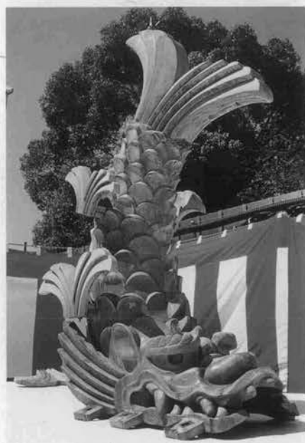
↑4 ※改修前の鯰 （青銅鑄物から緑青が発生している）
