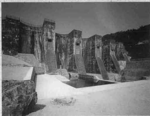
⇩ 補修完成した豊稔池ダムの下流面。
