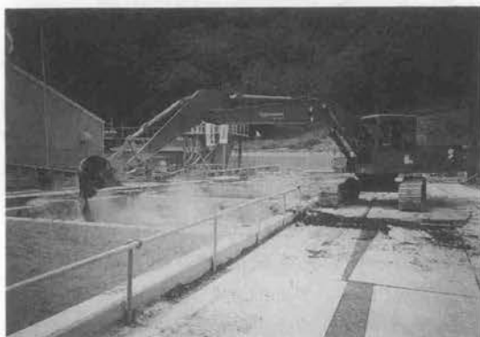
写真-2 固化処理状況
