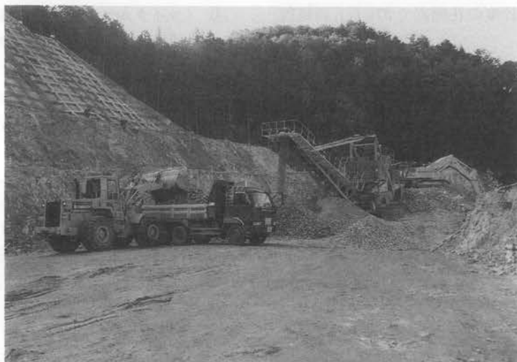
写真—1 クローラクラッシャの破碎作業および積み込み状況
