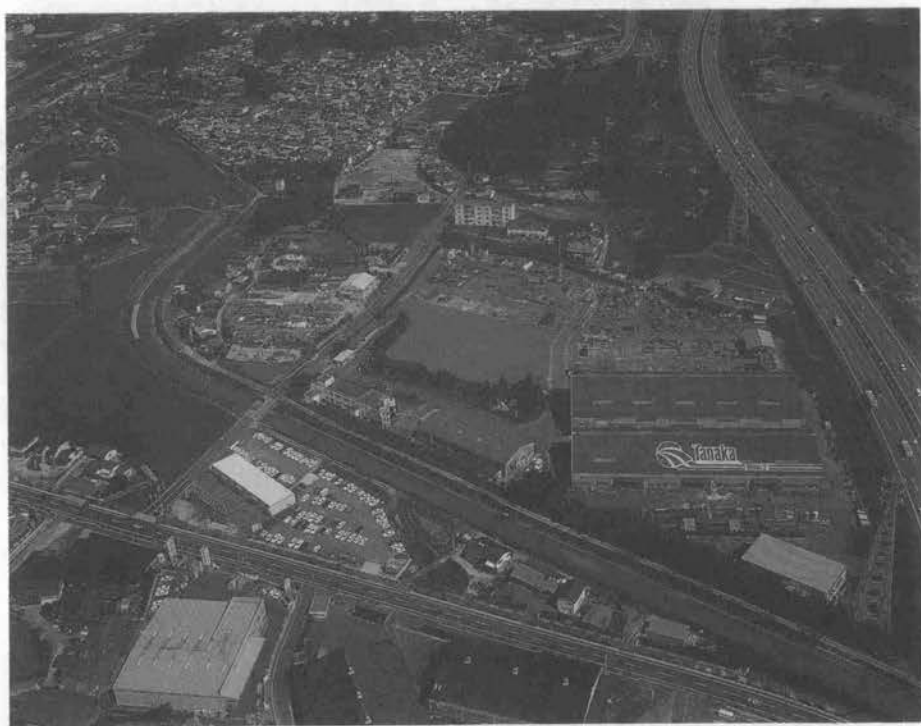
写真-1 田中鉄工・本社工場全景
