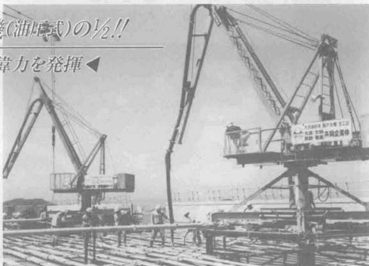
(本四架橋現場設置例)
