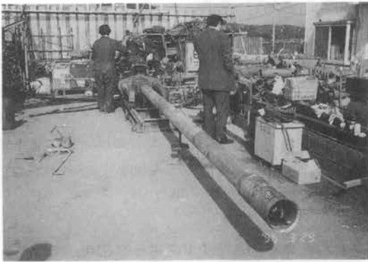
写真—3 一次ボーリング機仮組状況
