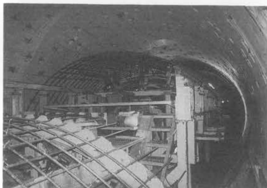
写真-1 施工状況
