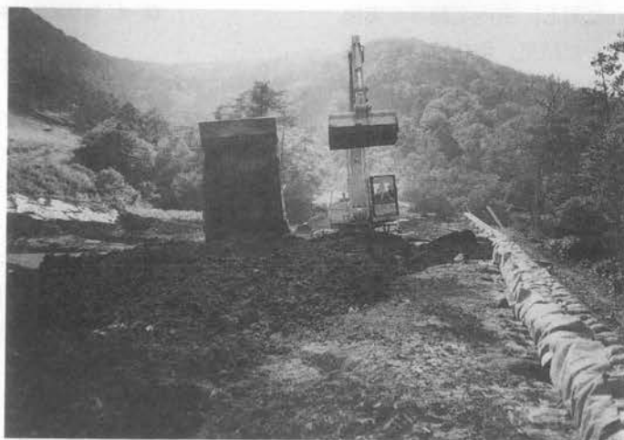
写真-3 固化土盛土状況
