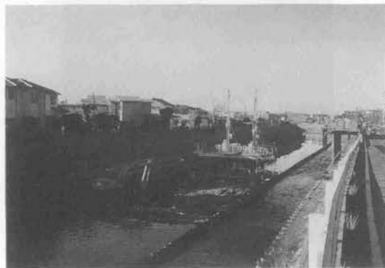
写真-2 施工状況写真
