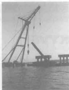
杭切断後の撤去
