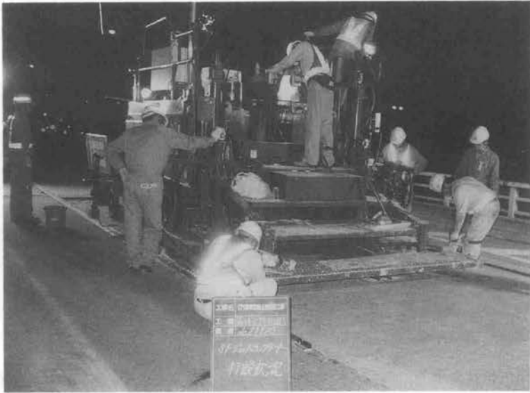
写真-2 甲武橋施工状況
