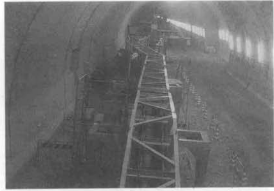
写真-2 実証機の平面曲走状況
