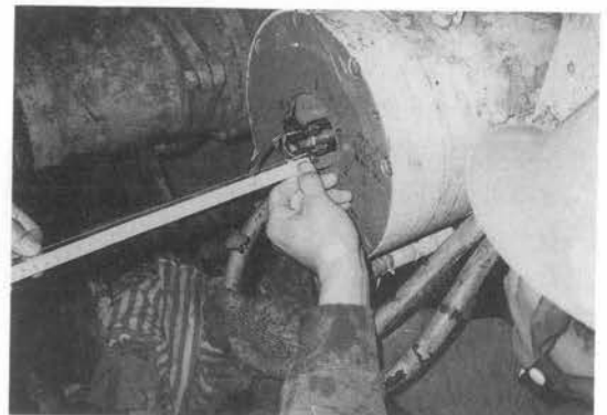
写真—6 スライドスポークの縮み量をワイヤで確認
