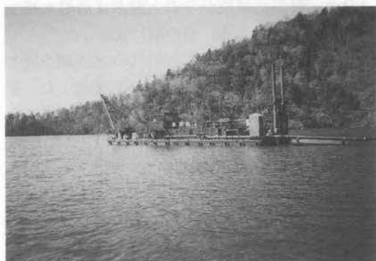
写真-1 浚渫状況
