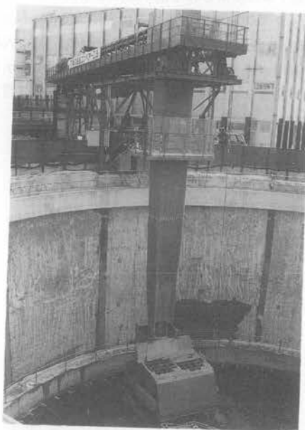
写真-1 施工状況
