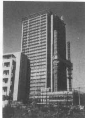
屋根架構解体、逆クライミング
