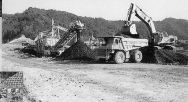
↑砕岩、積込み作業状況 (大型自走式クラッシャ設備による 砕岩とバックホウによる積込み作業状況)
