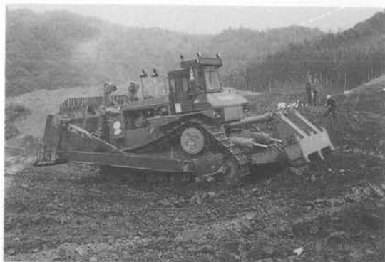
写真-1 D11 によるリッピング状況
