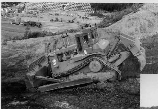
↑切土作業状況 (100t級ブルドーザ)
