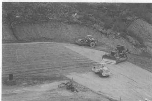
写真-3 振動ローラによる締固め作業状況
