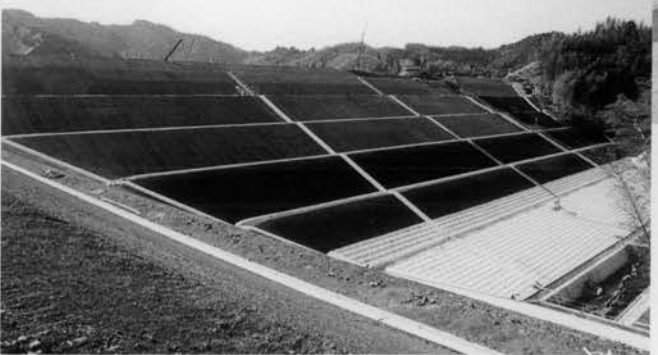
↑盛土法面施工状況
