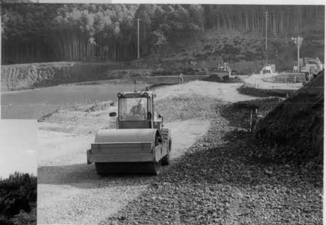
↑盛土作業状況 (起振力30t級振動ローラによる 岩砕材料の締固め作業状況)
