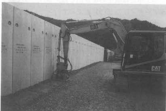
写真-4 油圧プレートコンパクタによる締固め作業状況
