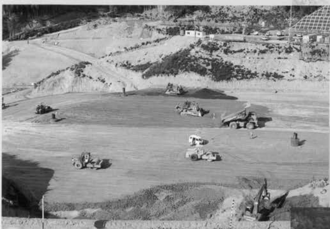
↑盛土作業状況
