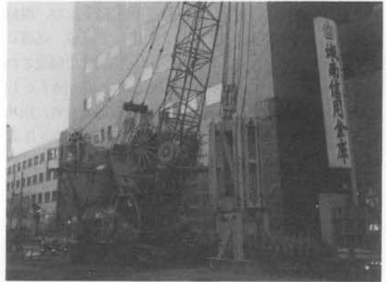
写真一 ツインカッター拡翼式掘削機 (SATT機)
