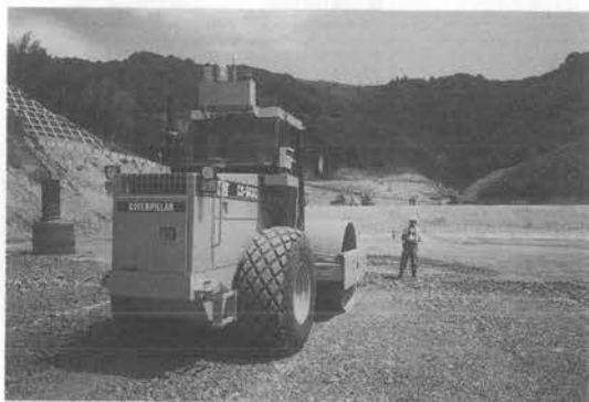
写真-5 ラジコン振動ローラの試験施工状況
