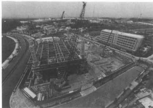
仮設屋根架構の組立
