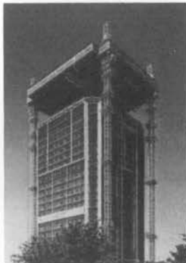
躯体、設備、仕上工事
