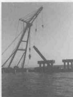
杭切断後の撤去
