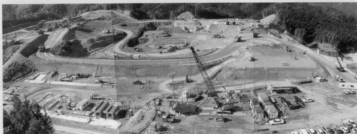
↑ 工事施工状況
