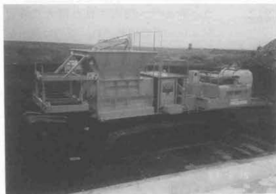
写真—5 HR 1200 SG の稼働現場
