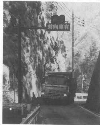
写真-1 交互運行管理システム作動状況
