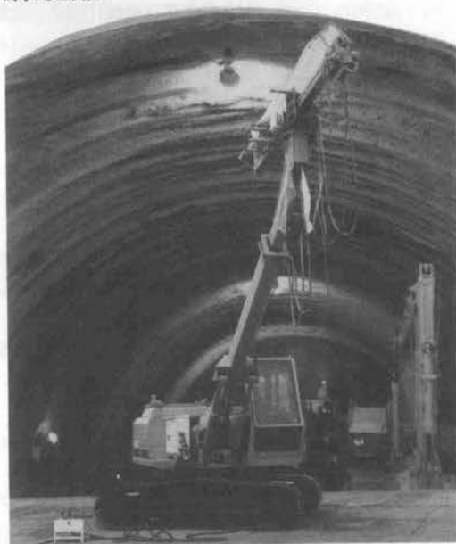
写真—6 吹付けロボット
