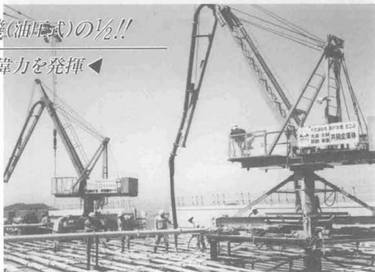
(本四架橋現場設置例)
