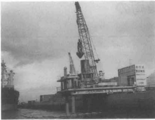
写真一七 置換掘削状況
