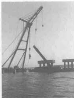
杭切断後の撤去
