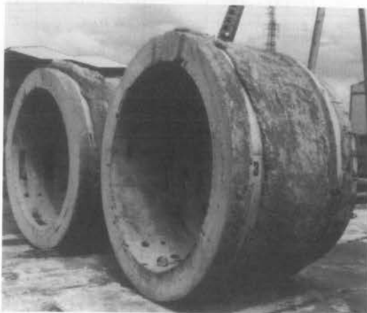
写真—2 覆工体の状況
