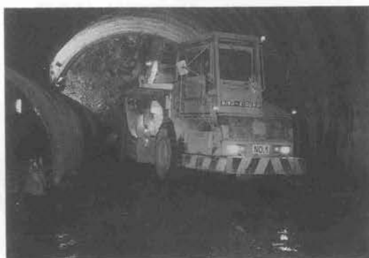
写真-3 ミワ・キルナのずり運搬 (多機能ベッセル式重ダンプトラック)
