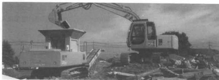
写真—1 HR 1000 の稼動状況
