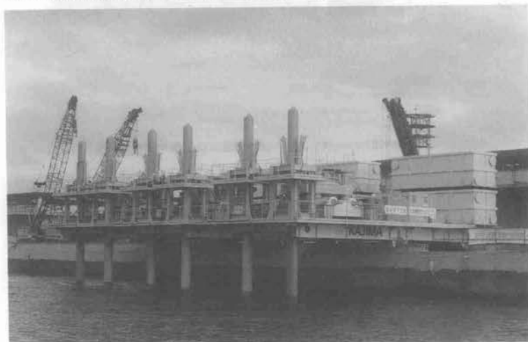
写真-1 走行式張出架台
