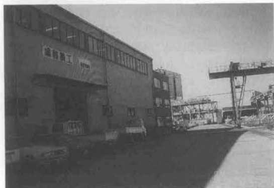
写真-2 成和機工事務所
