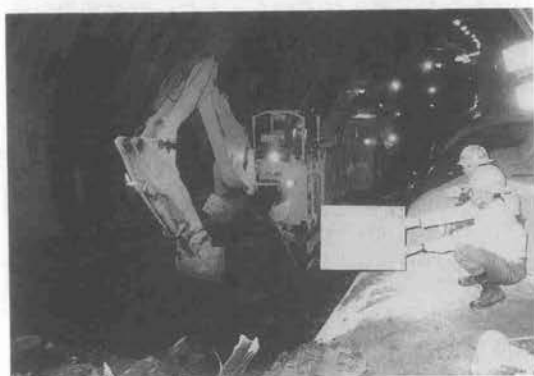
写真-2 シャフローダによる積込み (全断面对応型ずり積込み機)
