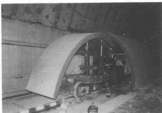
写真-1 移動式防護工施工状況
