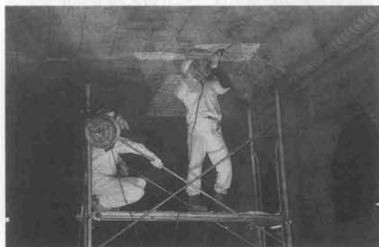
写真-1 ハンドブレイカによる人力作業
