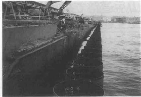
写真一八 鋼管矢板打設完了
