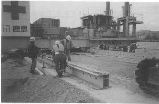
写真-2 レール設置状況
