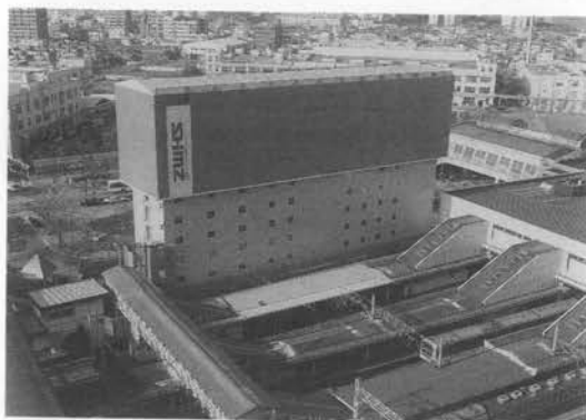
写真-1 「スマートシステム '96」により、JR南武線の運行中も安全に施工している「ホテルメッツ川崎」の外観
