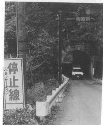
写真-2 交互運行管理システム作動状況
